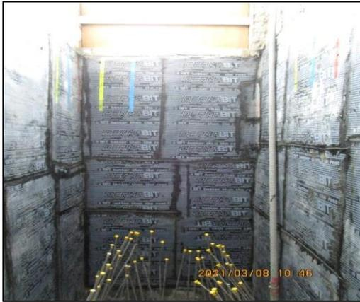
圖 32 被覆防水毯外層 PE 板
