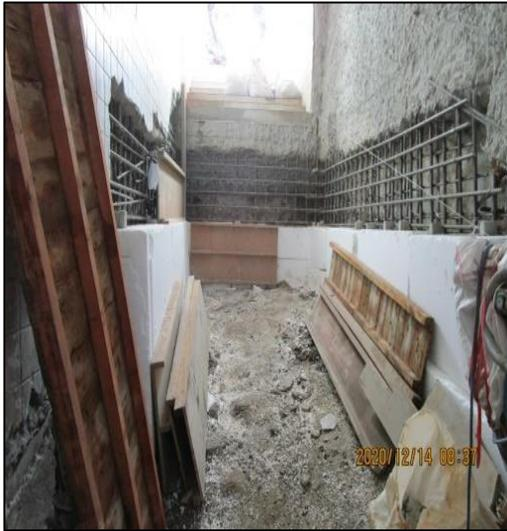
圖 24 預留與第 2 層鋼筋續接器接合
