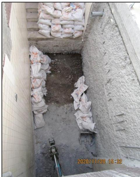
圖 20 挖除樓梯結構以下回填土層
