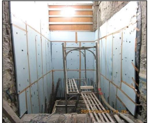
圖 33 內撐牆鋼筋綁紮
