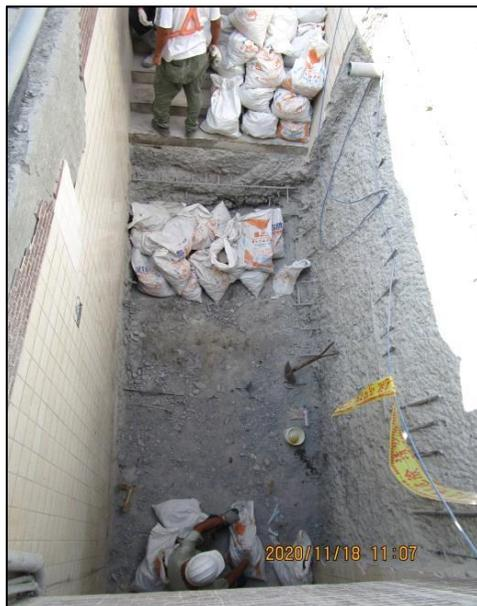
圖 18 機械鑿破樓梯結構
