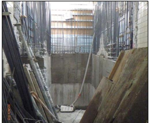
圖 35 內撐牆昇牆至月台面
