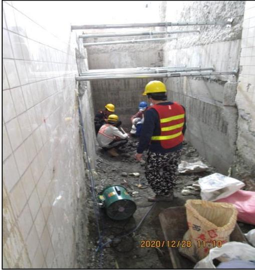
圖 28 機坑基礎層挖除
