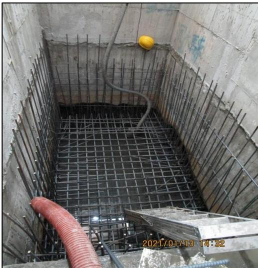
圖 30 完成機坑結構施作並調整內擋牆預留鋼筋
