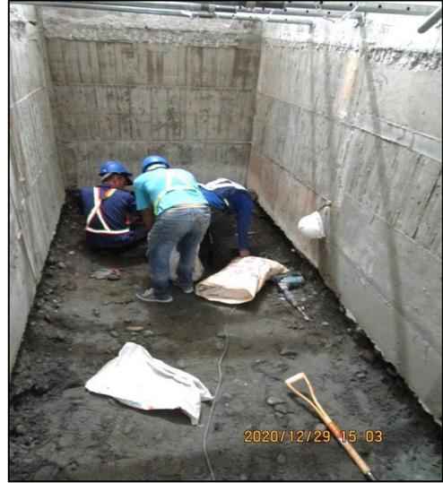
內擋牆結構部份於外擋牆完成後接續開挖基礎部份約 70 公分並施作基礎結構（如圖 26~27）及施作牆面防水處理作業（如圖 28~29），完成基礎結構澆置後依序由下往上構築內擋牆結構至月台面以上 45 公分（如圖 30~31），同時完成電梯昇降道鋼構架基礎螺栓埋設，即完成月台工區電梯昇降道結構施作。
