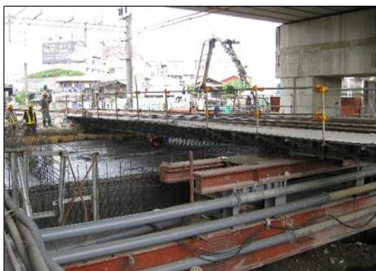
照片 34 北側箱涵施工
