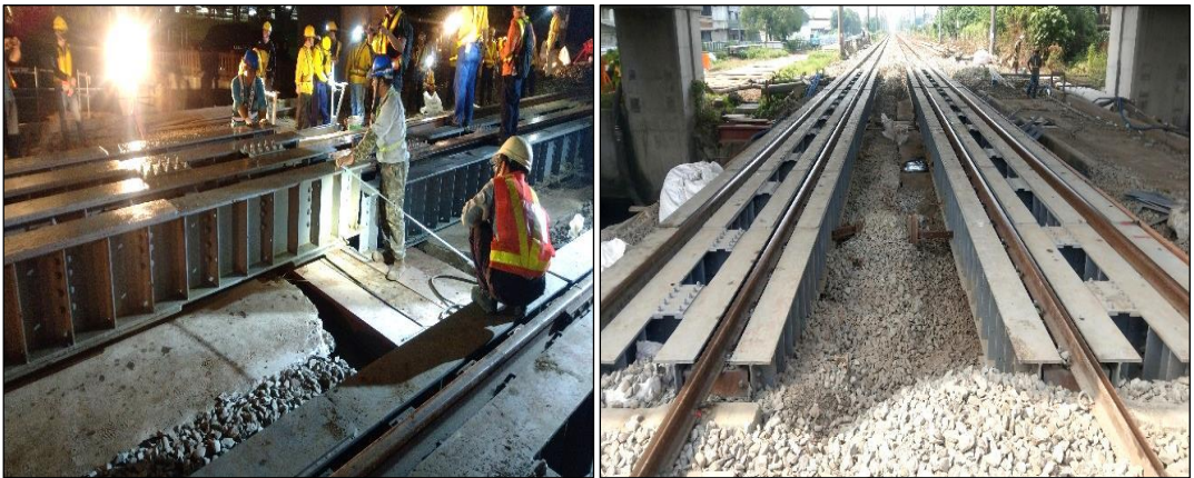
照片 61、照片 62 吊放工程梁、調整位置、高程與固定，鋪設臨時軌道
