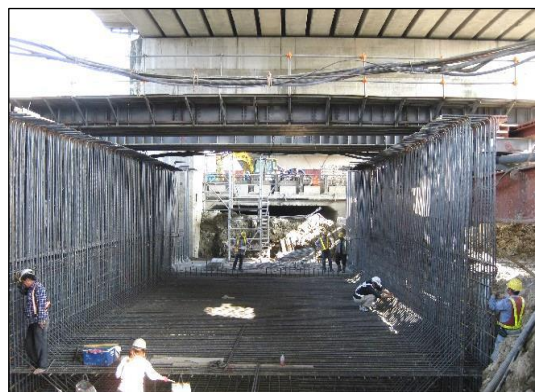
照片 32 北側箱涵施工
