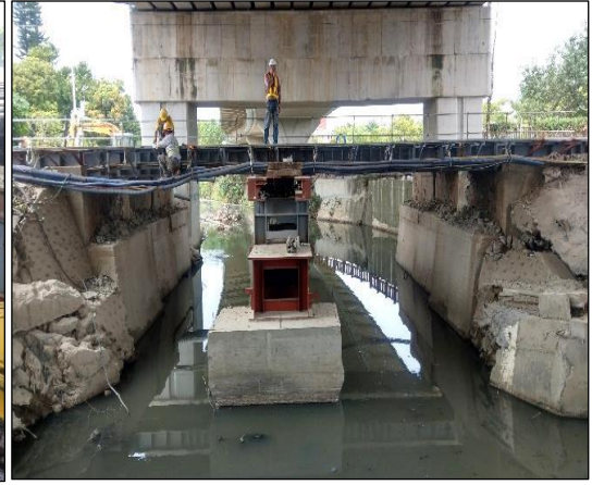
照片 27 舊 RC-T 梁混凝土打除完成
