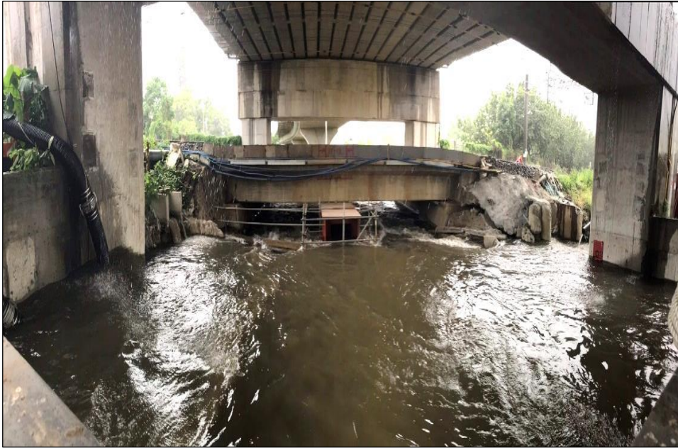
照片 4 番仔溝橋改建前遇強降雨水位上升，至橋下通水斷面束縮，排水受阻。 （照片為中央排水上游往下游方向拍攝）
