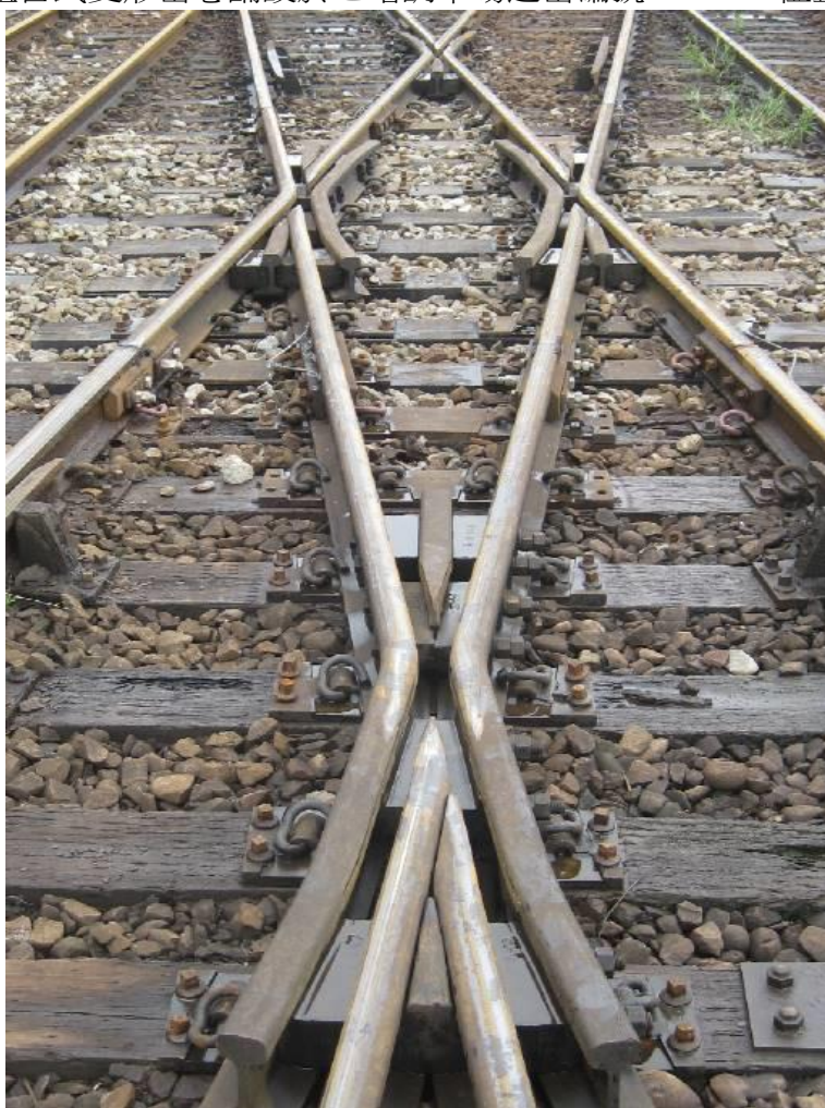
圖 28、#8 組合式菱形岔心鋪設於七堵調車場道岔編號 508/507 位置。
