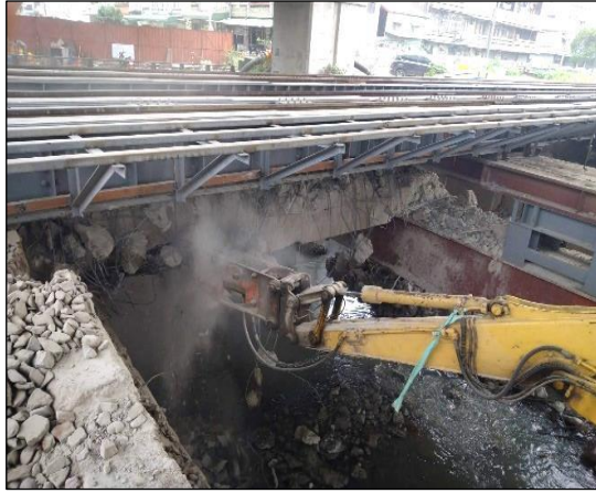
照片 26 舊 RC-T 梁混凝土打除作業
