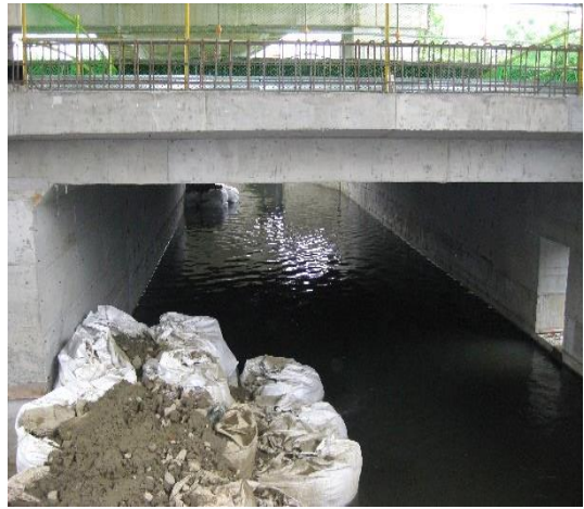
照片 37 北側箱涵施工完成
