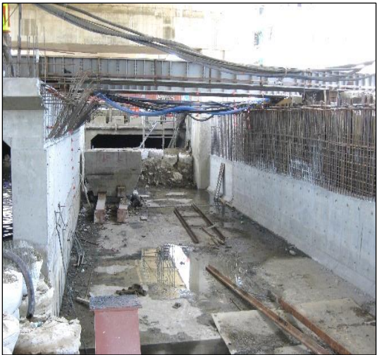
照片 40 支撐鋼橫梁與臨時橋墩拆除
