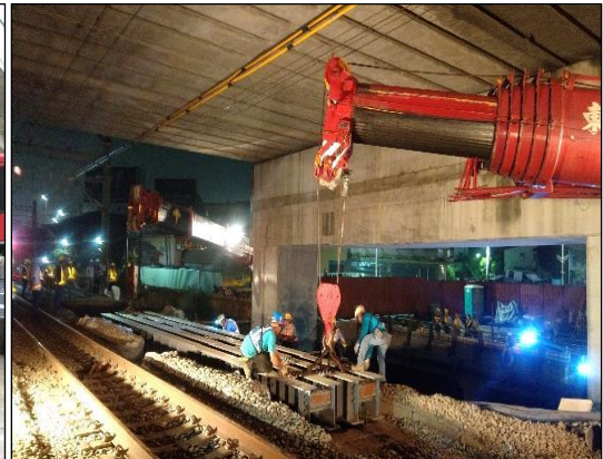
照片 70 垂楊陸橋下有限空間施工
