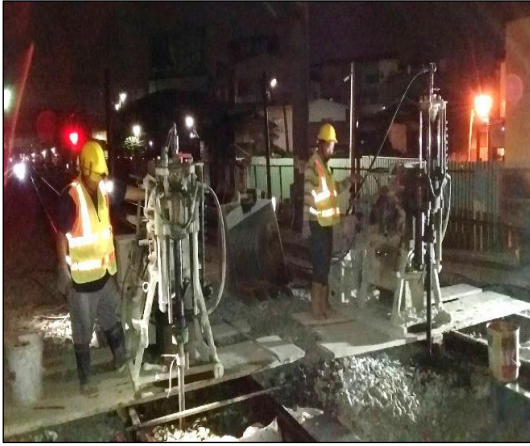
照片 11 軌道路基地質改良與擋土設施
