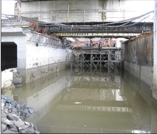
照片 41 南側箱涵施工
