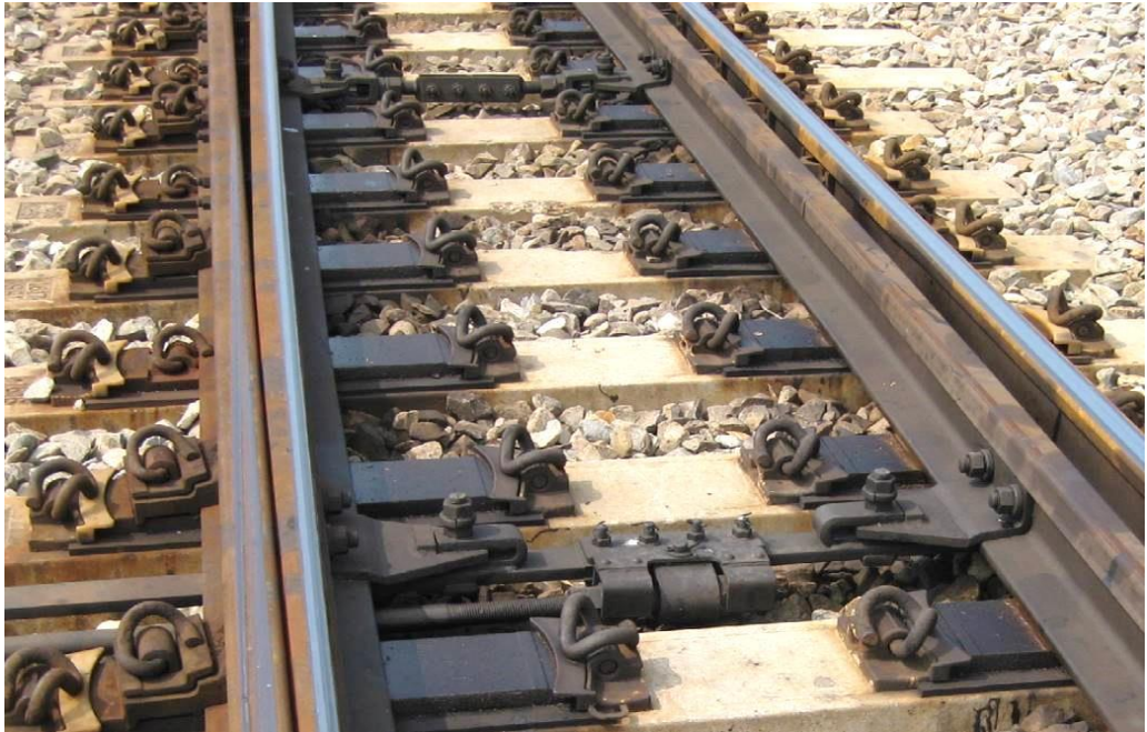
圖 13、日本 YAMATO 公司的 PC 枕道岔。
