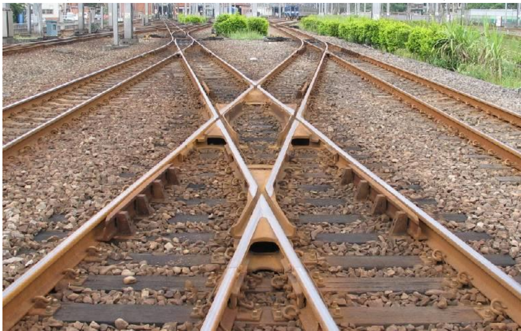
圖 8、七堵車站第三月台北側剪型道岔，道岔編號編號 119/121，仍使用木枕。
