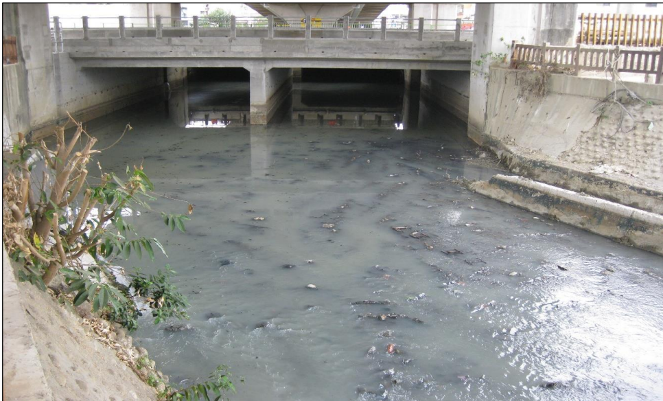
照片 48 主體工程 RC 箱涵施工完成
