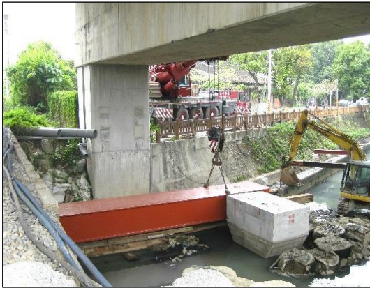
照片 67 垂楊陸橋下支撐橫梁吊裝
