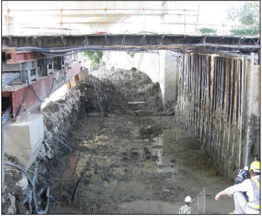
照片 12 軌道路基地質改良與擋土設施
