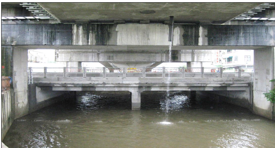
照片 15 新建 RC 箱涵現況
