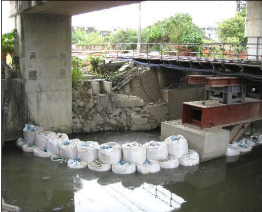
照片 13 軌道路基地質改良與擋土設施
