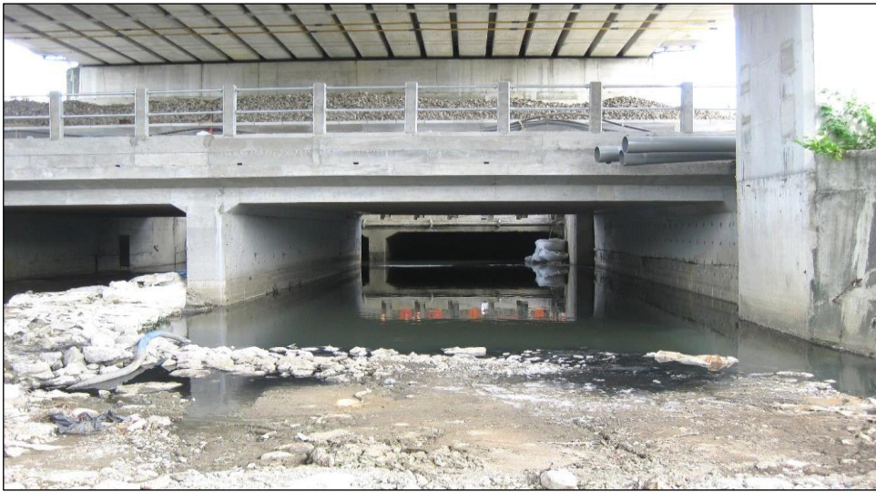
照片 43 南側箱涵施工完成
