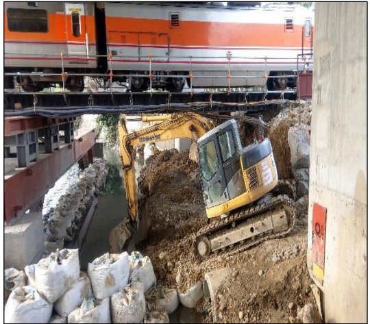
照片 28 工區圍堰施工
