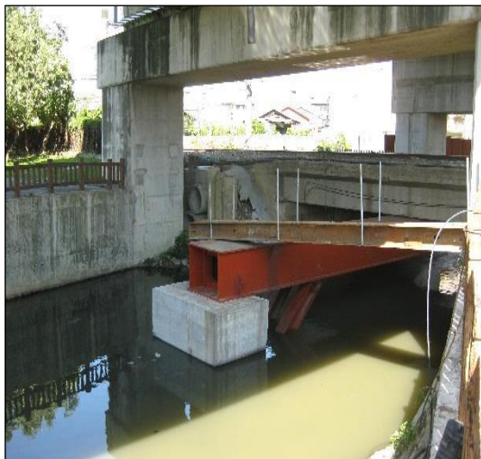
照片 71 平日工區河道水位
