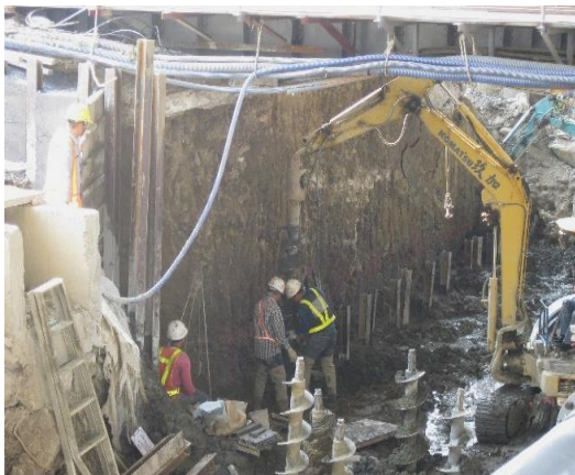
照片 31 開挖面微型樁擋土施工
