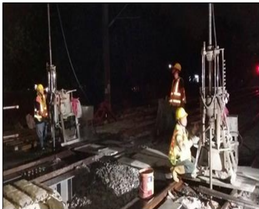
照片 30 工區路基地質改良施工
