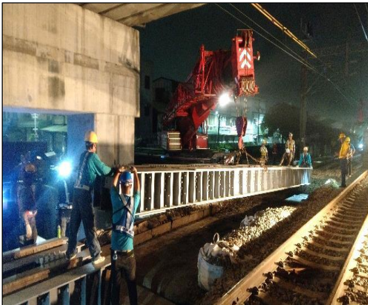
照片 57、照片 58 吊放工程梁、調整位置、高程與固定，鋪設臨時軌道
