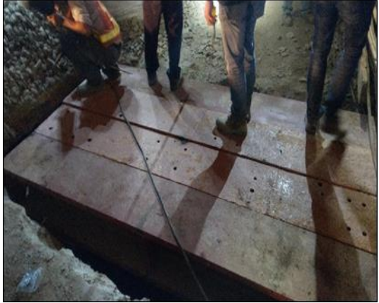
照片 57、照片 58 吊放工程梁、調整位置、高程與固定，鋪設臨時軌道
