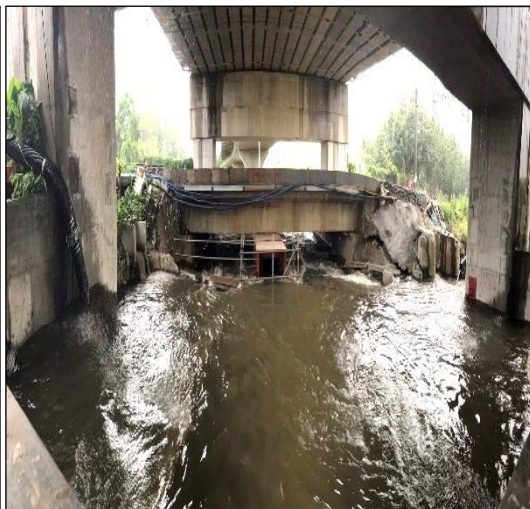
照片 72 上游降雨時工區河道水位
