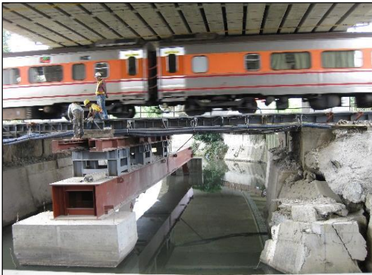
照片 9 14M 工程梁架設
