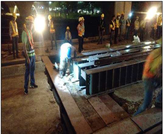
照片 57、照片 58 吊放工程梁、調整位置、高程與固定，鋪設臨時軌道
