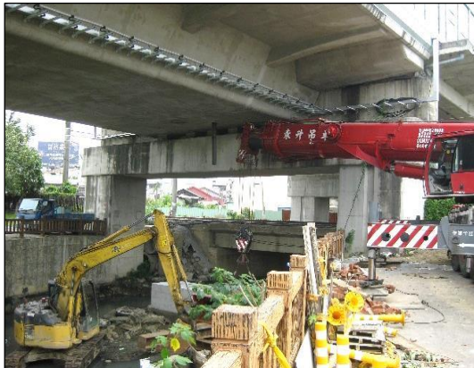
照片 69 垂楊陸橋下有限空間施工
