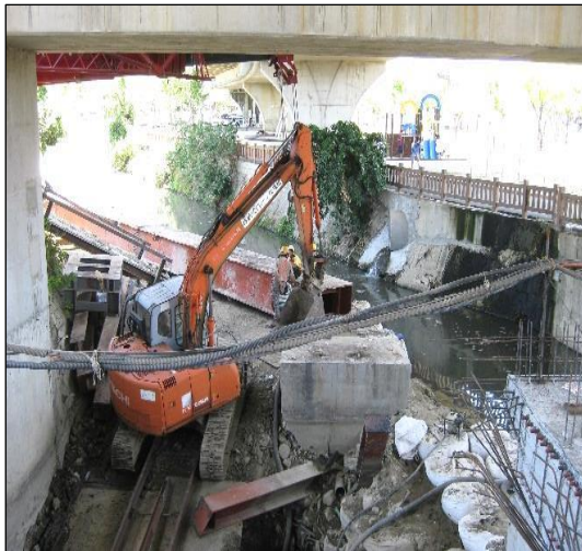
照片 39 支撐鋼橫梁與臨時橋墩拆除
