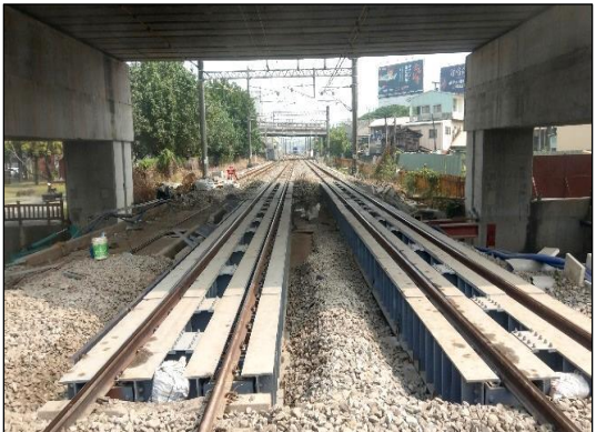
照片 10 14M 工程梁架設（東、西正線）
