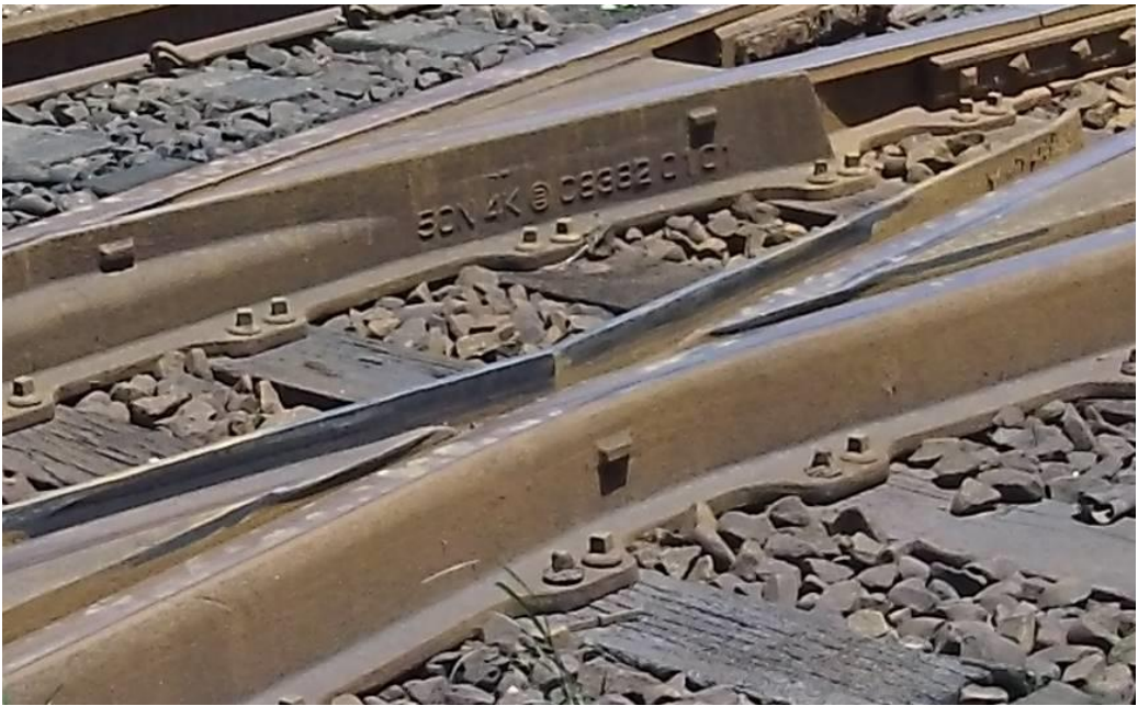
圖 10、七堵調車廠編號 717/718 剪型道岔之 K 形岔心。
