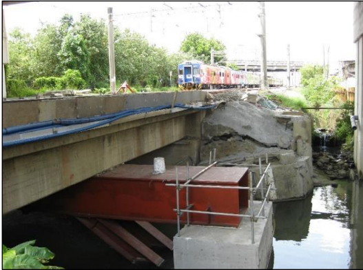
照片 7 臨時支撐鋼橫梁（東西向）
