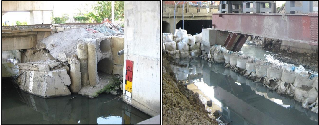
照片 75 埋設 RCP 排洪管增加通水斷面 照片 76 河道圍堰施工
