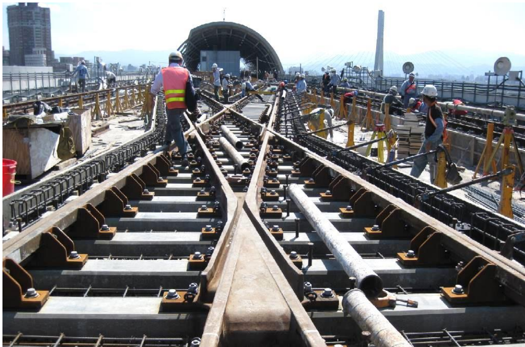
圖 9、機場捷運三重站剪型道岔施工情形，採用 PC 枕。
