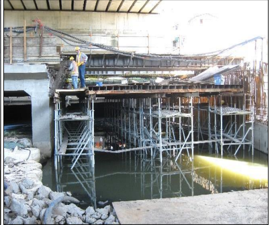
照片 42 南側箱涵施工
