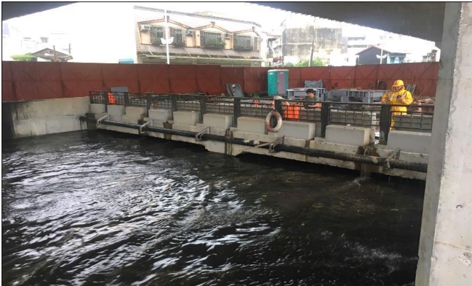
照片 5 番仔溝橋改建前遇強降雨水位上升，排水受阻回堵中央排水。 （照片為舊番仔溝橋往中央排水上游加蓋段方向拍攝）
