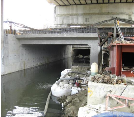
照片 36 北側箱涵施工完成
