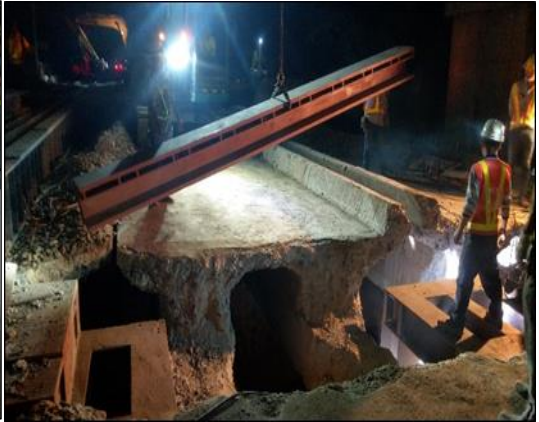
照片 55、照片 56 支撐鋼框與上橫梁吊放、調整高程與固定
