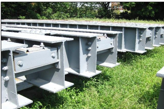
照片 50 14M 工程梁（局供料）
