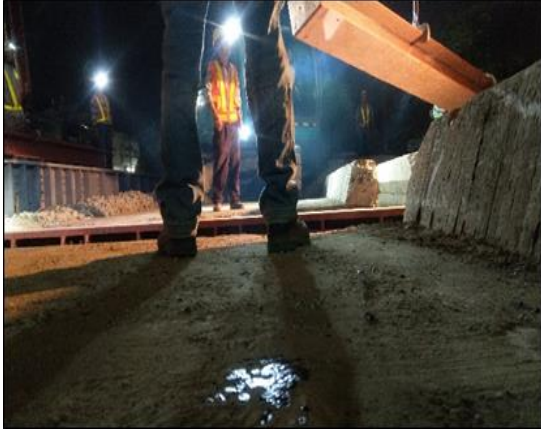
照片 57、照片 58 吊放工程梁、調整位置、高程與固定，鋪設臨時軌道
