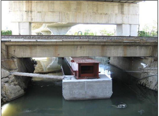
照片 8 臨時支撐鋼橫梁（東西向）
