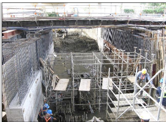
照片 33 北側箱涵施工
