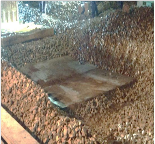
照片 23 枕木垛埋設
