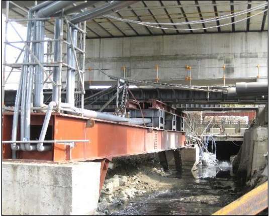
照片 14 軌道路基地質改良與擋土設施
