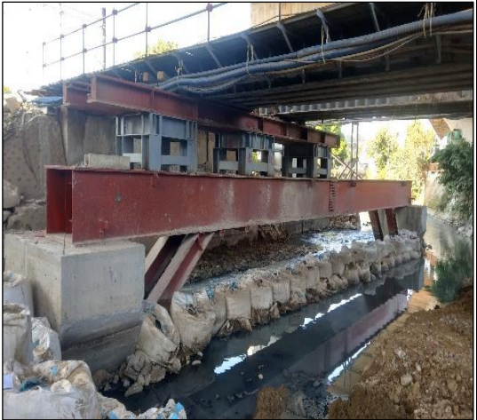
照片 29 工區圍堰施工
