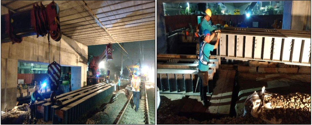
照片 61、照片 62 吊放工程梁、調整位置、高程與固定，鋪設臨時軌道
