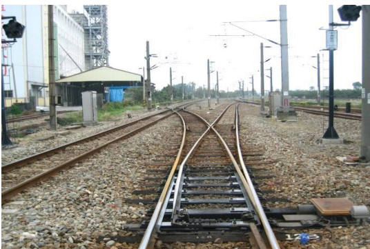
照片 7、不等開道岔-中洲站 12B 道岔
