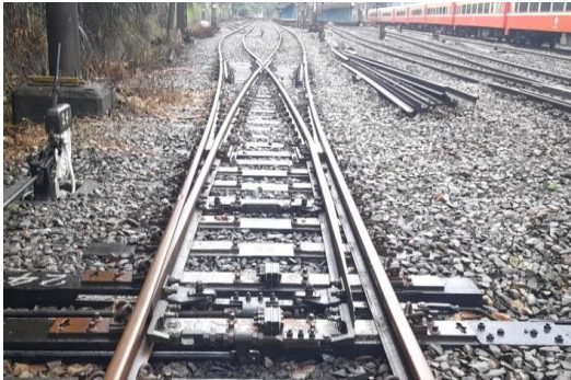
照片 5、#8 雙開道岔-侯硐站 24 號關節式道岔
