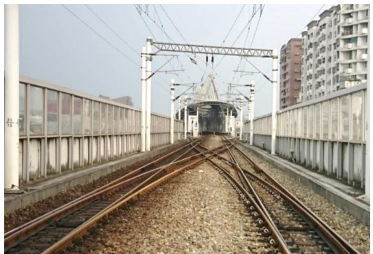
照片 12、剪形道岔-屏東站 11AB、 13AB 號道岔
