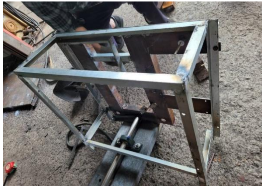
照片 4 鐵匠班焊接底座情形 2
