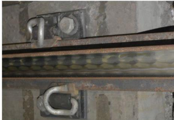
圖 4 波狀磨耗生成機制 [21]
