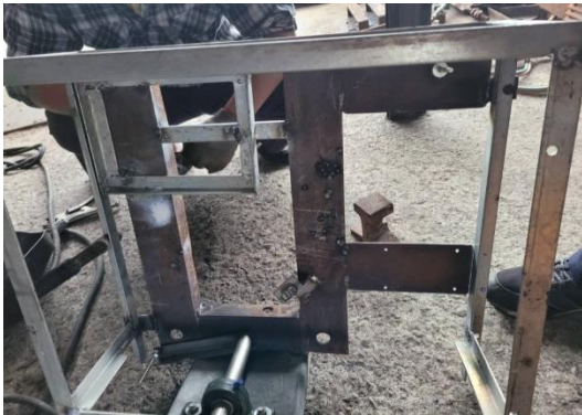
照片 3 鐵匠班焊接底座情形 1
