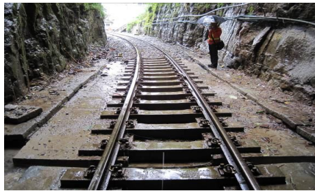
圖 43 隧道北口曲線段
