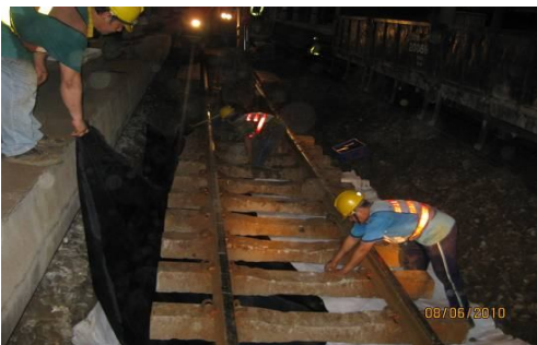
圖 6 宜蘭站內第一及第二月台內側之東、西主正線軌道抽換石碴
