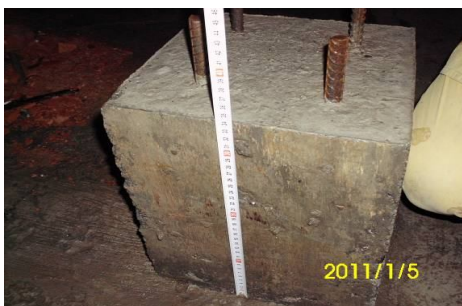
圖 38 預鑄之 R.C 支撐柱 1
