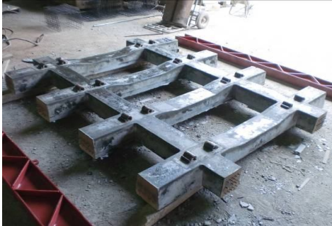
圖 8 框式軌枕製作
