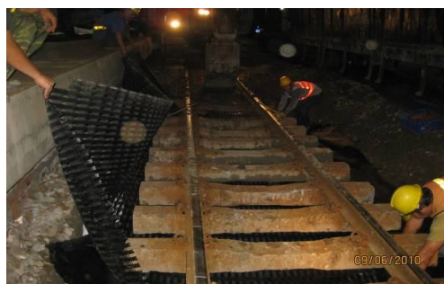
圖 7 底層鋪設加勁格網及地工織布（共 4 層）
