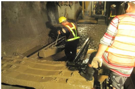
圖 28 挖除舊 PC 枕
