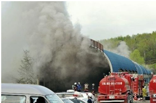
圖 4 隧道火災情形【3-9】
