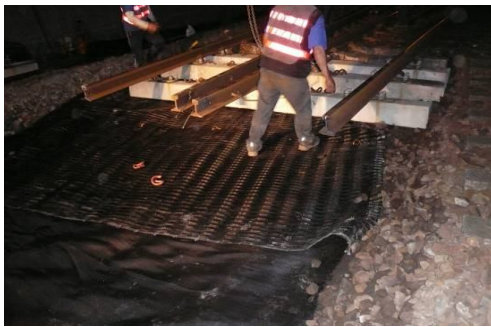
圖 4 羅東站內抽換 PC 枕型道岔
