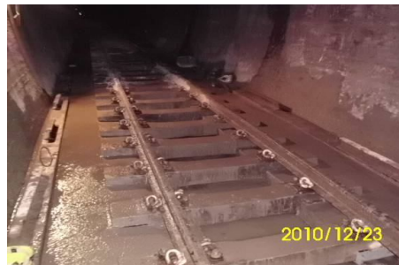
圖 37 兩側隧道邊設有邊溝模板
