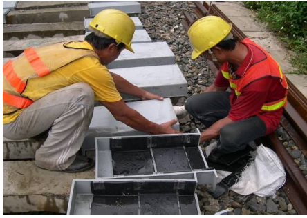
圖 26 彈性軌枕端部套裝防震箱
