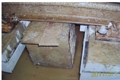
圖 39 預鑄之 R.C 支撐柱 2
