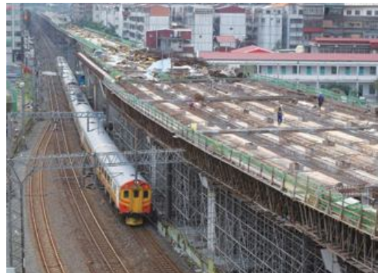
圖 2 施工中維持營運
