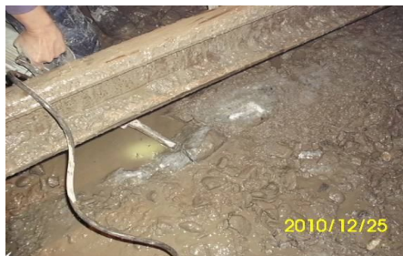
圖 31 打除仰拱岩盤
