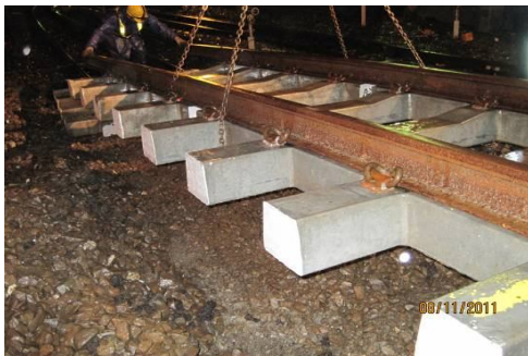
圖 10 框式軌枕抽換
