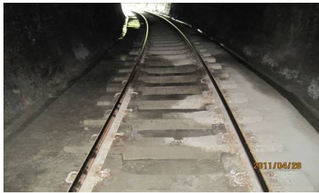
圖 42 直結式無道碴軌道完成
