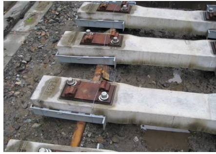
圖 27 套裝防震箱完成
