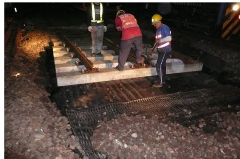
圖 5 底層鋪設加勁格網及地工織布（2 層）
