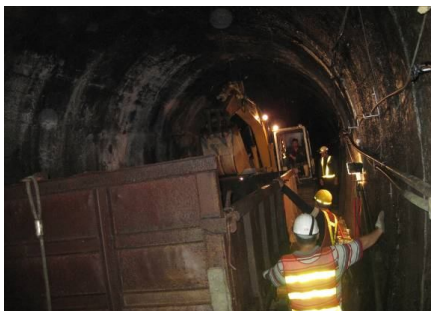
圖 32 隧道內廢碴運棄
