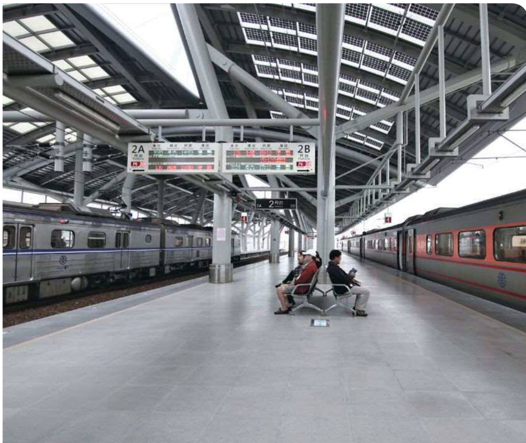
▲屏東站設置屋頂光電板
