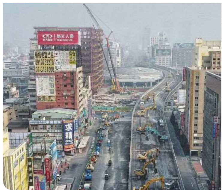
▲拆除中博高架橋引道
