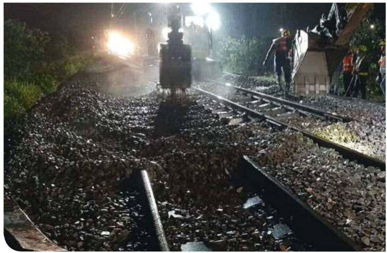
▲夜間軌道切換現場
