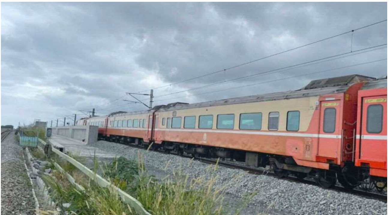
▲新利嘉溪橋列車通過情形(東工處提供)
