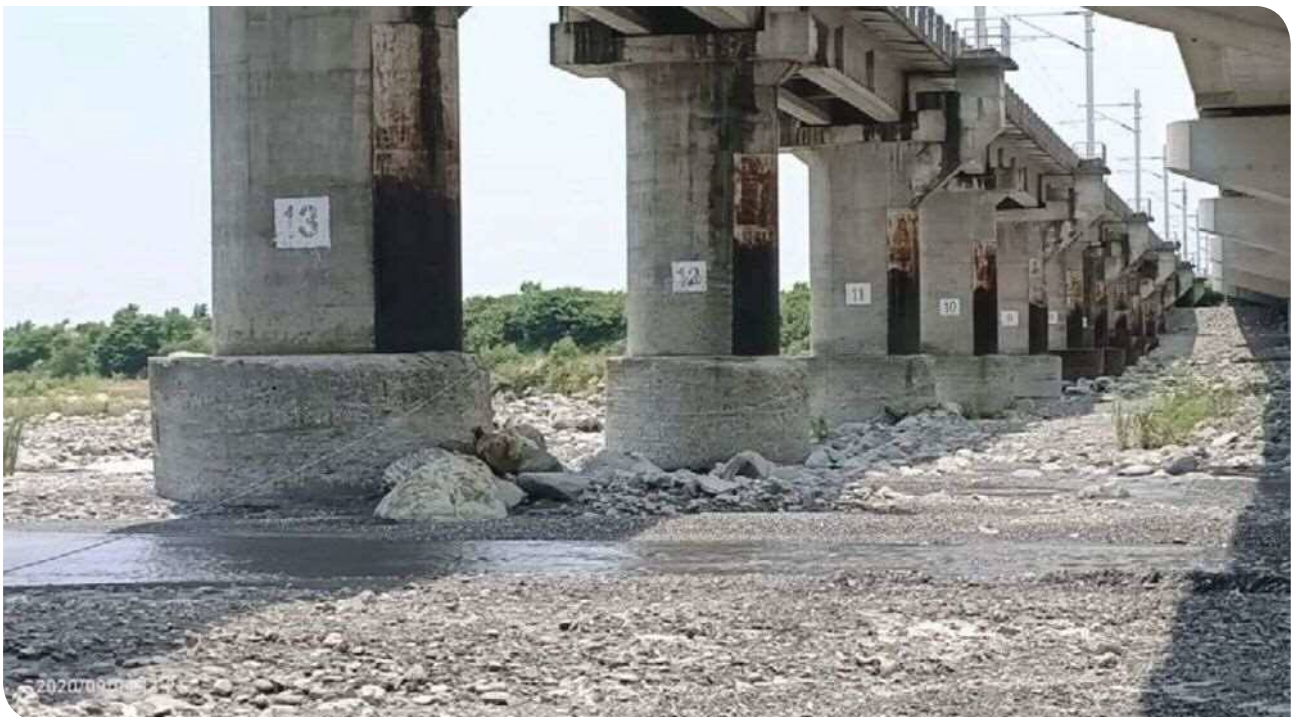
▲利嘉溪橋原有（左側）新建（右側）橋墩照片（東工處提供）
