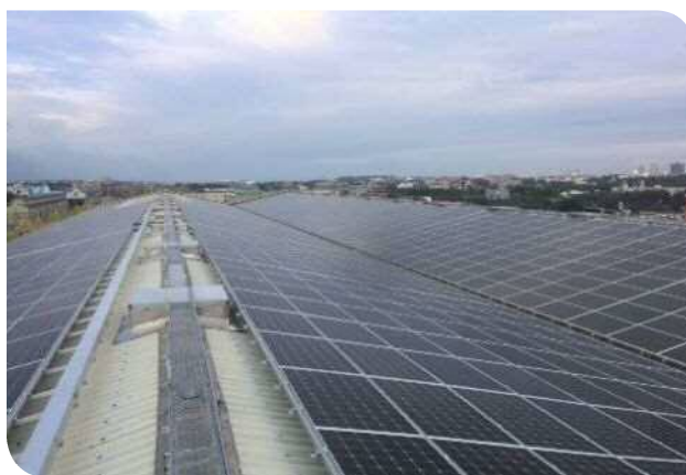
▲潮州車輛基地屋頂完工太陽光電板
