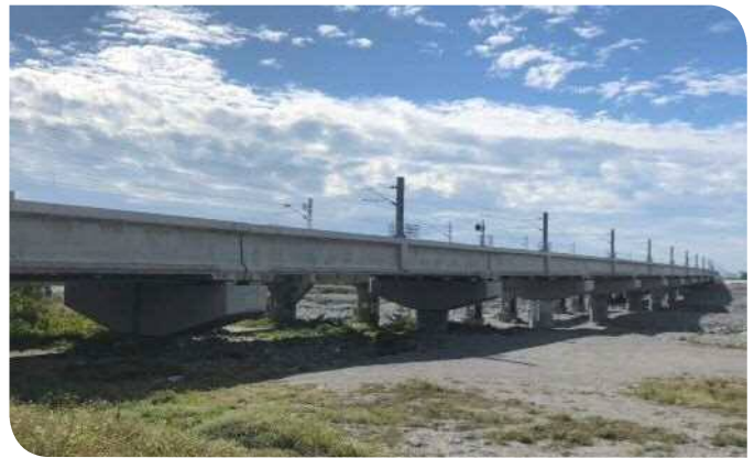
▲利嘉溪橋新建橋墩照片
