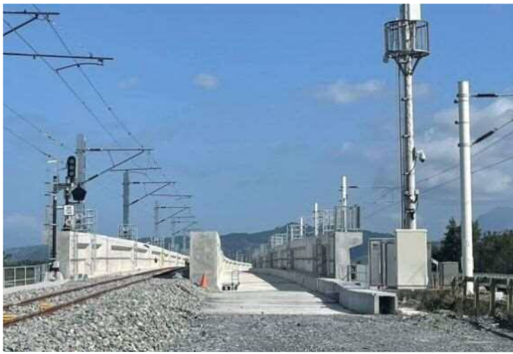
▲利嘉溪橋鋪設新軌及電車線架設
