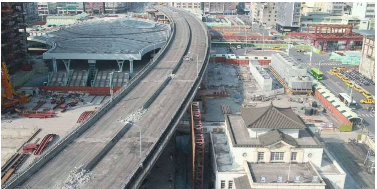
▲準備拆除前中博高架橋
