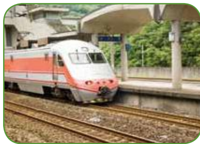
永樂車站月台是北迴線雙軌電氣化後改建而成
