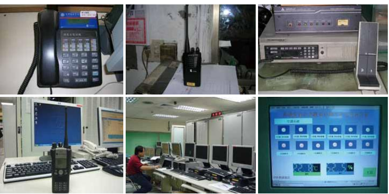
11. 有線調度電話 12. 5 瓦手提式無線電話機 13. 25 瓦站車無線電話基地局 14. 行車調度無線電話系統手機 15. 行車調度無線電話系統中央調度設備 16. 機房安全監控系統監測畫面
