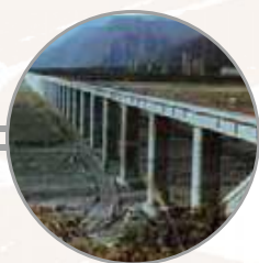
橋涵工程： 立霧溪橋完工
