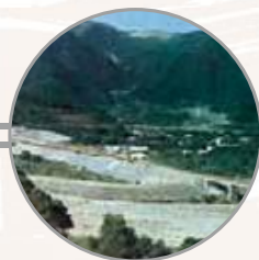
路基工程： 北迴鐵路東澳站附近
