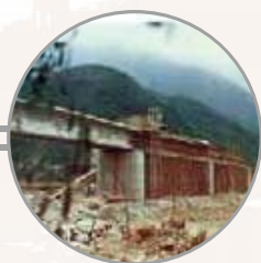
橋涵工程： 三棧溪橋丁字樑場撐施工
