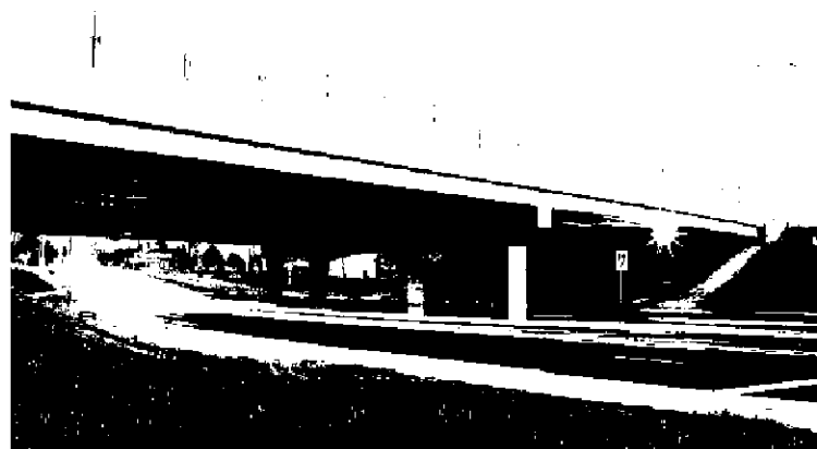
圖 22 高性能混凝土橋樑[60]
