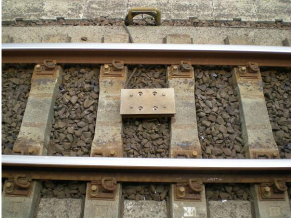
(a) 臺鐵 ATP 地上感應器
