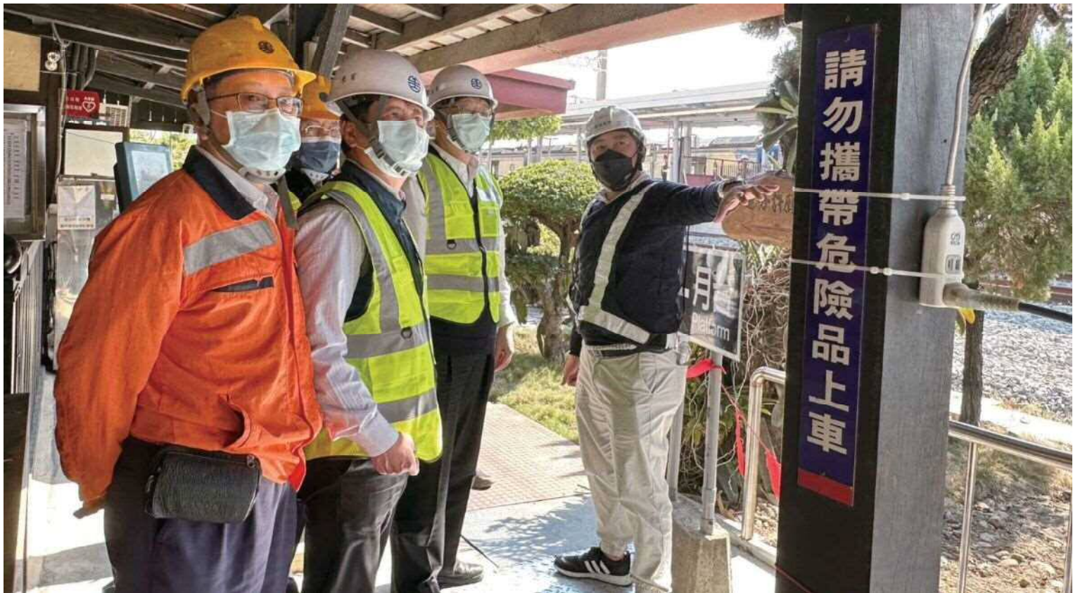
▲專案工程處處長姜登凡、臺中工務段段長朱我帆、臺中運務段段長蘇鎮霖陪同局長杜微視察工程現場
