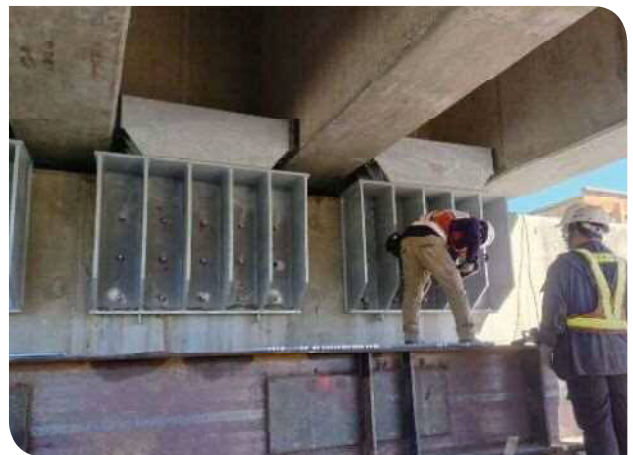
▲臺鐵新秀姑巒溪橋安裝鋼止震塊
