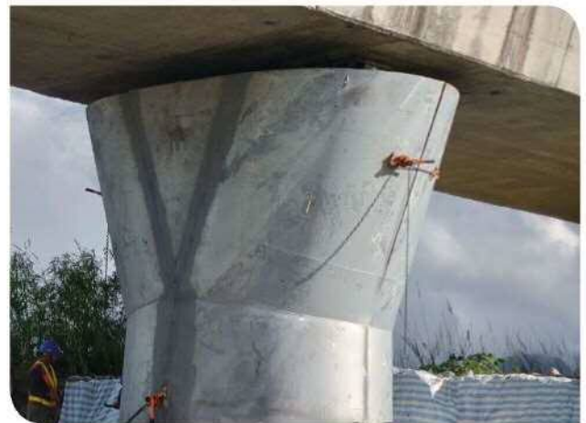
▲臺鐵樂樂溪橋墩柱鋼板包覆
