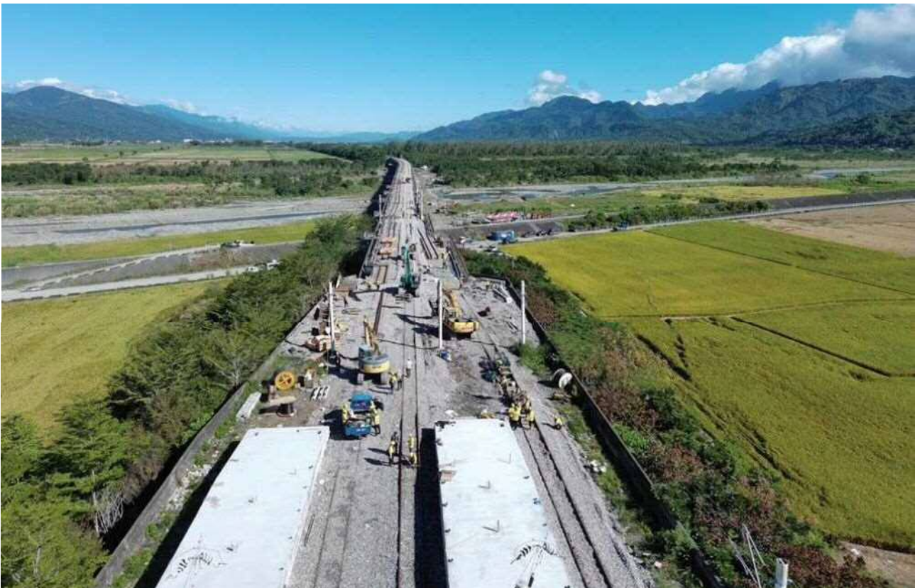
▲臺鐵玉里至東里間鐵路修復作業
