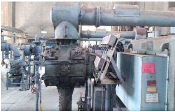
▲原動室的電氣設備
