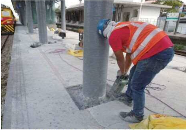
▲臺鐵東里車站月台雨棚柱包覆補強作業
