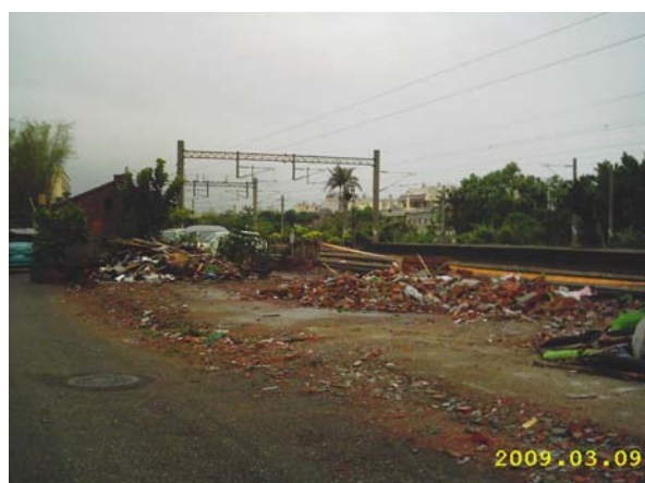
老舊房屋拆除
