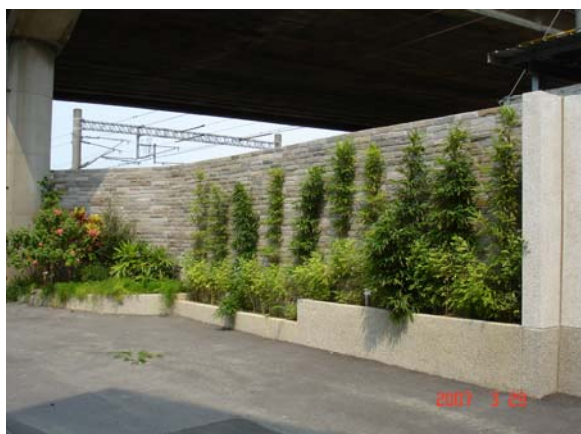
路橋下地界經加安全圍牆並綠美化
