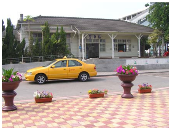
文化資產：後壁車站
