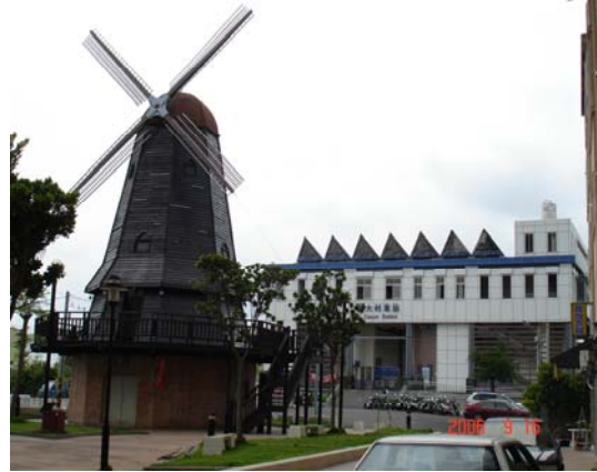
新建大村站跨站站房
