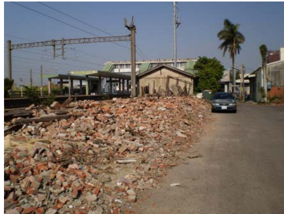
房屋拆除整地廢棄物待清運
