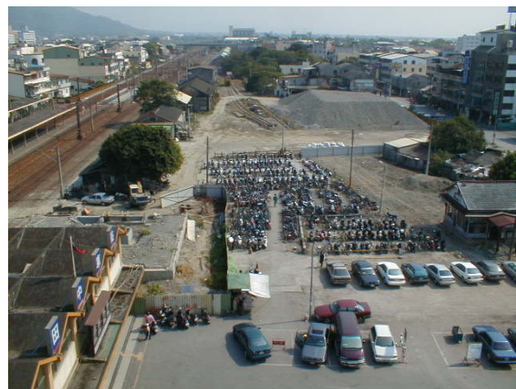
車站周邊房屋拆除環境處理中
