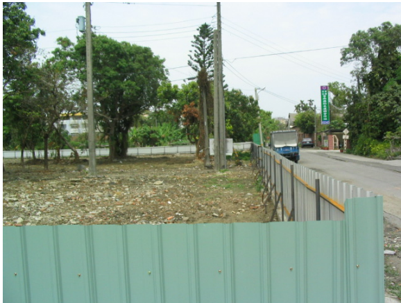
整地後築圍牆管理防止閒人進入
