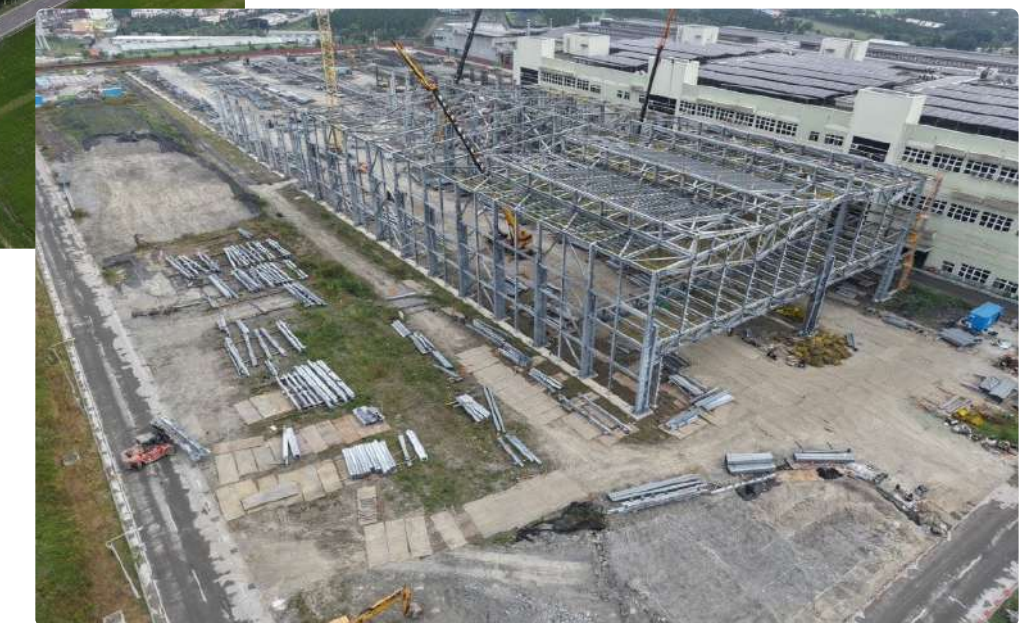
檢修工廠施作區域
