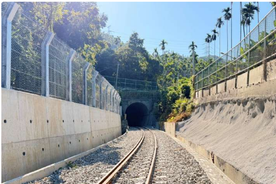
隧道口邊坡加強加固
