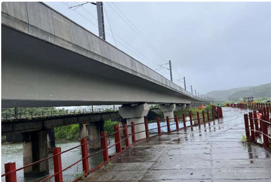
第三雙溪及新社橋改建工程 - 由橋下往橋上拍攝
