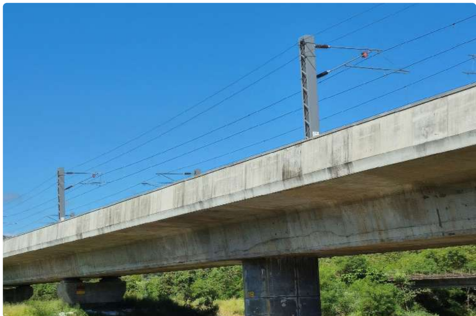
第一、二雙溪橋改建工程 - 橋梁底
