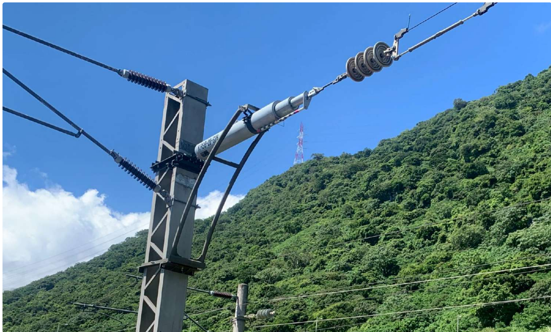
現場實際安裝 -1
