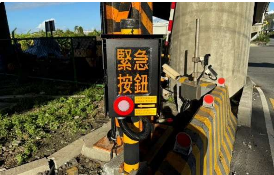
平交道入口側手動緊急按鈕更新
