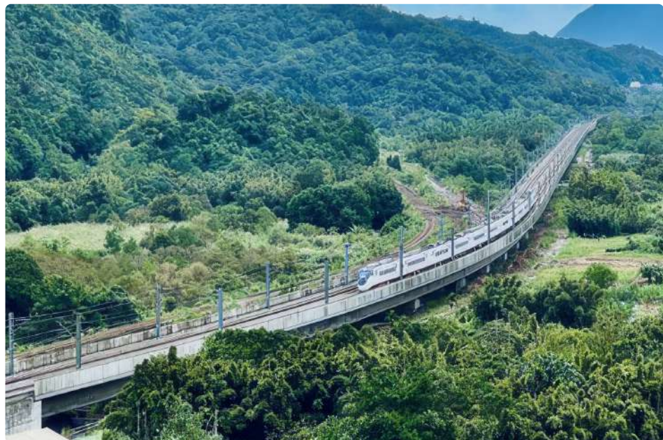
第一、二雙溪橋軌道切換後實景
