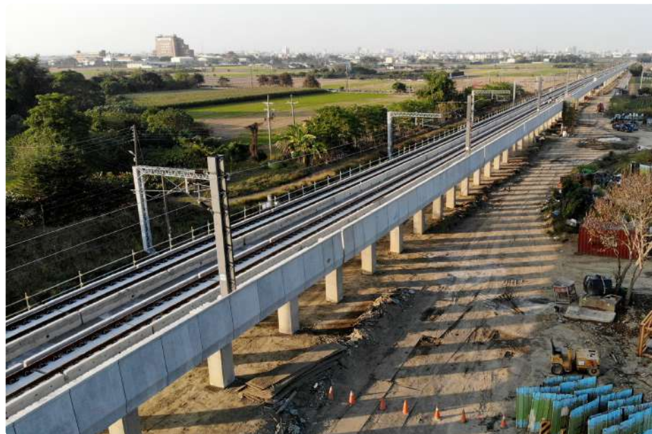
溫厝廂溪橋改建工程
