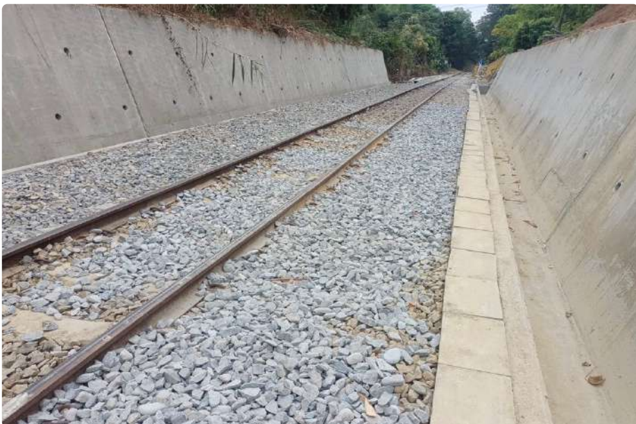
邊坡改善強化結構安全
