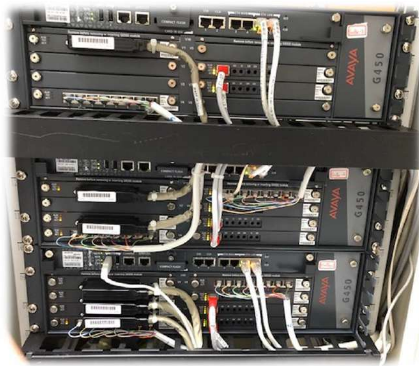
Avaya G450 閘道器（台北、宜蘭、七堵、新竹） (H x W XD): 133.3mm x 482.6 mm x 460 mm
