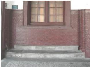
圖 16 門廊外側貼磚
