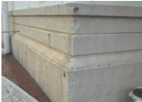
圖 15 外牆洗石子台度
