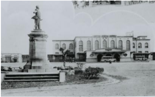
圖 4 第二代臺南火車站(臺南驛)
