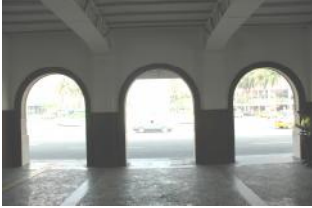
圖 9 門廳外(車寄)三道拱門
