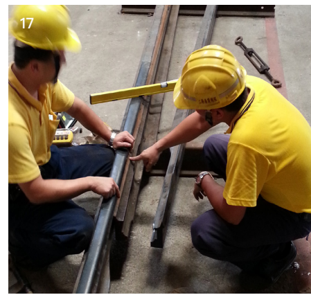
圖 17： 進行 18m 尖軌及 11m 尖軌之 試組裝作業 組立測試作業
