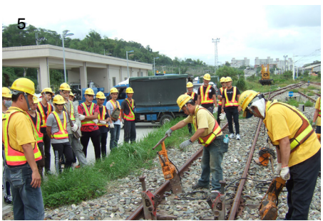
圖5： 臺東工務段 示範人工起道砸道及撥道情 形
