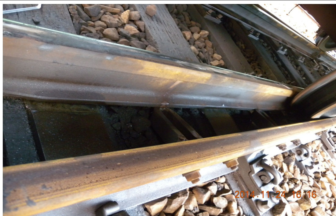
第 2 車 EP527 號第 2 軸出軌情形
