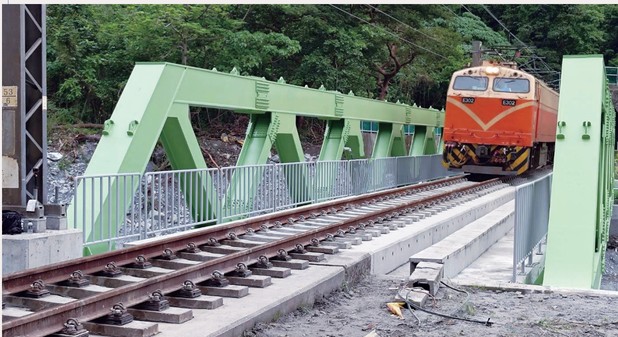
西小清水溪橋橋梁載重試驗
