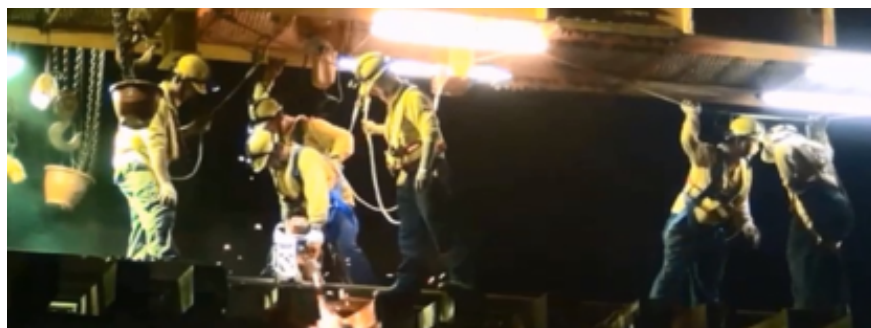
軌道鋼軌切除作業
