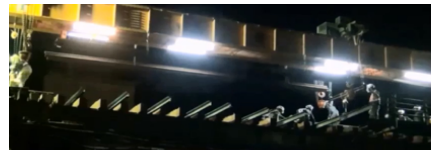
人行步道 C 型槽鐵安裝
