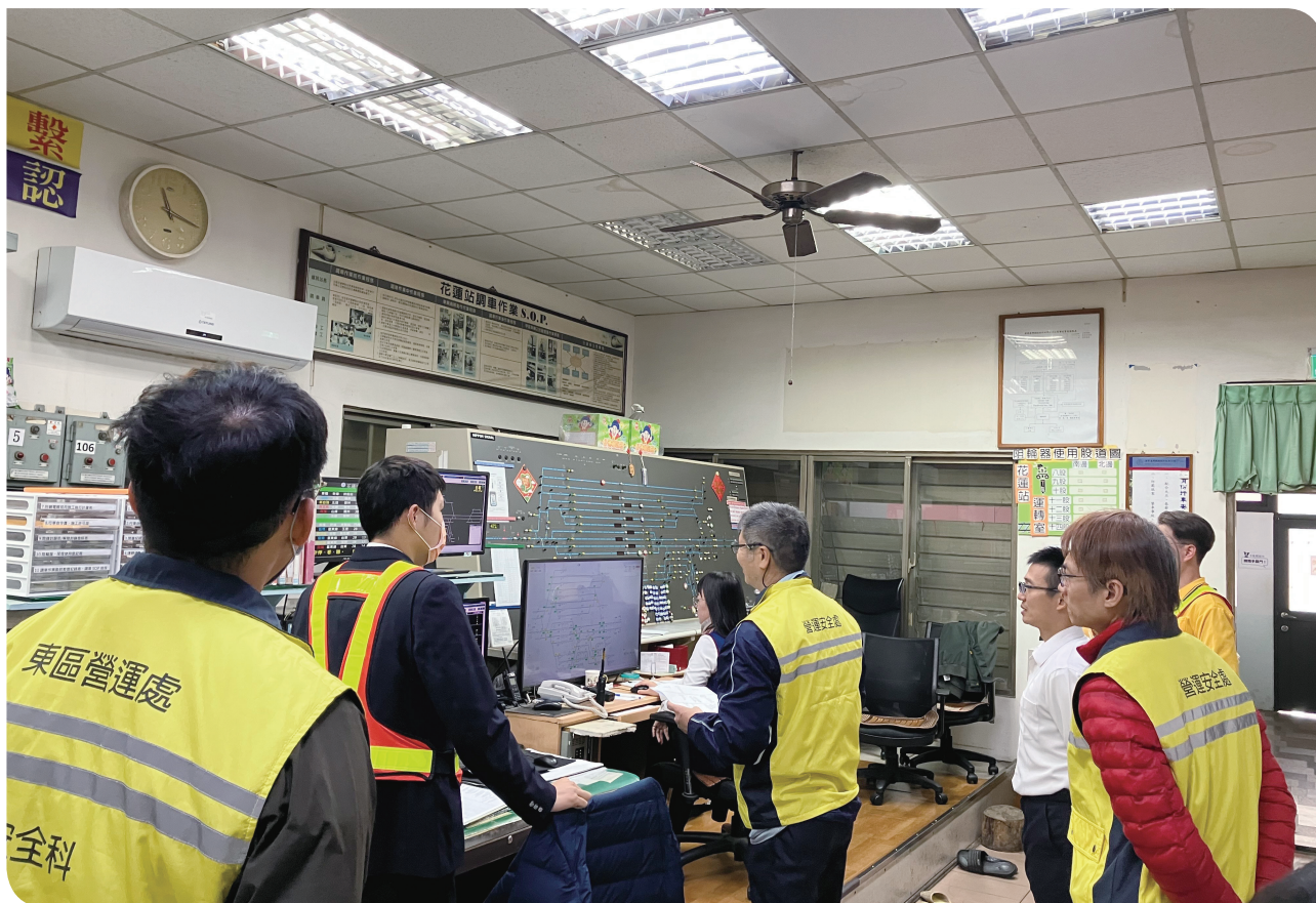
▲由各區營運處、機務處、工務處與電務處聯合執行行車安全設備設施檢查，運安處抽查各單位檢查情形
