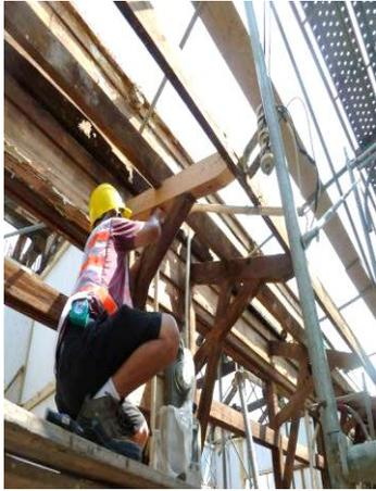
圖 3-4-12 原有木構件腐朽處抽換
