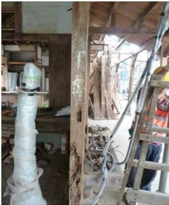
圖 3-3-6 立柱內部蛀空腐朽
