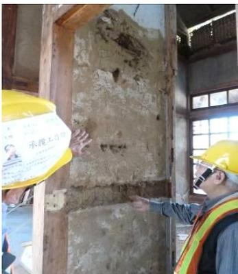
圖 5-3-6 原有土牆損壞檢視
