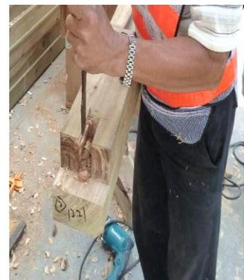
圖 3-4-11 原有木構件腐朽處抽換
