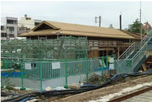
圖 2-2-8 古蹟車站鋼管鷹架
