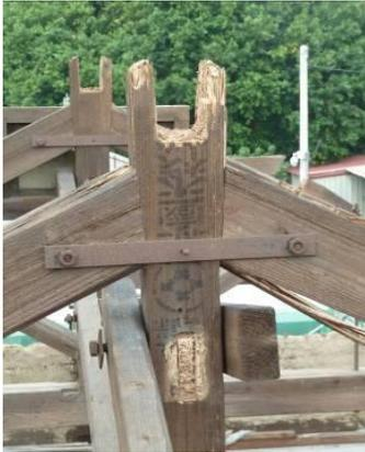
圖 3-3-3 中童柱樑接處腐朽
