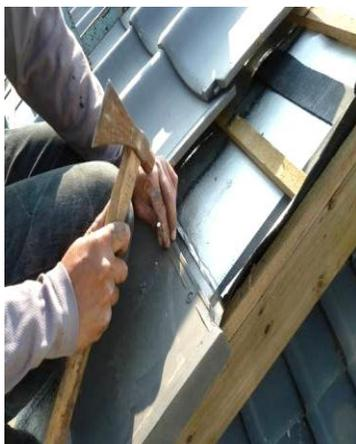
圖 4-3-23 邊瓦鋼釘固定
