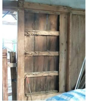
圖 3-3-8 木飾牆內襯骨料腐朽
