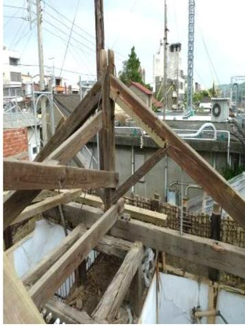
圖 3-4-22 原有木構件腐朽處
