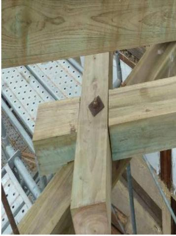
圖 3-4-21 使用舊有鐵件鎖固
