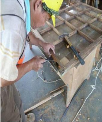
圖 3-5-2 窗戶腐朽處挖除
