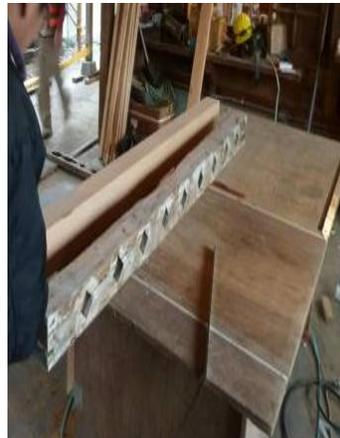
圖 3-5-15 腐朽構件原樣仿作
