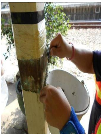
圖 3-2-7 刮除已脫落面漆
