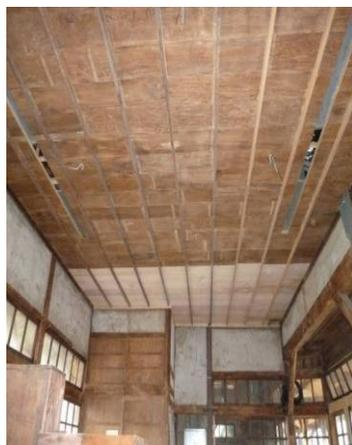
圖 3-5-19 站長室天花板損壞部分使用新料復原
