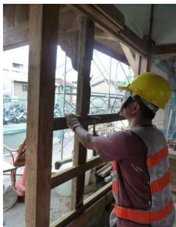
圖 3-5-22 腐朽構件更換新料
