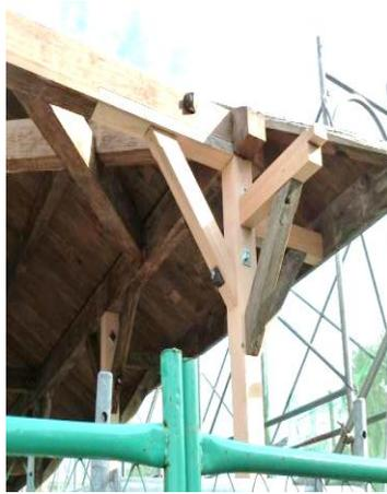
圖 3-4-13 原有木構件腐朽處抽換
