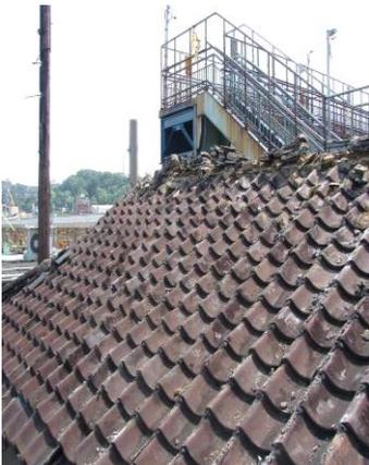
圖 2-3-2 屋面瓦損壞情形
