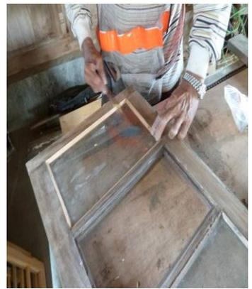
圖 3-5-4 玻璃破裂更換圖
