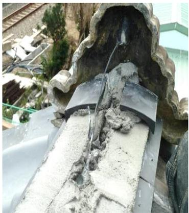
圖 4-3-25 鬼瓦鋼線固定
