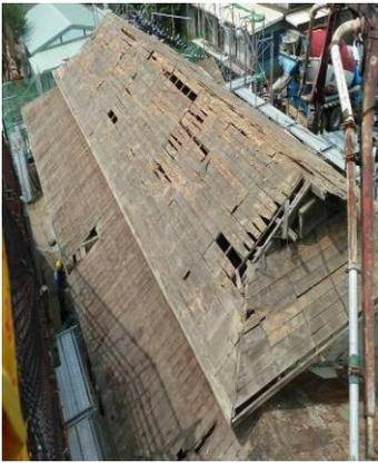
圖 2-3-5 屋面瓦拆除完成
