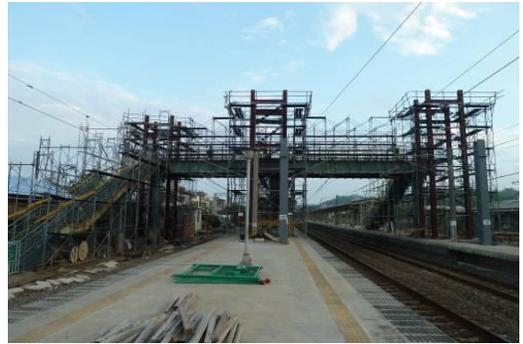
圖 2-2-7 天橋鋼管鷹架
