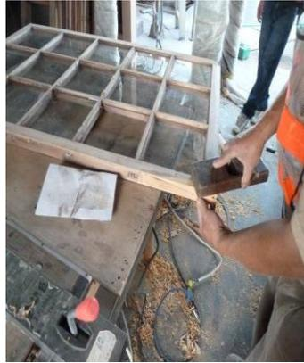
圖 3-5-3 窗戶腐朽處更換新料
