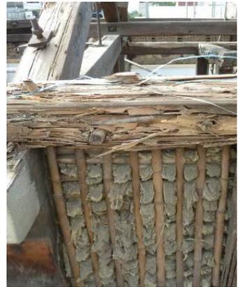
圖 3-3-5 上軒桁內部蛀空腐朽
