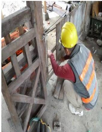
圖 3-5-14 損壞欄杆分解
