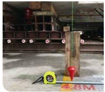
▲架高移動錘重水平量測
