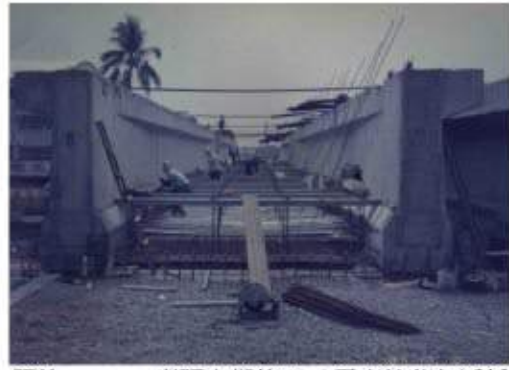
照片 1-4 U型預力樑施工（屏東線萬年溪橋）
