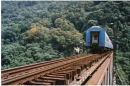
照片 6-21 橋梁檢查（內社川橋）
