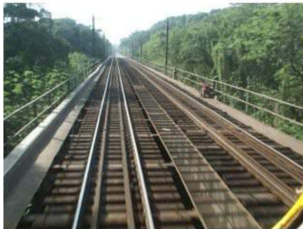
照片 6-14a 縱貫線鳳山崎旱橋
