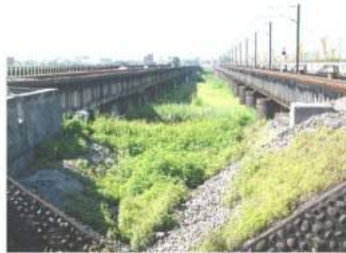
照片 8-6 宜蘭線濁水橋（右側為建於 1927 年之鋼鈹梁橋，左側為建於 1985 年之預力 I 型梁
