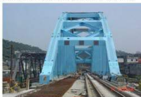
照片 6-6 2004 年新基隆河鐵路橋
