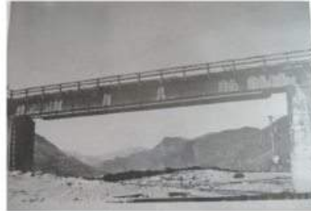
照片 8-3 東線新武呂溪橋加固後情形
