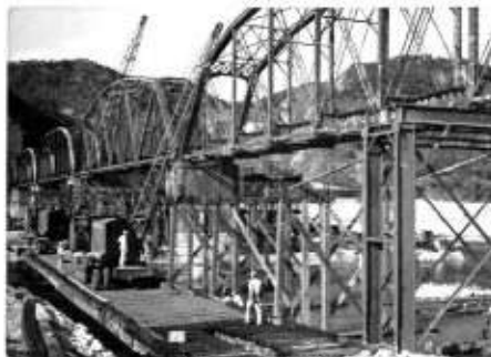
照片 4-3 鋼桁架橋組裝施工
