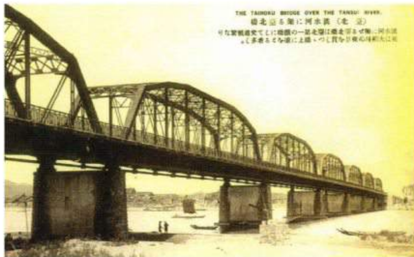
照片 5-4 清代鐵路台北橋（跨淡水河）約相當於現台北橋位置，照片中之鋼桁架鐵橋應為日本時期初建，1901 年鐵路改線後，原橋改為公路橋。
