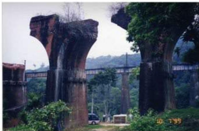
照片 3-5 舊山線魚藤坪橋（磚造拱橋）
