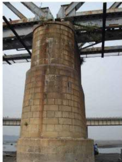
照片 3-27 善高屏溪鐵路橋石砌橋墩
