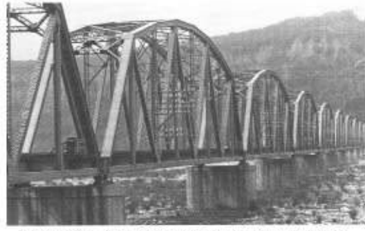
照片 6-25 完成於 1906 年之舊山線鐵路 大甲溪鋼橋
