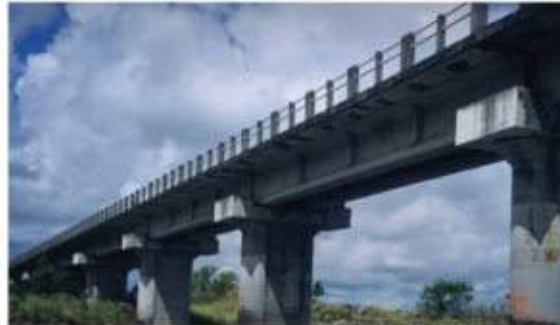
照片 8-5b 東線鐵路後期的預力樑橋（已增設人行 維修步道取代避車台，帽樑亦作防震設計）
