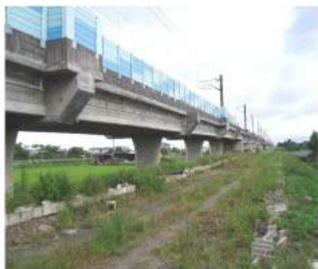
照片 9-5 濁水溪橋北端高架陸橋
