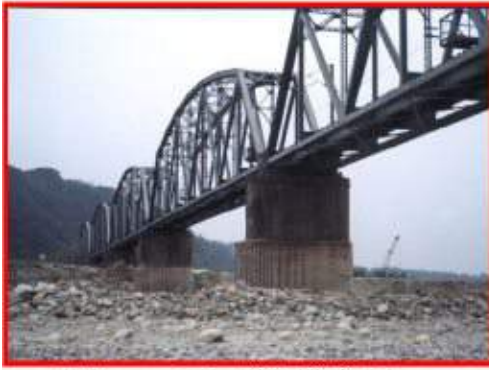
照片 1-6 下承式鋼桁架橋
