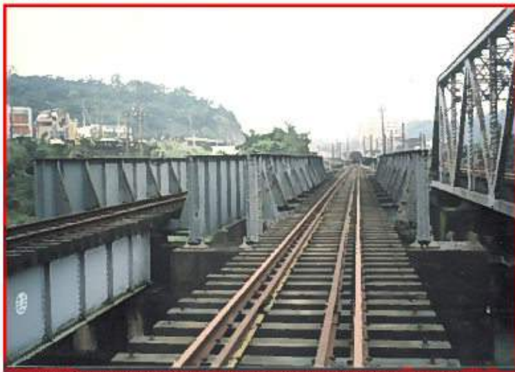
照片 1-5 上承式鋼梁橋（近端）及下承式鋼梁橋（遠端）
