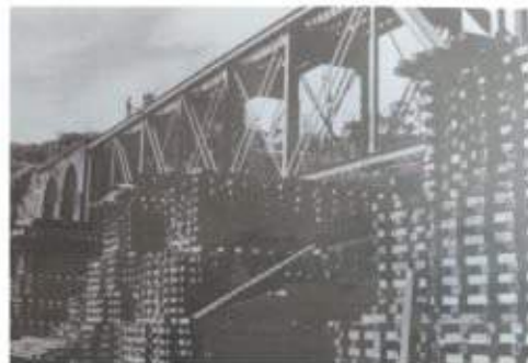
照片 6-12 縱貫線鳳山溪橋 46.9M 鋼桁架梁兩孔於 1950 年左右抽換工程
