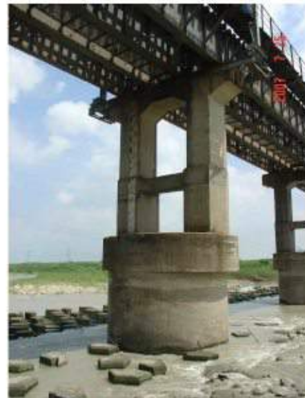
照片 3-31 鐵路鋼梁橋雙柱式橋墩及沉箱基礎
