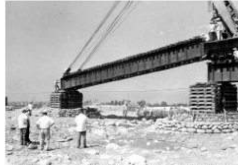
照片 4-4 鋼板組合桁樑現場吊裝
