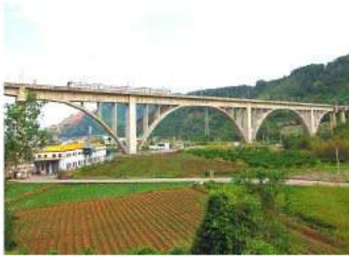
照片 8-17 鯉魚潭橋(1988 年)
