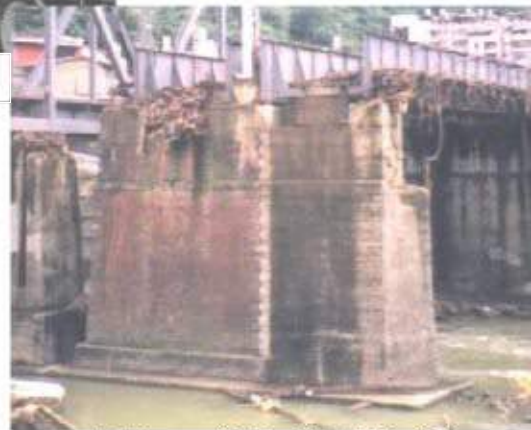
照片 6-3 基隆河鐵路橋之橋墩
