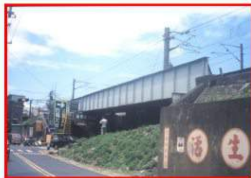
照片 1-2 槽型鋼樑（外側）
