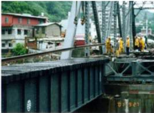
照片 9 上行線鋪軌作業。
