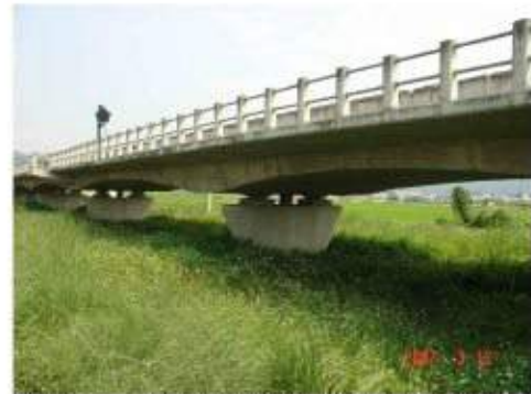
照片 9-4a 高架橋(連續預力樑及盤式支承)
