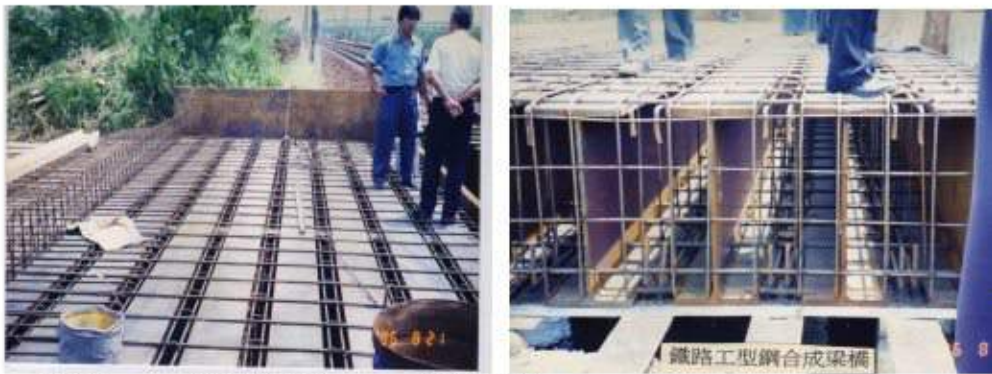
照片 3-21 鋼骨鋼筋(SRC)合成版樑
