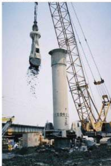
照片 3-35 全套管基樁施工
