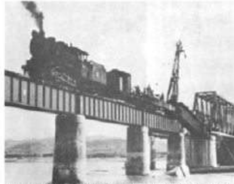
照片 7-16 1959 年八七水災後之大肚溪橋修復情形
