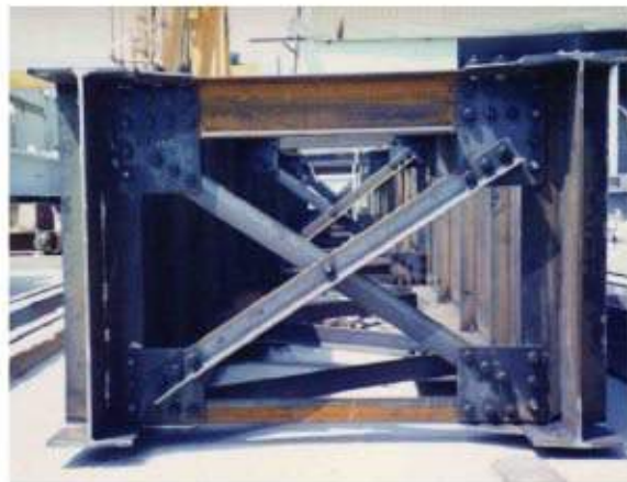
照片 3-22 鋼鉸鋼桁架組合樑
