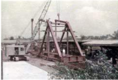
照片 4-1 鋼桁架橋組裝
