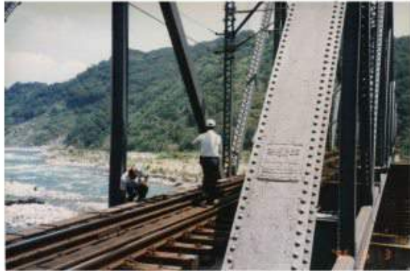
照片 3-8 工作人員於橋上檢查鋼樑零構件及軌道
