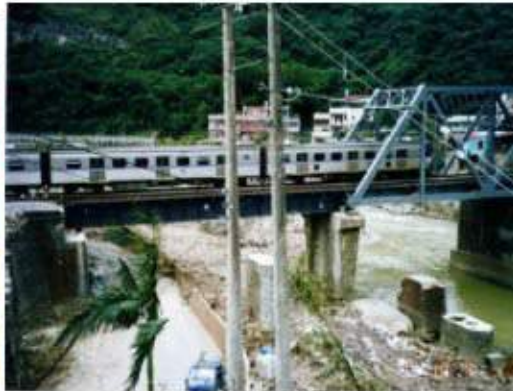
照片 12 縱貫線八堵搶修完成列車通過情形。
