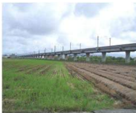
照片 9-6 濁水溪橋北端高架陸橋
