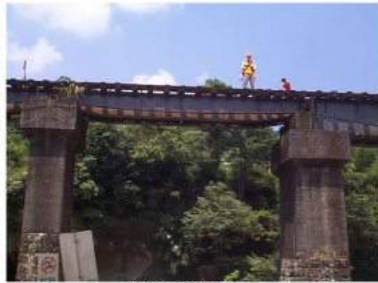
照片 6-54 平溪鋼樑橋
