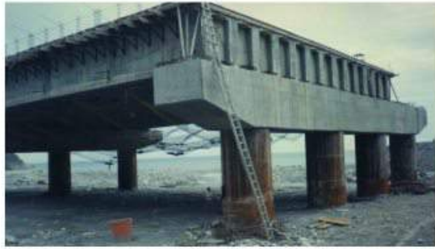
照片 3-15 施工中的 I 型預力樑橋
