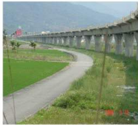
照片 9-3 玉里至東里間高架橋
