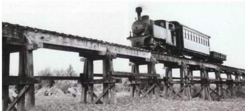
照片 3-25 羅東林業鐵路木構橋梁
