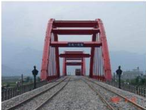
照片 9-4a 塔城一號鋼拱橋及軌道
