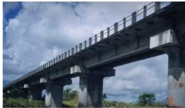
照片 3-10 預力鋼筋混凝土橋
