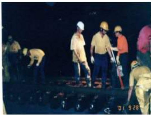
照片 11 90.9.28 凌晨鋪軌工作接近完成，作最後調整。
