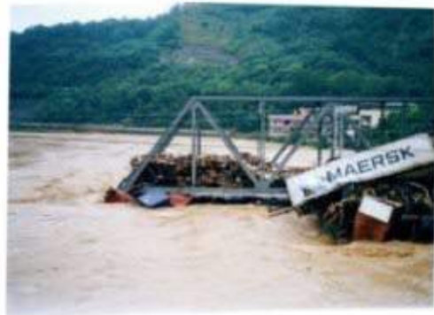
照片 1、照片 2 90.9.16 納莉颱風帶來豪雨致基隆河水位暴漲淹沒鐵路八堵橋，造成橋墩被沖毀兩座，鋼梁流失八支之災情，照片中之水位已退，最高時淹沒至照片 1 左側淺綠色鐵皮屋之窗口上方。
