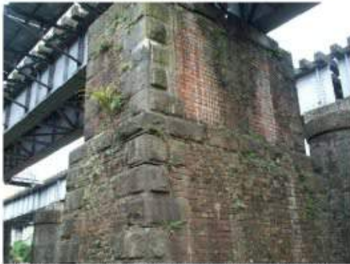
照片 2-2 鋼梁橋砌磚與塊石橋墩
