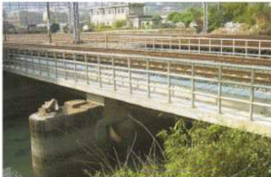
照片 9-9 改建完成之鹽田溪橋
