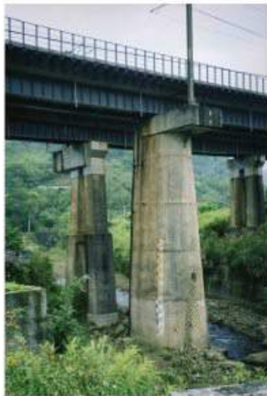
照片 6-51 宜蘭線第二武丹坑橋
