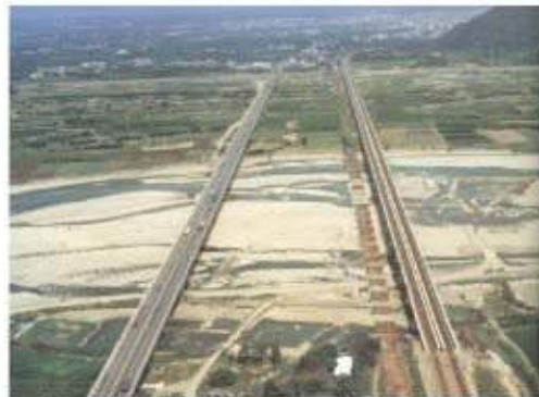
照片 8-11 最右側為 1987 年完成新下大甲溪橋，新橋左側為已拆除上部結構之舊鐵路橋
