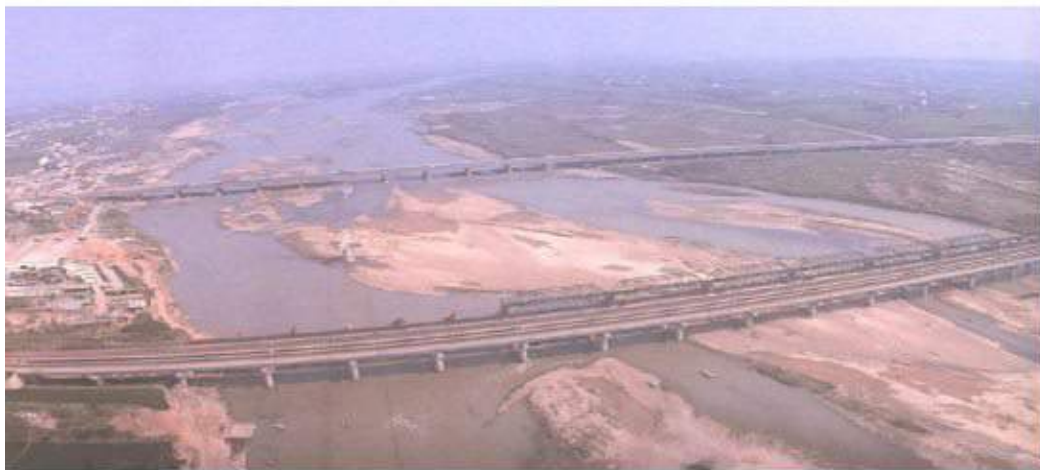
照片 6-32 大肚溪橋(中間有鋼桁架橋之路線為完成於 1924 年之鐵路大肚溪橋，另其下方是 1988 年剛完成、當時尚未使用之新大肚溪橋)
