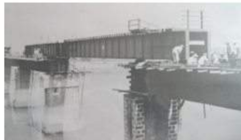
照片 7-3 新店溪橋 80 呎抽換鋼板梁情形
