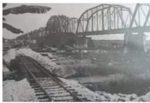
照片 7-11 下淡水溪大橋抽換新桁架工程
