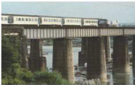
照片 7-2 更換鋼梁後之鳳山溪橋
