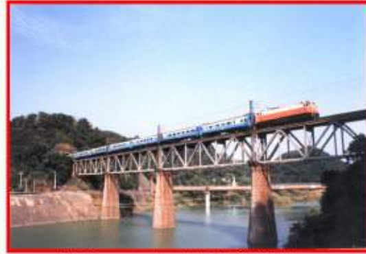
照片 1-7 上承式鋼桁架橋
