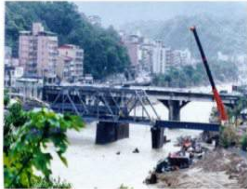
照片 8 90.9.27 中午開始吊放上行線鋼梁。
