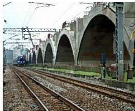
照片 9-2 多跨連續拱橋
