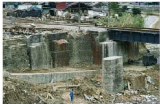
照片 2-6 各年代建造橋台一字排開
