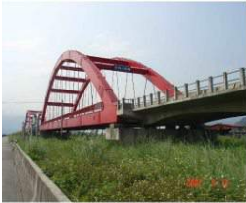
照片 9-4 塔城一號、二號鋼拱橋
