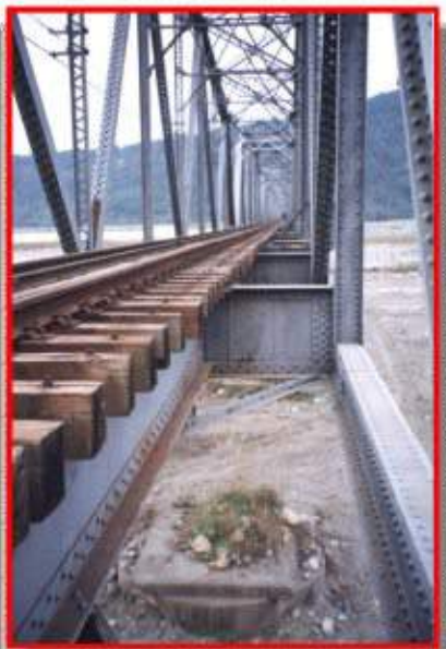
照片 1-8、1-9 下承穿式鋼桁橋（跨距 62.4 公尺）
