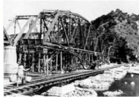
照片 4-2 鋼桁架橋現場組裝
