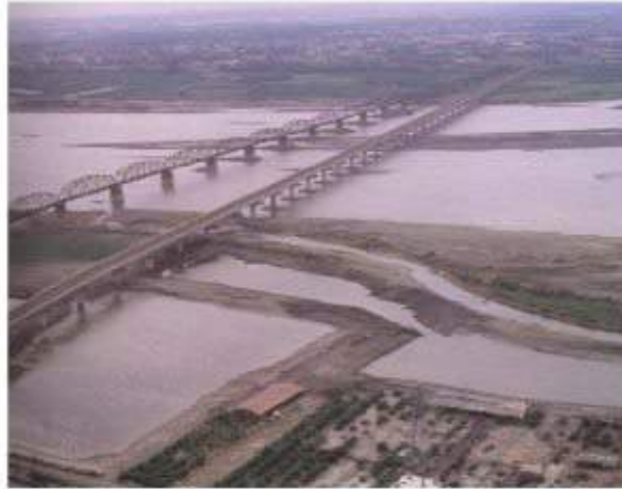
照片 8-9 新舊鐵路高屏溪橋並列
