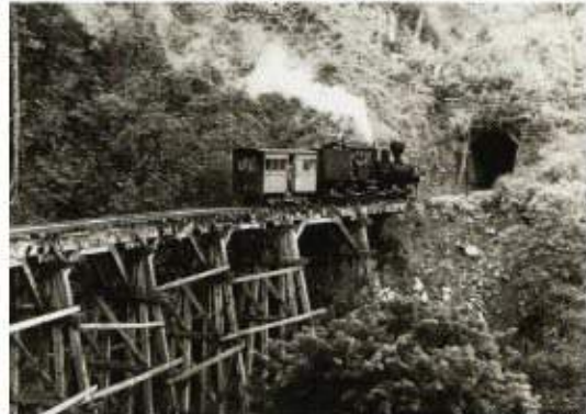
照片 3-24 阿里山鐵路木棧橋
