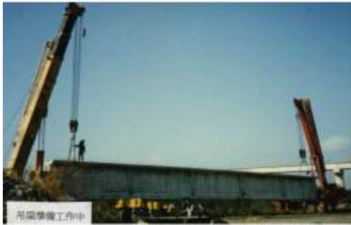
照片 2-10 I型預力樑吊放作業
