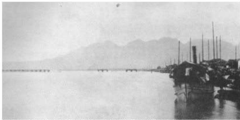
照片 5-3 毀於 1897 年一場暴風雨之鐵路淡水河橋，照片中依稀可見該橋斷為數節
