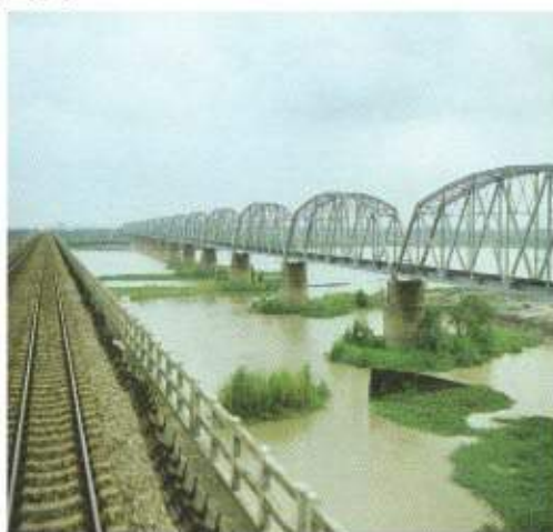
照片 6-41 於 1987 年新鐵路高屏溪橋完成、未通車前之下淡水溪橋
