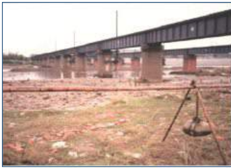
照片 6-26 1920 年下頭份溪橋 (遠方磚造橋墩為山線頭份溪橋)
