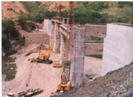
照片 8-7 施工中之枋野二號橋
