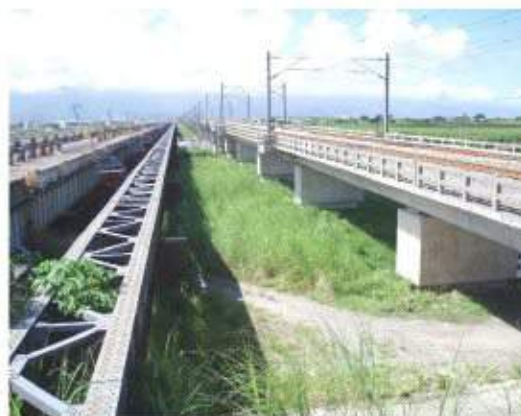
照片 9-8 濁水溪橋(左側為舊橋)
