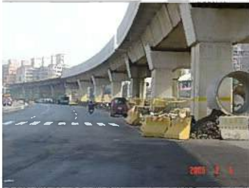
照片 9-1 預力混凝土箱型梁橋
