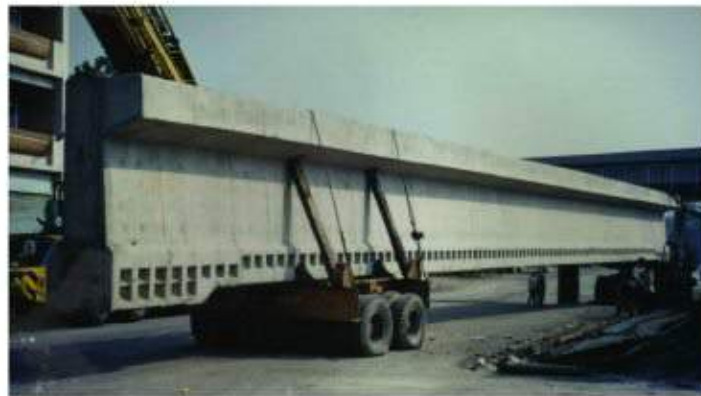
照片 2-12 高 2.8m 長 32m 預力樑運送與吊放作業
