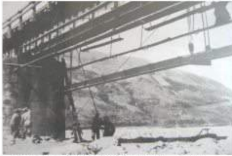
照片 8-2 東線鐵路橋加固施工情形
