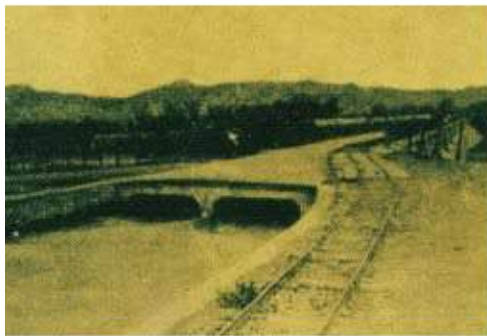
照片 3-12 景尾水道橋（1907）
