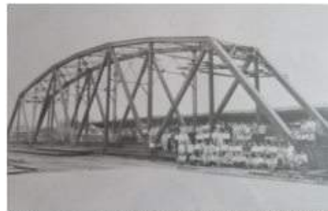
照片 7-9 大甲溪 200 呎(62.4m)新鋼桁架梁於工廠
