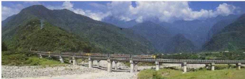
照片 8-5c 新三棧溪橋
