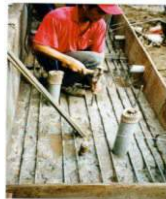
照片 5 原鑄鐵支墩座鑿除，下行線重新放樣打設 R.C 支承座。 照片 6 支承座加高部份與原橋墩（台）頂面間植入剪力鋼筋。
