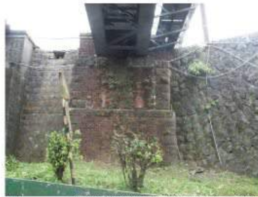
照片 3-29 舊基隆河鐵路橋磚砌橋台及翼牆
