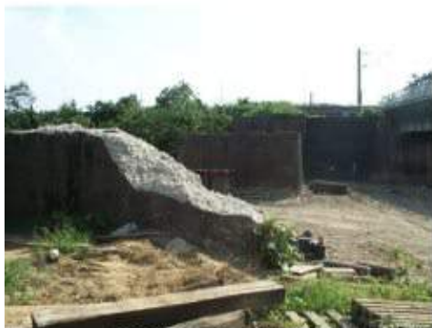
照片 2-5 舊橋墩（生石灰拌砂石搗固）
