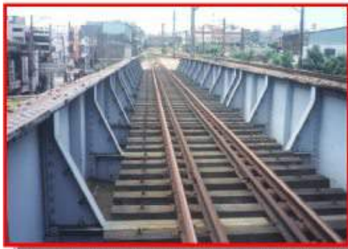
照片 1-1 槽型鋼樑（內側）
