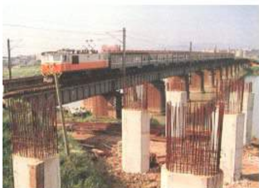
照片 6-9 1901 年新店溪橋(圖右為施工中之新橋橋墩，新橋於 1990 年完成)
