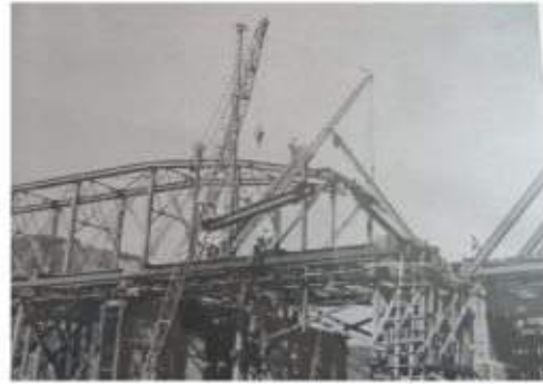
照片 7-13 濁水溪橋抽換舊鋼桁梁施工情形
