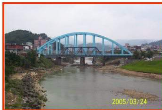
照片 2-4 鐵路基隆河橋（前面為舊橋）
