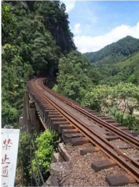
照片 6-53 平溪線幼坑橋
