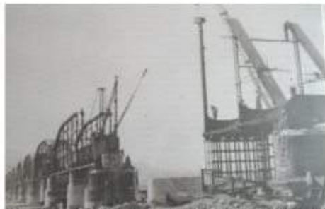
照片 7-8 大甲溪橋以臨時鋼支撐架拆解舊鋼桁梁情形
