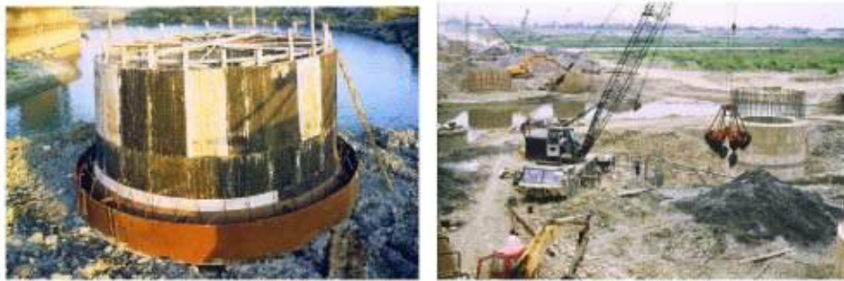
照片 3-32、照片 3-33 鐵路橋橋墩及沉箱基礎施工。
