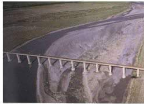
照片 8-1 1978 年北迴鐵路新建立霧溪
