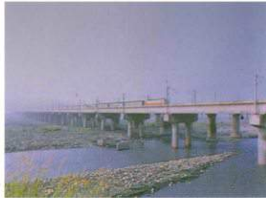
照片 8-15、8-16 濁水溪橋(預力 U 型梁) 左側為 1927 年舊橋、右側 1990 年新橋
