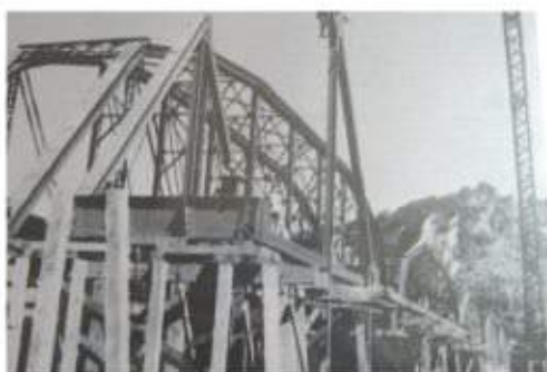
照片 7-10 大安溪橋工地組裝中之新鋼桁架梁
