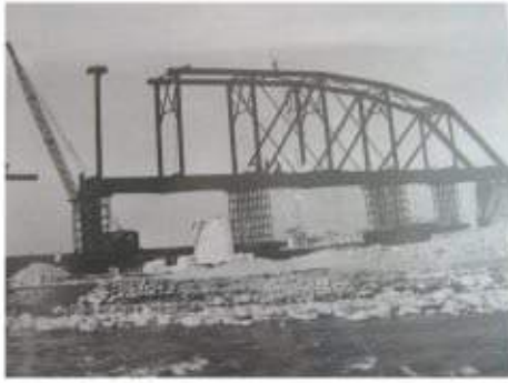
照片 7-12 濁水溪橋以臨時鋼支撐架 拆解舊鋼桁梁情形
