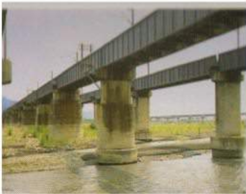
照片 8-15、8-16 濁水溪橋(預力 U 型梁) 左側為 1927 年舊橋、右側 1990 年新橋
