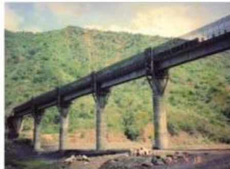
照片 8-8 設置有抗風屏之枋野二號橋
