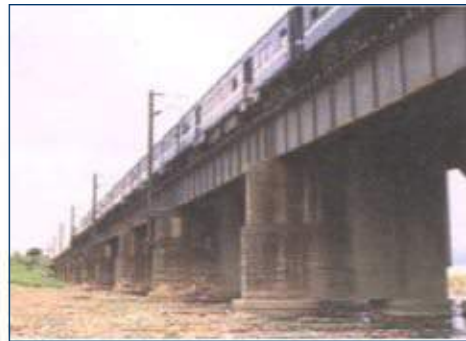
照片 6-27 1920 年下後龍溪橋
