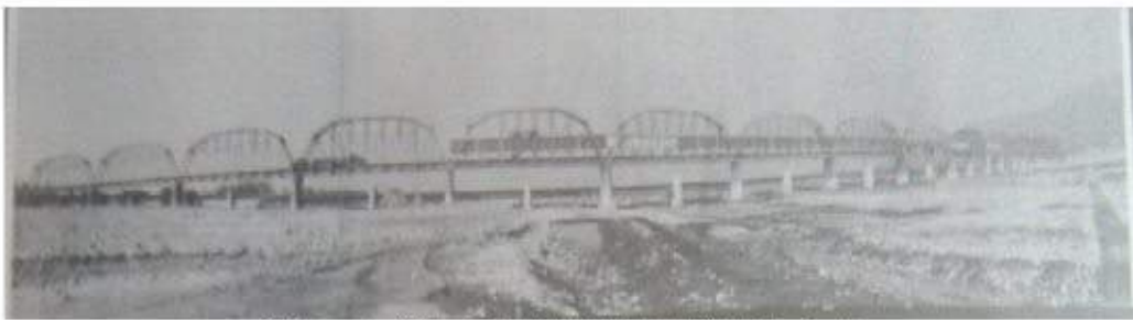
照片 7-14 濁水溪橋更換新鋼桁梁後之全景
