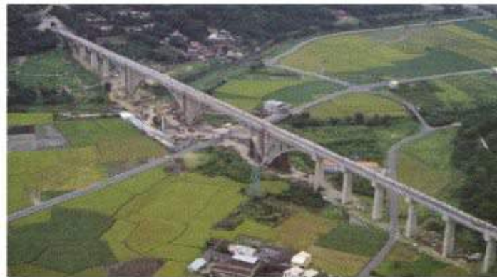
照片 2-13 山線鐵路鯉魚潭橋
