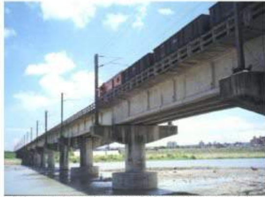
照片 8-13 1990 年頭前溪橋(預鑄預力 I 型梁)
