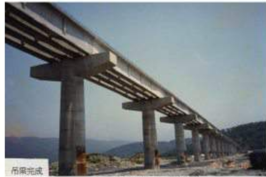
照片 2-11 I型預力樑橋
