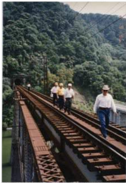
照片 6-19 橋梁檢查（內社川橋）
