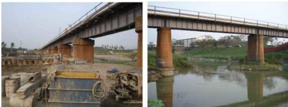
照片 6-44、45 屏東線東港溪橋
