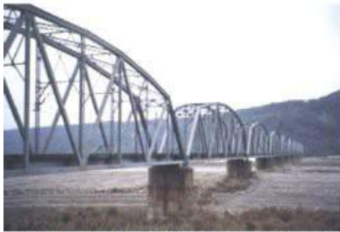
照片 6-24 完成於 1906 年之舊山線鐵路 大安溪鋼橋
