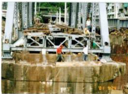
照片 5 原鑄鐵支墩座鑿除，下行線重新放樣打設 R.C 支承座。 照片 6 支承座加高部份與原橋墩（台）頂面間植入剪力鋼筋。
