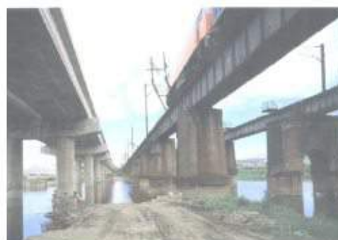
照片 6-10 第二大料坎溪橋(右為 1901 年舊橋、左為 1990 年剛完成之預力合成 U 型梁新橋)
