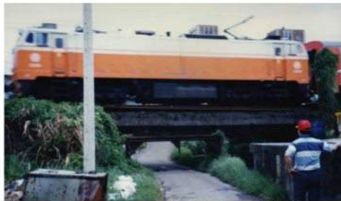
照片 3-14 一輛機車通過 RC 版樑橋
