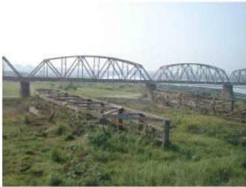
照片 6-42 高屏溪舊鐵橋 (1911 年)
