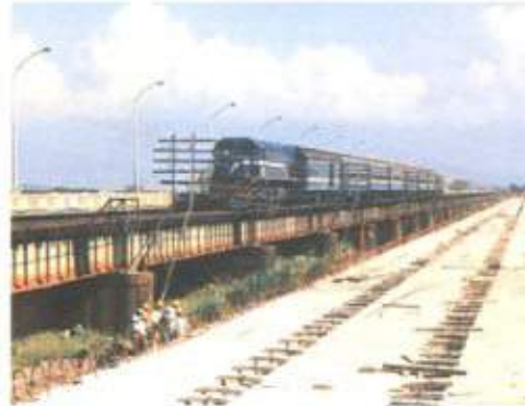
照片 6-50 左側列車正通過 1927 完成之宜蘭線濁水溪橋
