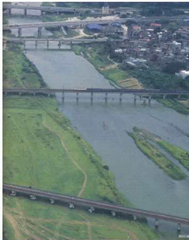
照片 6-33 縱貫線(山線及海線)兩座頭份溪橋
