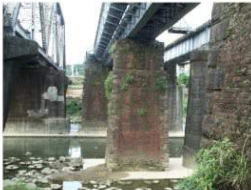
照片 3-26 八堵舊基隆河鐵路橋磚砌橋墩
