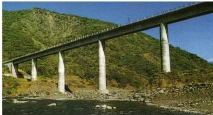
照片 8-8a 枋野二號橋（未設抗風屏前）
