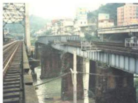
照片 6-5 1898 年宜蘭線基隆河橋橋 (主跨下承式鋼鈹梁)
