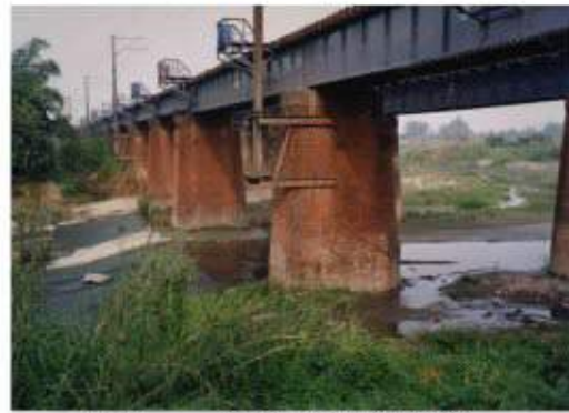
照片 2-3 鋼樑橋磚造橋墩
