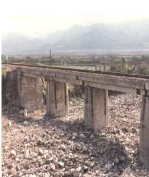
照片 8-4 改換預力梁後之成功溪橋(1981年)
