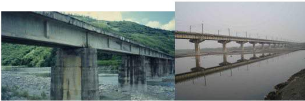
照片 3-16、17 完工後的 I 型預力樑橋
