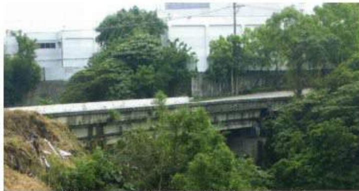
照片 2-7 台三線桃園縣第一預力橋
