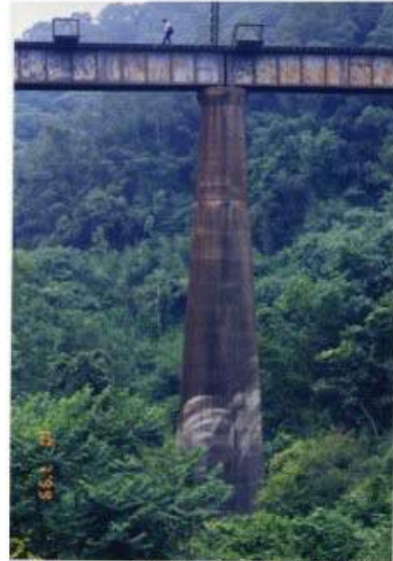
照片 6-20 橋梁檢查（魚藤坪橋）
