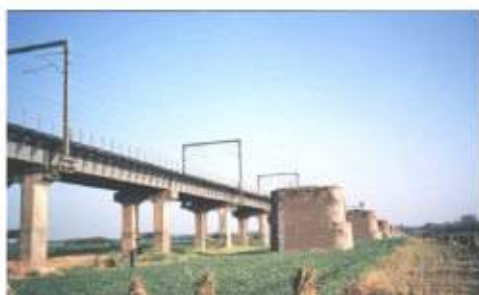
照片 7-6 左側為第二代曾文溪橋，右側為 1906 年第一代舊橋橋墩
