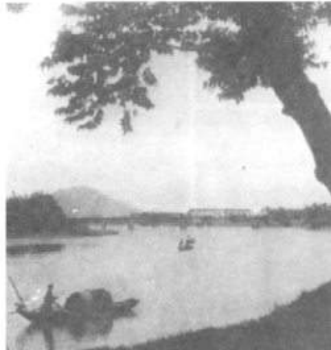
照片 6-52 1901 完成之基隆川橋
