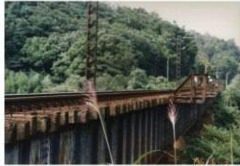
照片 6-22 橋梁檢查（魚藤坪橋）
