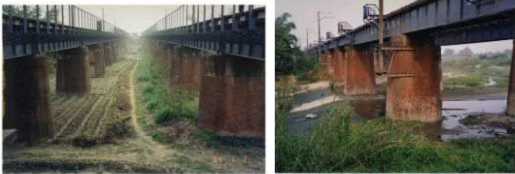
照片 6-36、37 石牛溪橋
