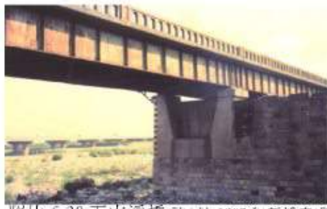
照片 6-30 下安溪橋(註：於 1987 年新橋完成後，改為公路橋)
