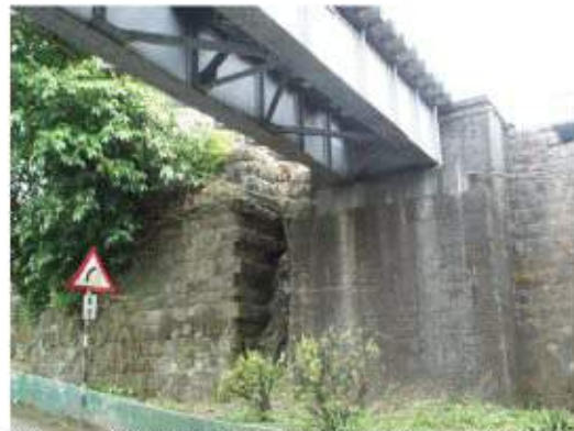
照片 3-30 舊基隆河鐵路橋混凝土橋台及兩側磚砌橋台
