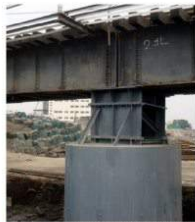
照片 6-49 林邊溪橋橋墩加高
