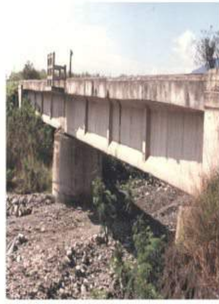
照片 8-5 改換預力梁後之水拔溪橋(1982年)
