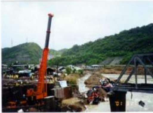
照片 7 90.9.27 清晨 450T 吊車依原定計劃進場，南橋台附近站場軌道清理繼續趕工。
