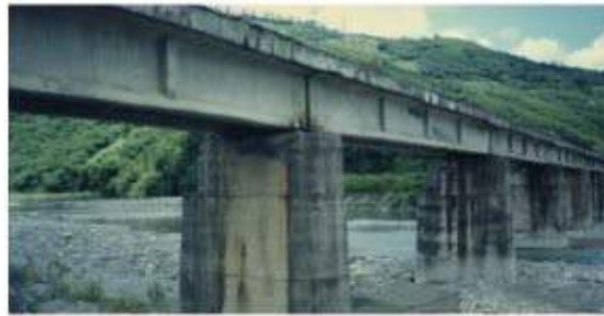
照片 8-5a 東線鐵路早期的預力樑橋
