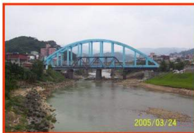
照片 6-8 新舊跨基隆河鐵路八堵橋並列
