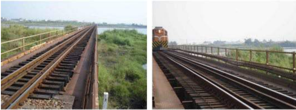
照片 6-46、47 屏東線林邊溪橋
