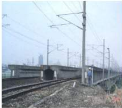
照片 8-10 1988 年第二大崙炭溪橋之預力 U 型梁
