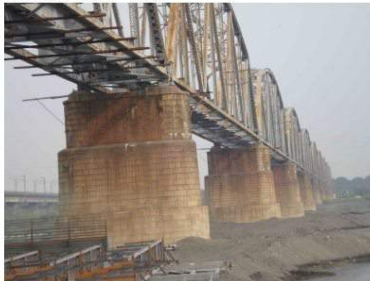
照片 2-1 鋼桁架橋砌塊石橋墩（高屏溪舊鐵橋）
