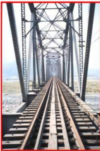
照片 1-8、1-9 下承穿式鋼桁橋（跨距 62.4 公尺）
