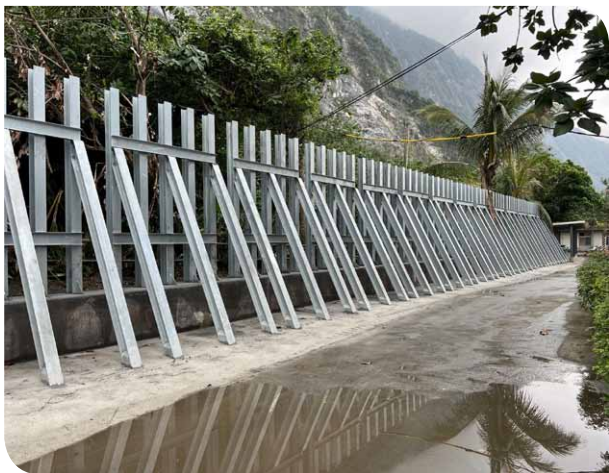
▲崇德站邊坡護欄
