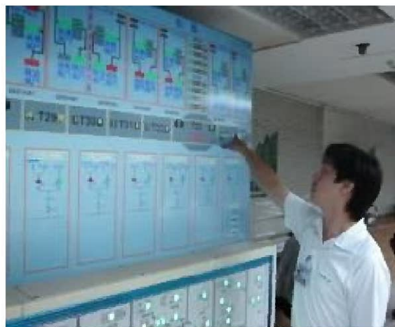
圖 2 隧道中央監控系統(DLP 投影)
