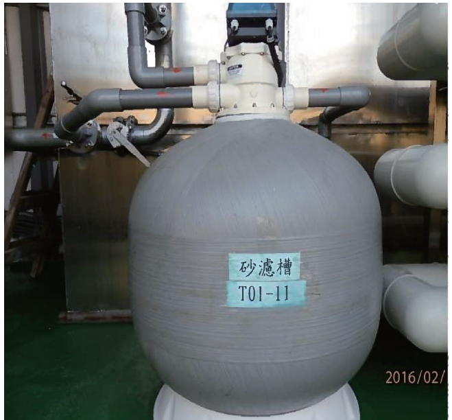
圖 9 砂濾槽過濾處理水
