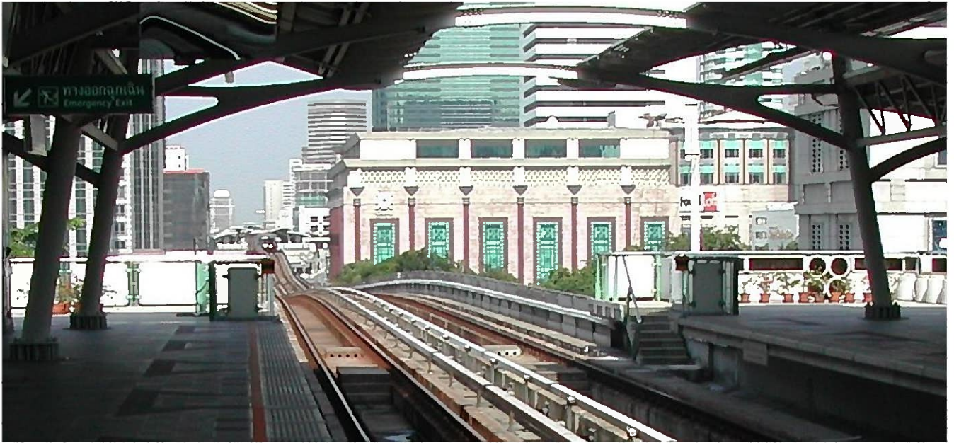
圖10 泰國曼谷高架捷運系統的駝峰式縱面線形
