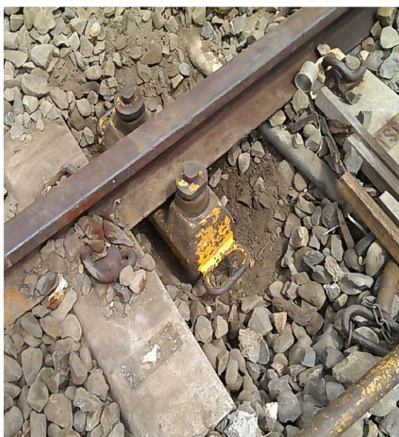
改良前(拉軌器安裝於軌底)
