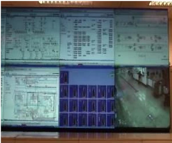
圖 1 車站中央監控系統(DLP 投影)
