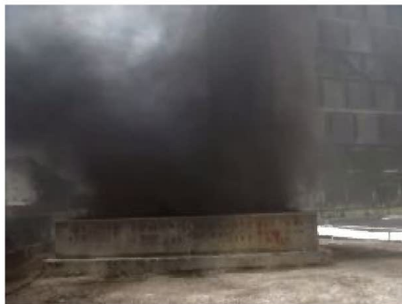
圖19隧道通風口排煙情形
