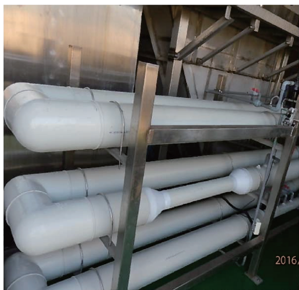
圖 4 迴流管使藥劑與污水充分混合
