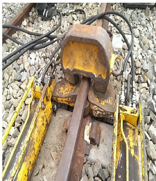
改良後(拉軌器安裝於軌頭)
