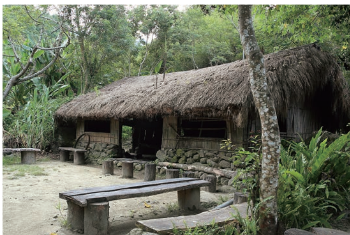
板岩牆基、木材樑柱和茅草覆頂的布農族住屋。
