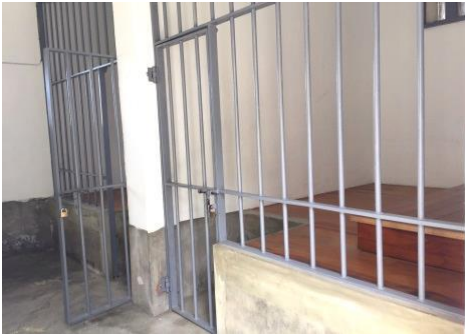
圖 3-15 鐵道二館拘留所
