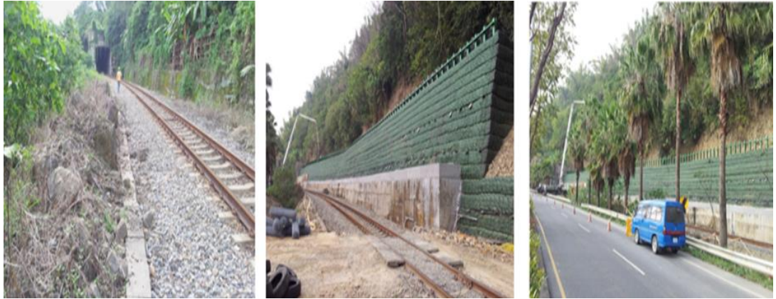
圖16.集集支線K25+560邊坡落石整治實績
