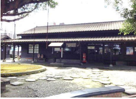
圖 3-13 鐵道二館舊工務段
