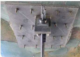
圖 31 端錨混凝土封頭
