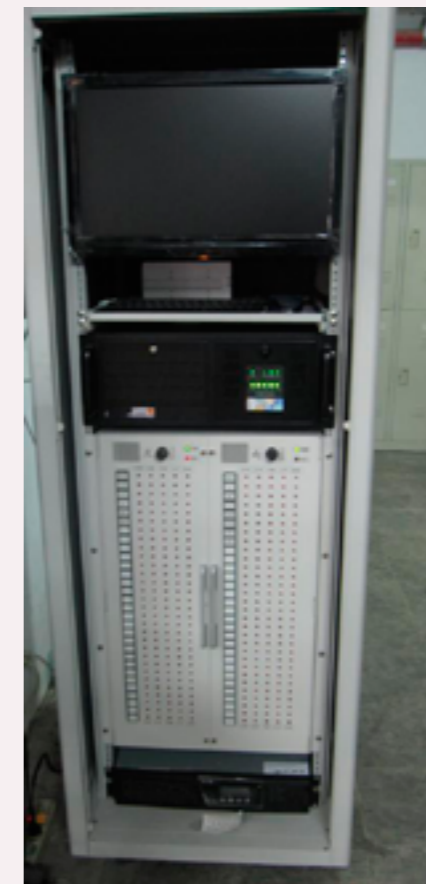
後龍號誌分駐所平交道監視系統新設工程
