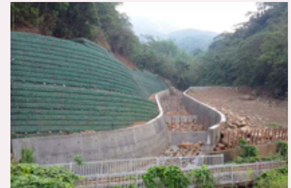
集集邊坡崩塌修復工程
