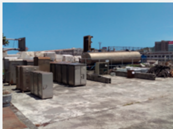
露天存料分區堆置並豎立標示牌 (1)
