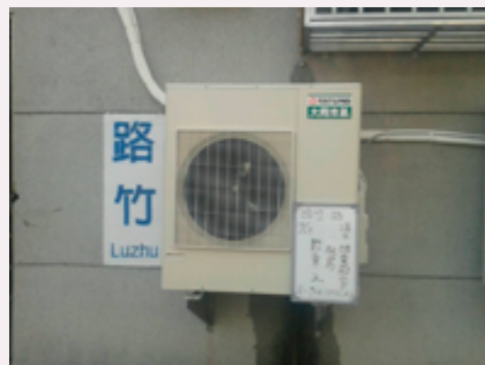
路竹站繼電室冷氣更新
