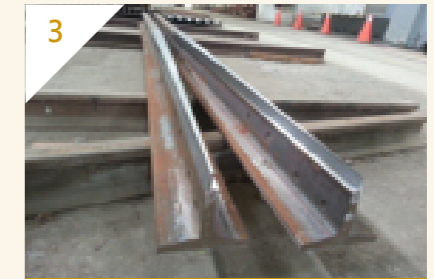
3 踏面、輪緣線及靠密線刨削完成
