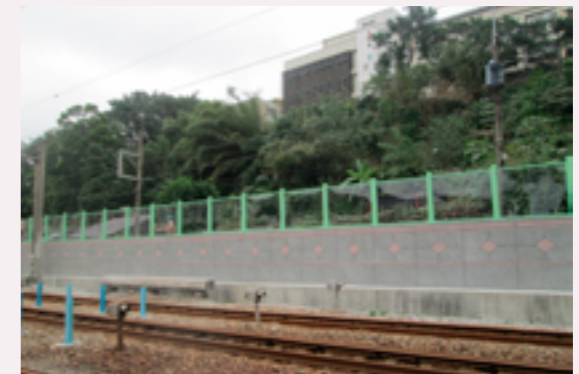
瑞芳隔音牆工程
