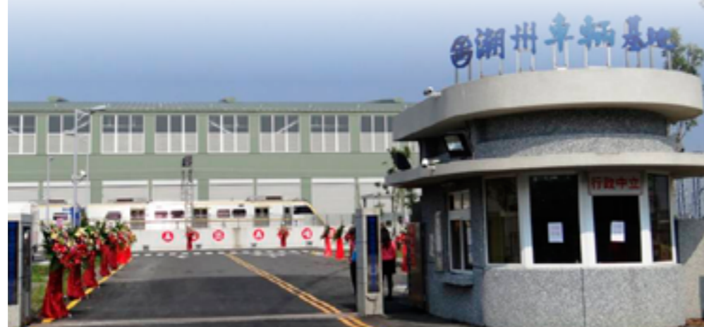
屏潮鐵路雙軌電化暨潮州基地啟用
