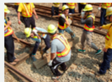
應召員參與枕木抽換工程訓練情形
