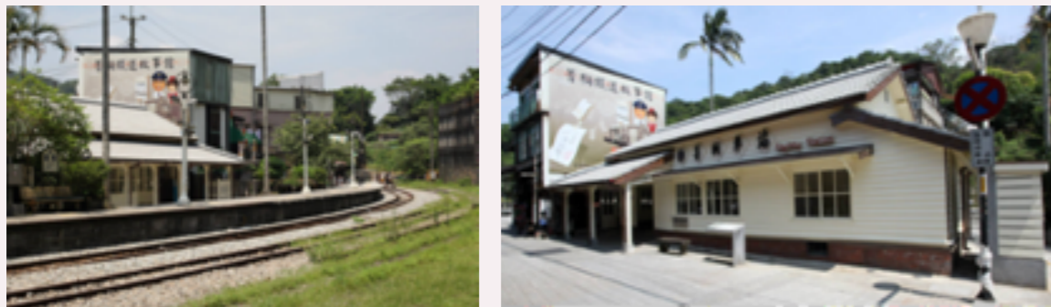
菁桐車站古蹟修復工程
