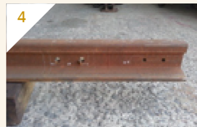
軌腹加工區劃記 註：以中心衝與白漆筆將加工區域標示於鋼軌腹部
