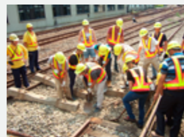
應召員參與枕木抽換工程訓練情形
