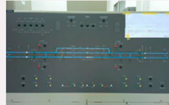
桃園臨時站號誌系統升級為電子聯鎖
