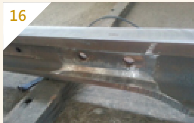
連接板接合面研磨作業
