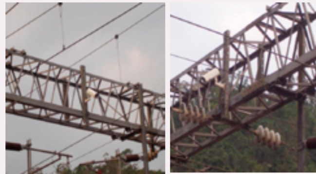
裝設監視設備
