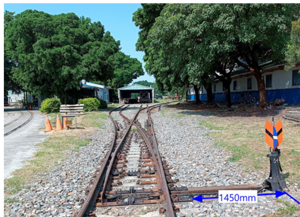
照片⑤ 關節式左開道岔 50kg-N #8 號關節式左開道岔，中型標誌型轉轍器距離聯通床板 1450mm
