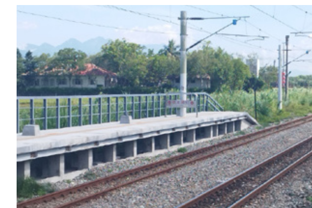
三民站完成月臺提高工程
