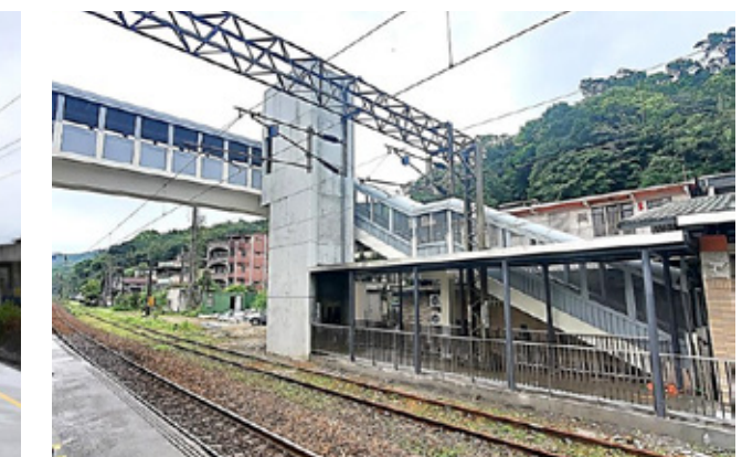
貢寮站新設無障礙電梯
