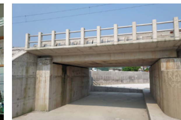
下七結橋改建工程（北側）
