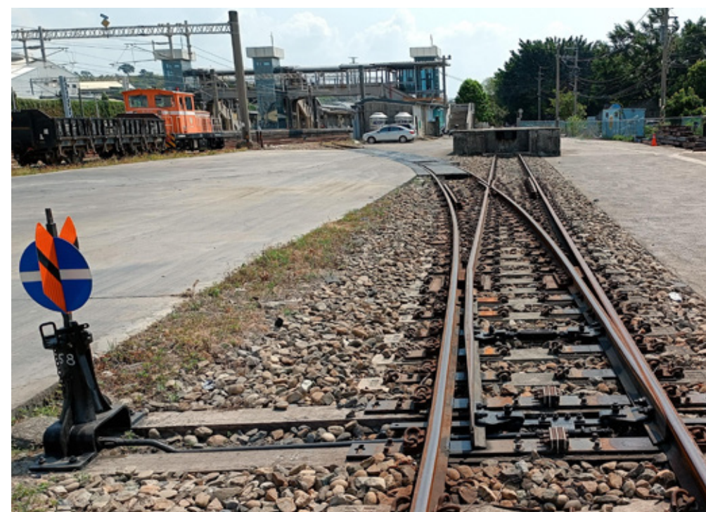
照片⑥ 轉轍器置於左側 與照片 5 相比，同樣是 50kg-N #8 號關節式左開道岔，轉轍器安裝位置不同
