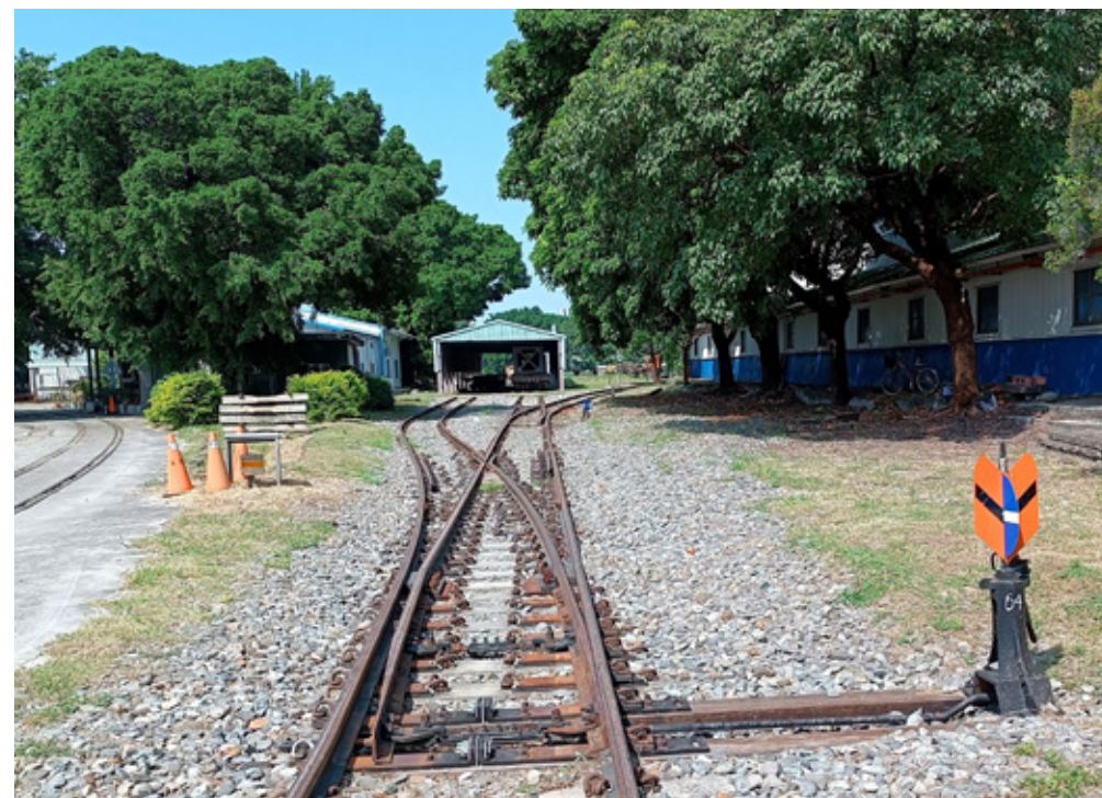
照片① 轉轍枕仍為木枕 目前使用之 50kg-N #8 號關節式道岔轉轍枕仍為木枕
