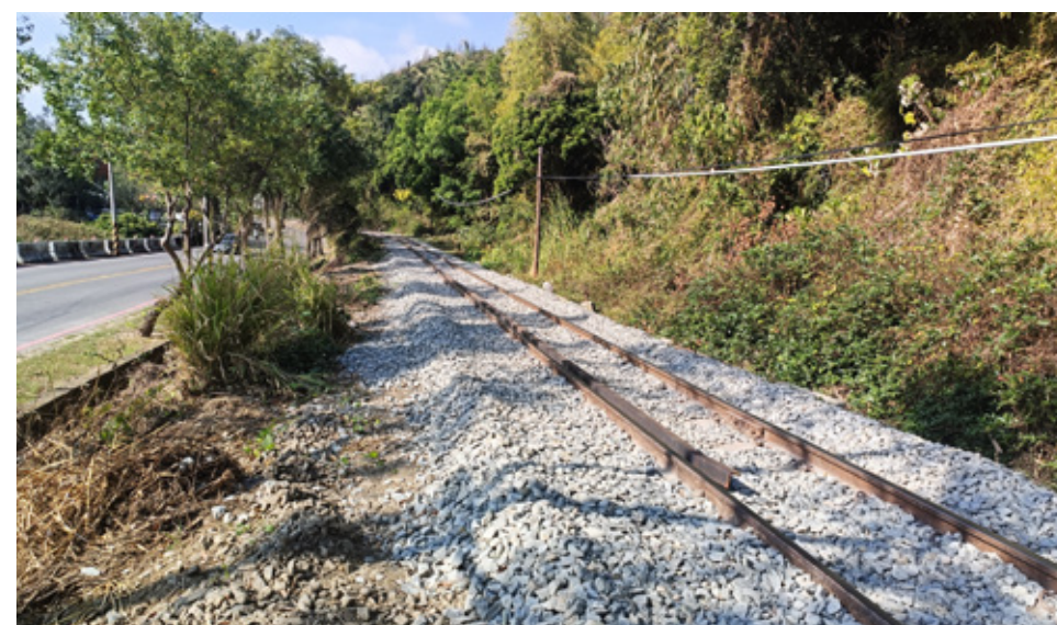
軌道工程（抽換石碴）
