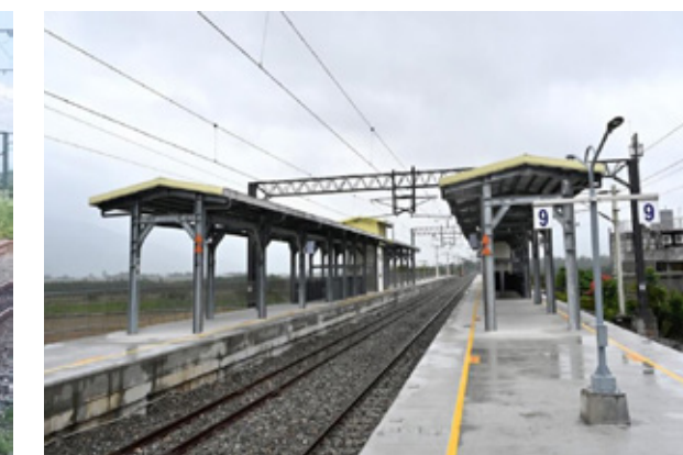
東里站完成月臺提高工程
