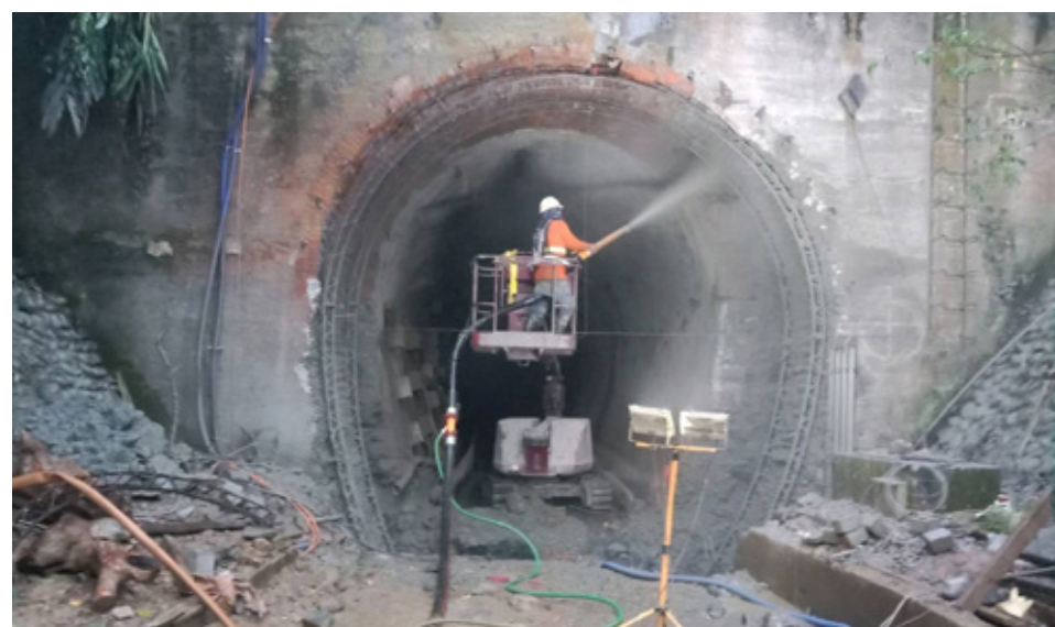
隧道及邊坡改善統包工程（噴凝土澆置）
