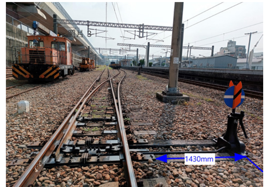
照片④ 關節式右開道岔 50kg-N #8 號關節式右開道岔，中型標誌型轉轍器距離聯通床板 1430mm
