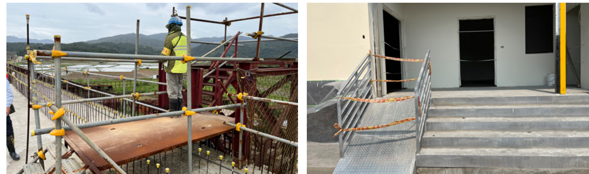
針對在建工程，實施不預先通知工程督導
