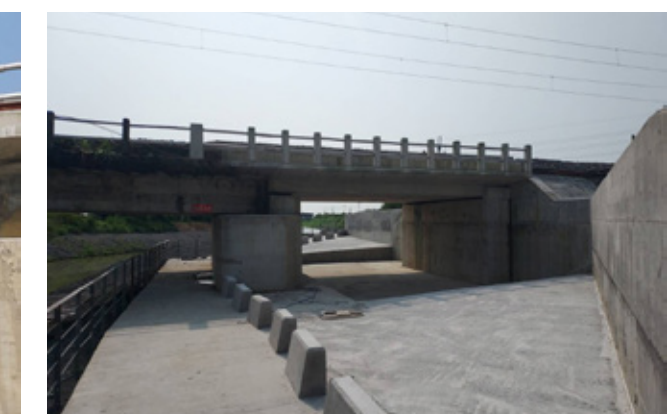
下七結橋改建工程（南側）
