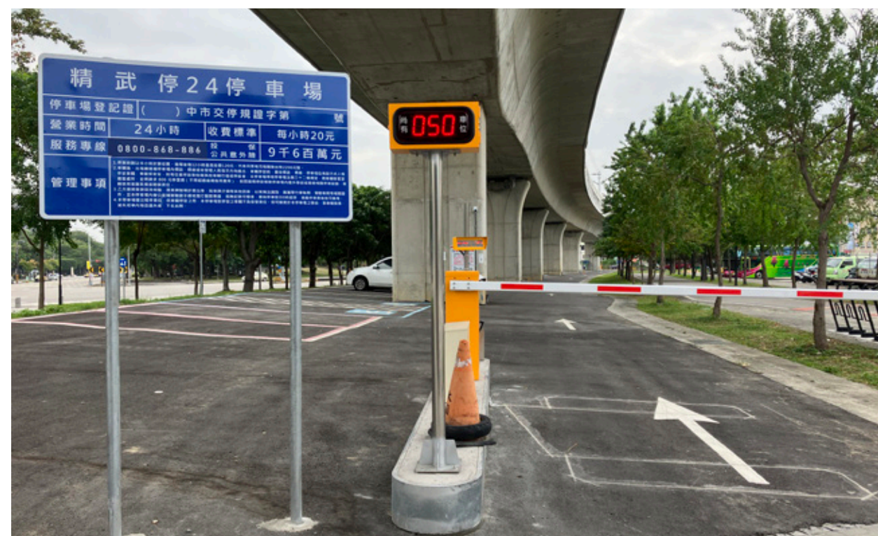
臺中都會區鐵路高架橋下停車場
