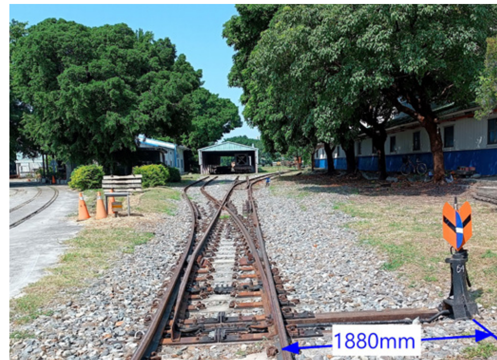
照片③ 中型標誌型轉轍器 中型標誌型轉轍器距離軌距線 1880mm
