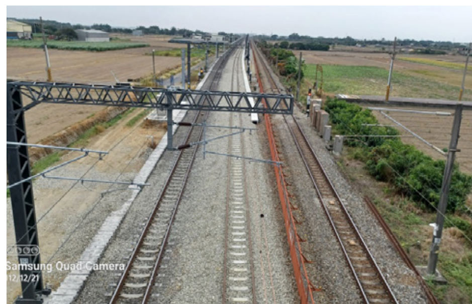
溫厝廊溪橋改建工程
