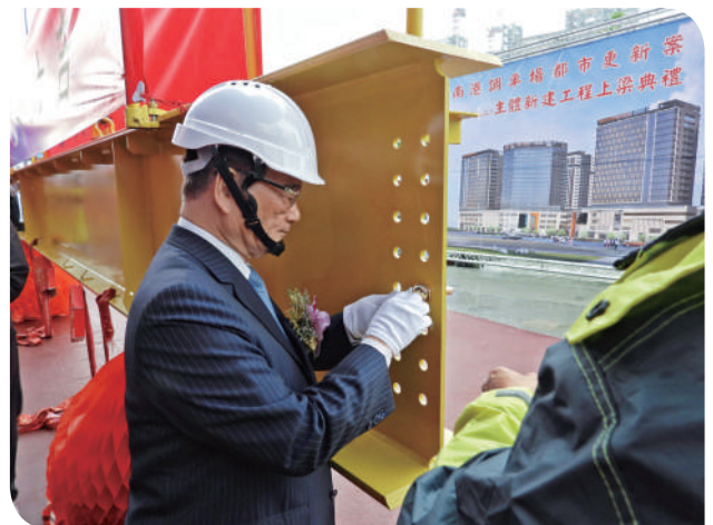
▲鄭光遠董事長親自為「臺鐵棟大樓」上梁安裝金螺栓
