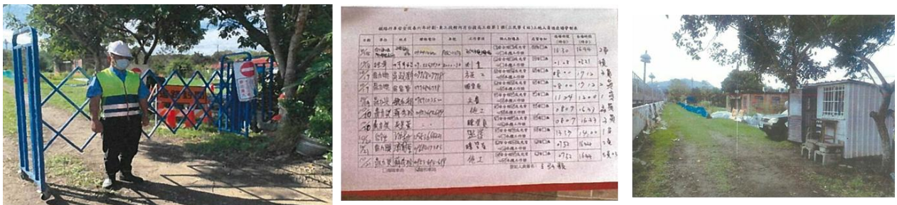
圖 3 臺鐵工地安全管理
