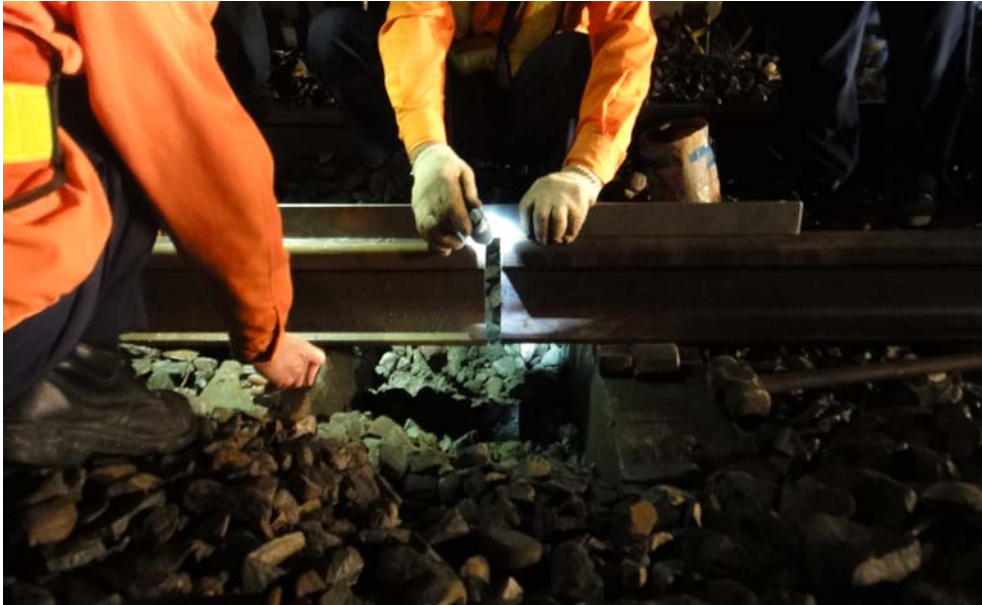
圖 4-7 焊接軌縫量測作業
