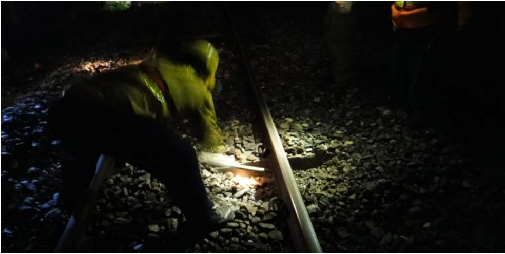
圖 4-3 道碴挖掘作業
