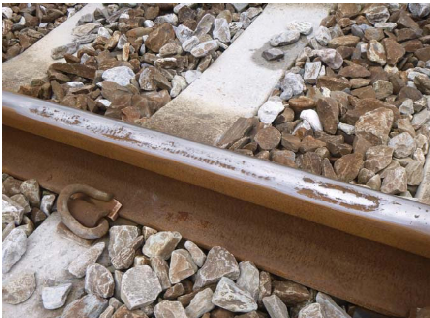
圖 3-18 車轍槽型波狀磨耗(b)
