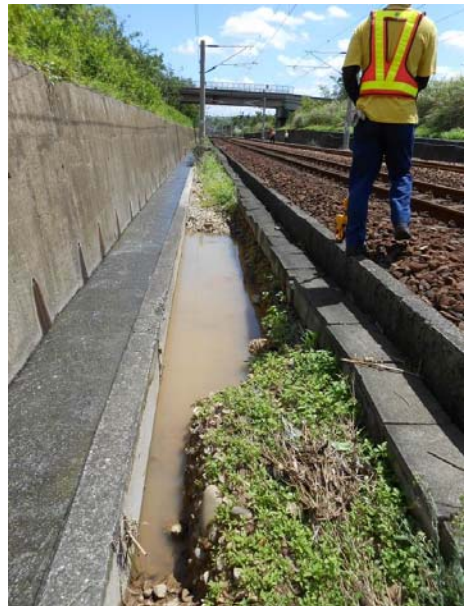
圖 2 U 形道床外側水流沖刷
