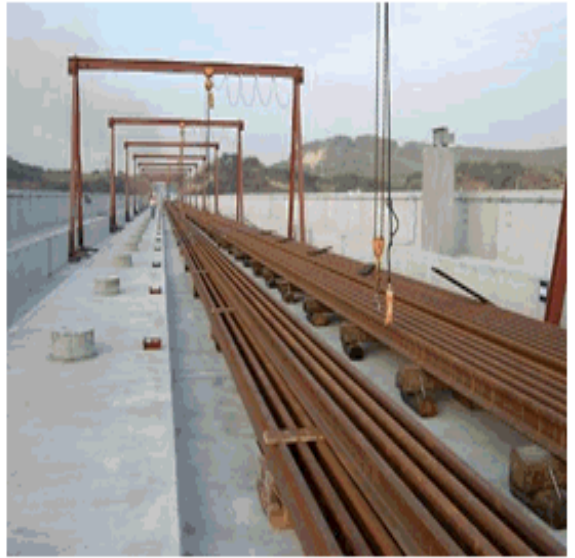
圖 2-6 鋼軌銲接完成儲放區
