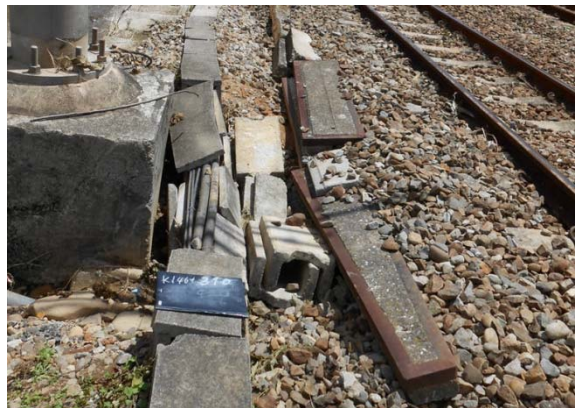
圖 18 作為臨時石碇擋牆
