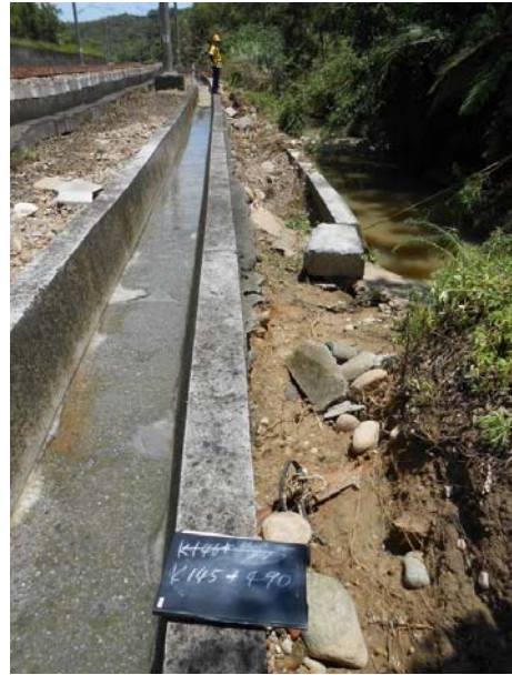
圖 4 U 形道床外側水流沖刷
