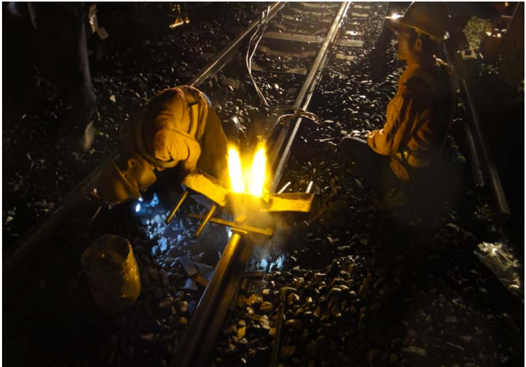
圖 4-11 預熱及防漏檢查
