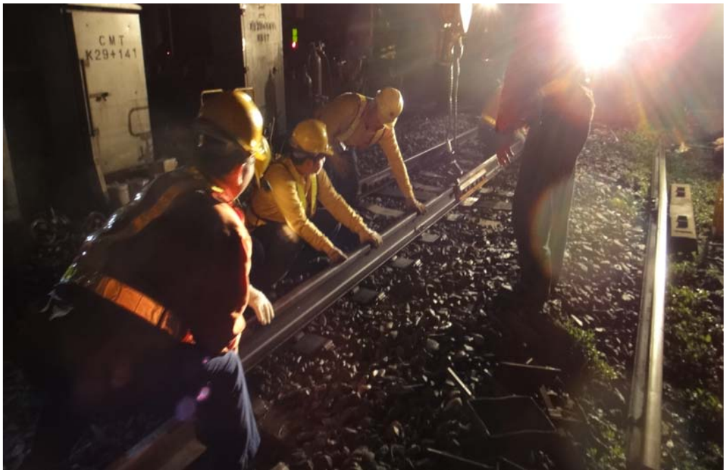
圖 4-6 鋼軌更新吊運作業
