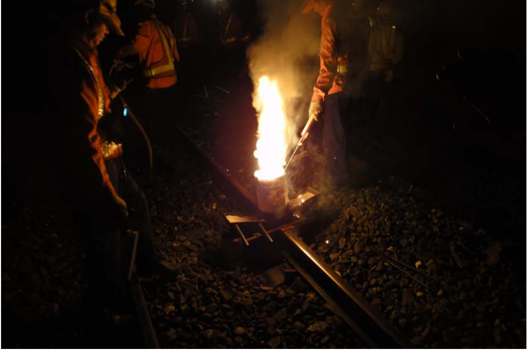
圖 4-12 放置坩鍋及點火作業
