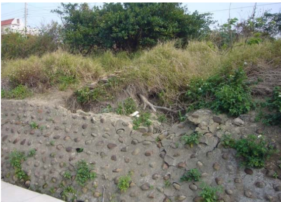
圖 17 漿砌卵石護坡背填土被沖刷
