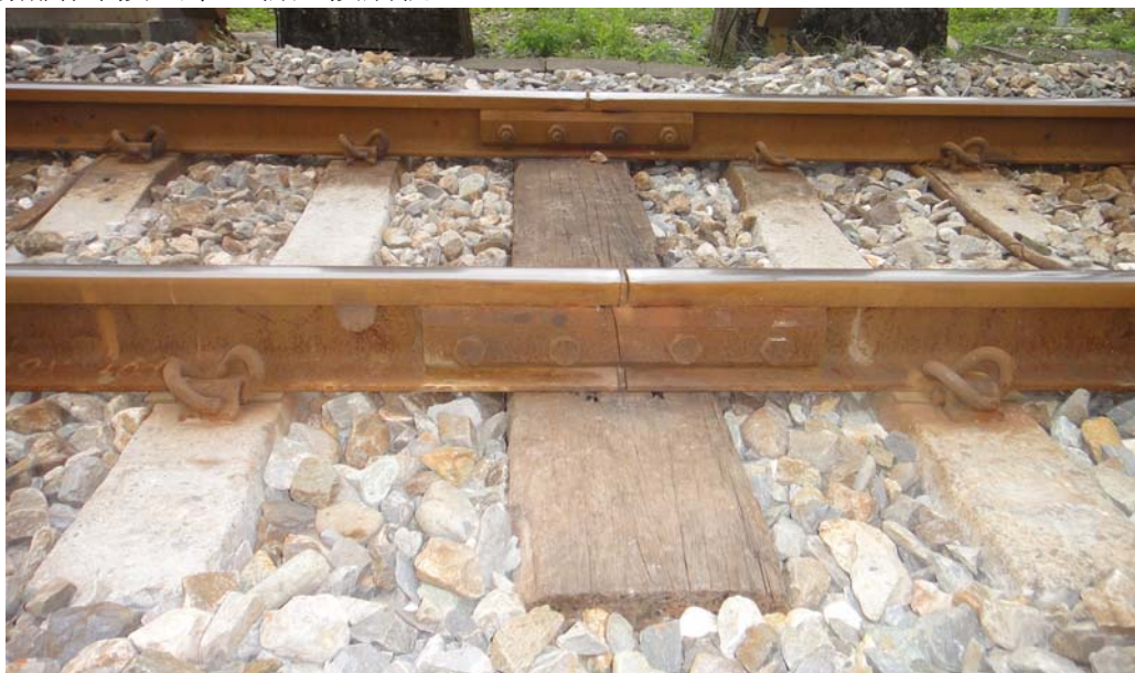
圖 4-1 鋼鈹斷裂
