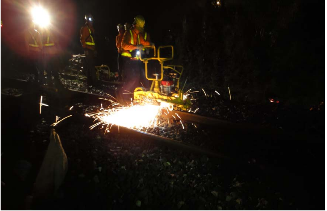
圖 4-17 磨軌機研磨作業
