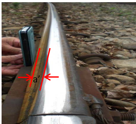
圖 4 集集線鋼軌磨耗
