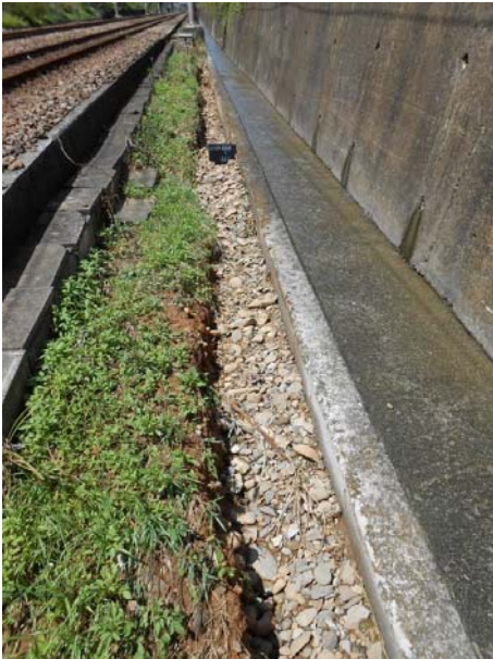
圖 1 U 形道床外側水流沖刷
