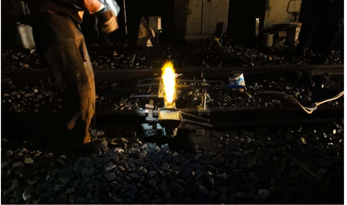
圖 2-2 熱劑焊接法現場施工
