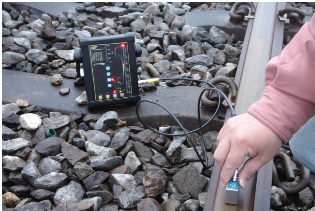
圖 4-19 鋼軌焊道現場檢測
