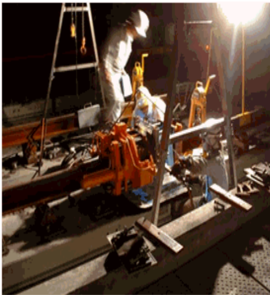
圖 2-9 瓦斯壓接焊接法
