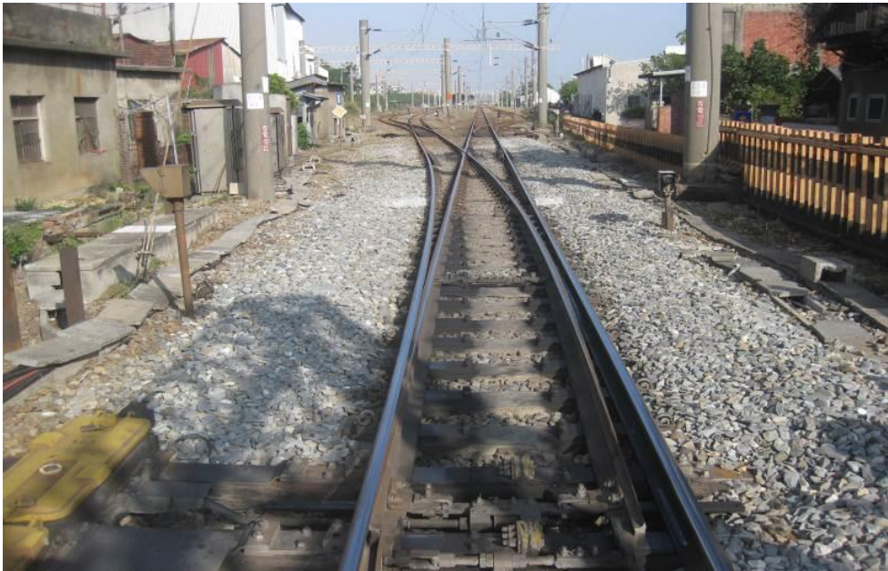
照片 17 試鋪完成
