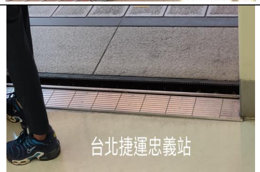
上下車門處安裝橡膠材
