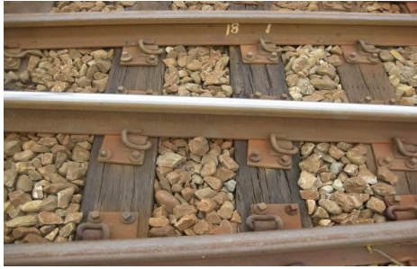
照片 2-1 木枕型道岔枕木照片
