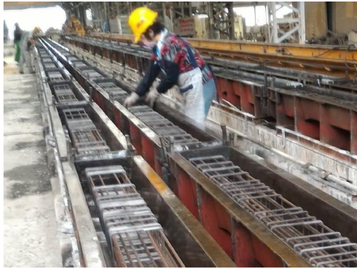
照片 5 PC 枕生產線
