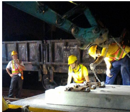
照片 14 PC 枕吊掛
