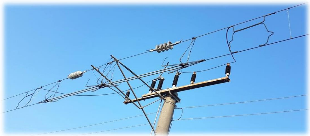
圖 5-1 傳統高壓分相裝置設備現場照片
