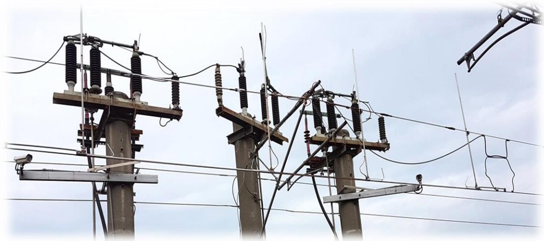
圖 5-2 新型高壓分相裝置 NSR-25 現場照片
