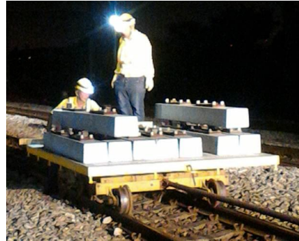
照片 12 即將抽換之 PC 枕
