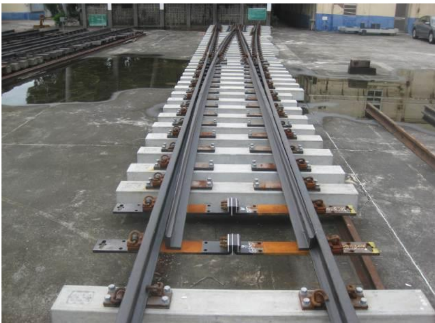
照片 10 50kg-N #12 右開木枕型道岔 PC 枕化試組裝
