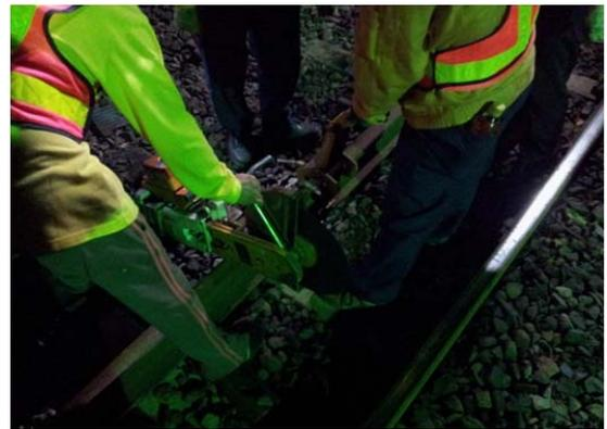
圖 3-42 抽換鋼軌作業現況
