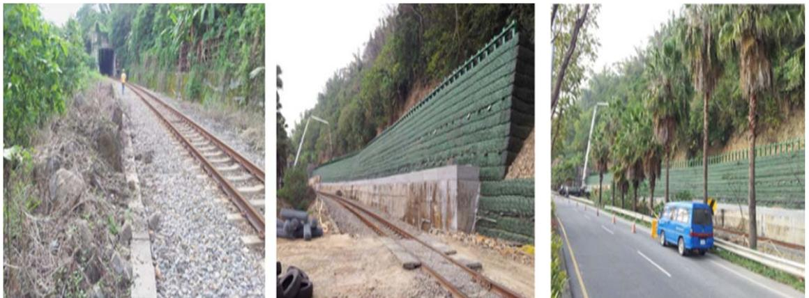
圖 3-30 集集支線 K25+560 邊坡落石整治實績
