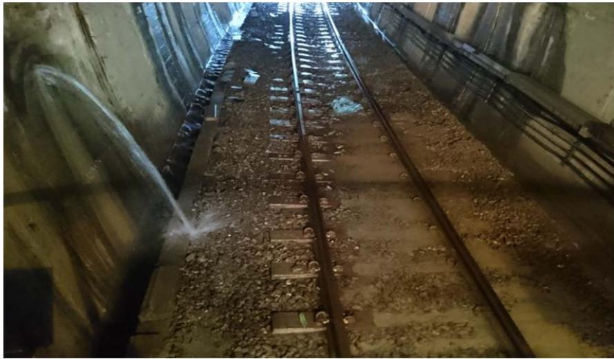
圖 3-27 集集支線中興隧道排水設施不良示意圖
