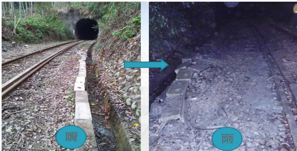
圖 3-26 集集支線 1 號隧道南口排水設施不良示意圖
