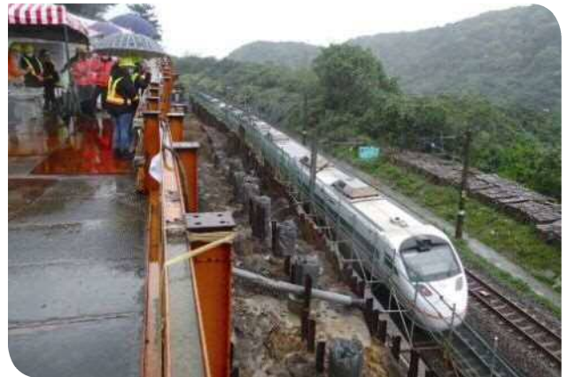
▲偵測列車接近工地時提早通知施工人員
