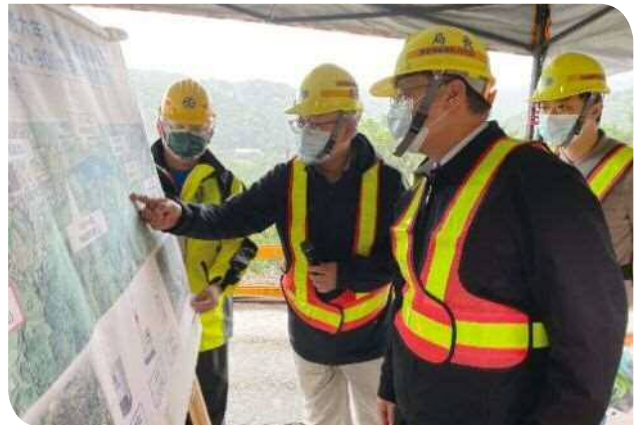
▲局長聽取工務處王兆賢處長宜蘭福隆石城邊坡改善工程說明
