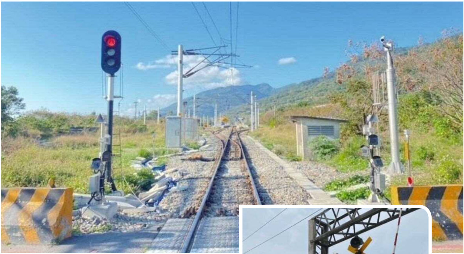
▲平交道障礙物自動偵測系統雷達偵測立柱及熱影像攝影機
