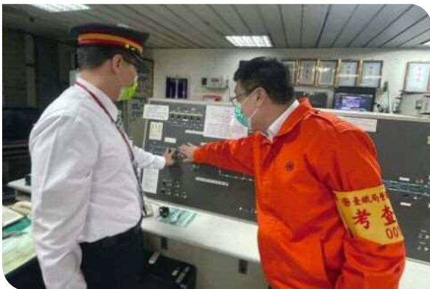
▲局長考查列車進出站號誌控制情形
