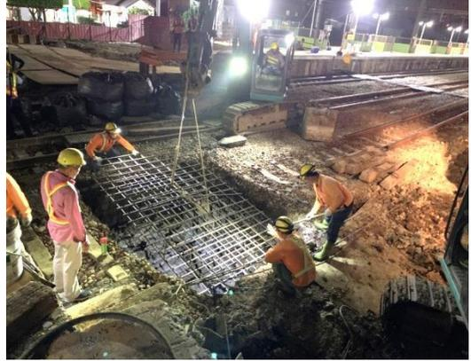
圖 18 支承座混凝土澆置
