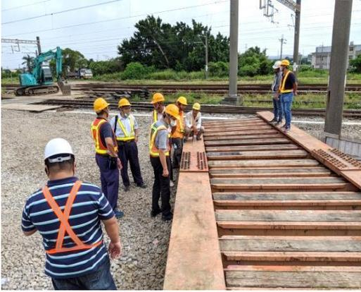
圖 22 吊車臨時通道鋪設
