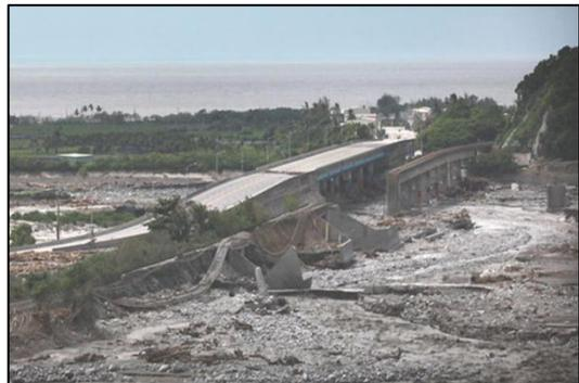
圖 1-1：莫拉克颱風災害，導致太麻里溪左岸潰堤、鐵路路基流失
