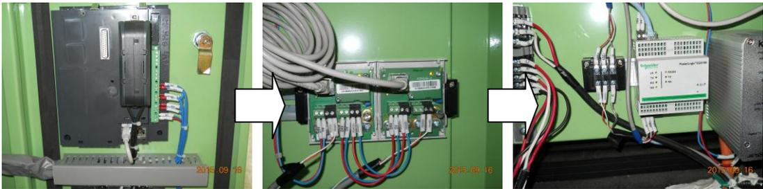
圖 16 過電流保護電驛與通訊介面模組連接方式
