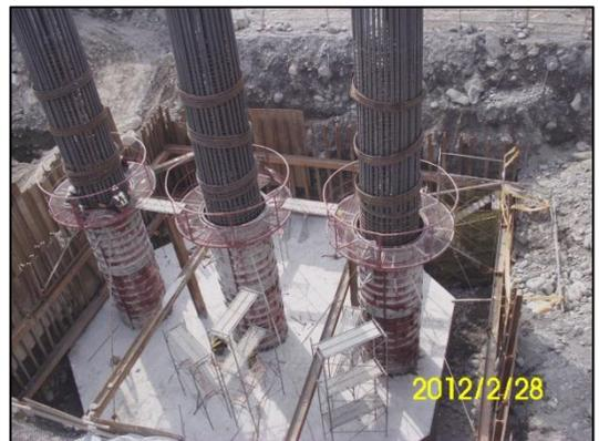
圖 2-3：基樁樁帽及橋墩施工
