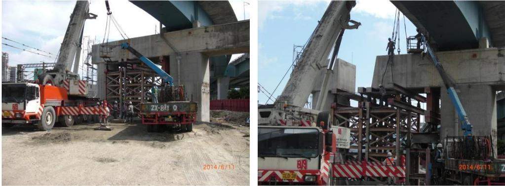
圖 25 PF01 墩柱切除施工現況
