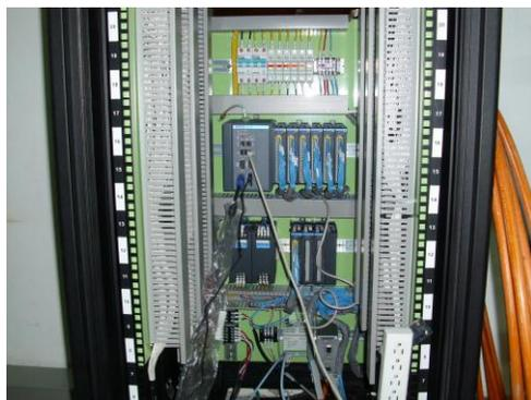
圖 5 微電腦 PLC/RTU
