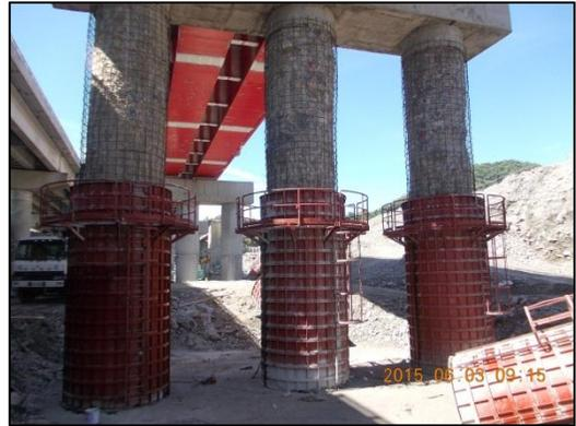
圖 3-13：樁柱表面修平，以 RC 包墩補強並做為防撞保護層
