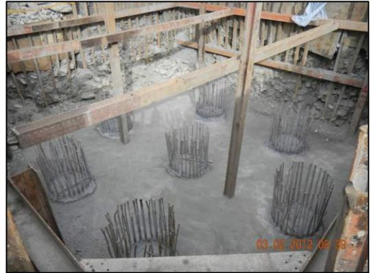
圖 2-2：河中段全套管基樁施工
