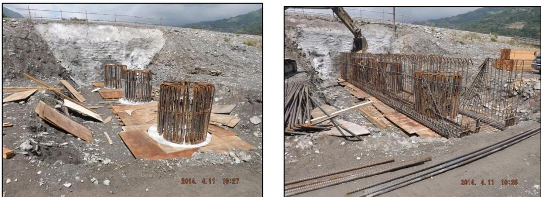
圖 3-5：路基段帽梁施工
