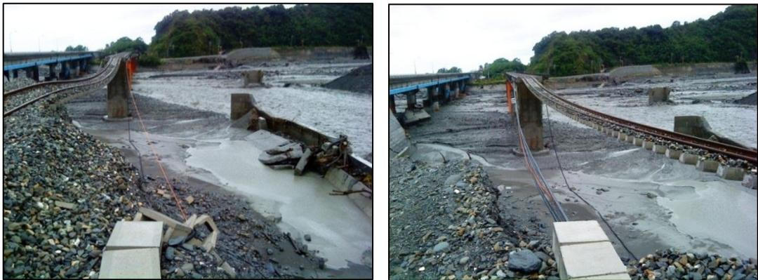
圖 1-2：凡那比颱風災害，左岸鐵路橋台及路基流失
