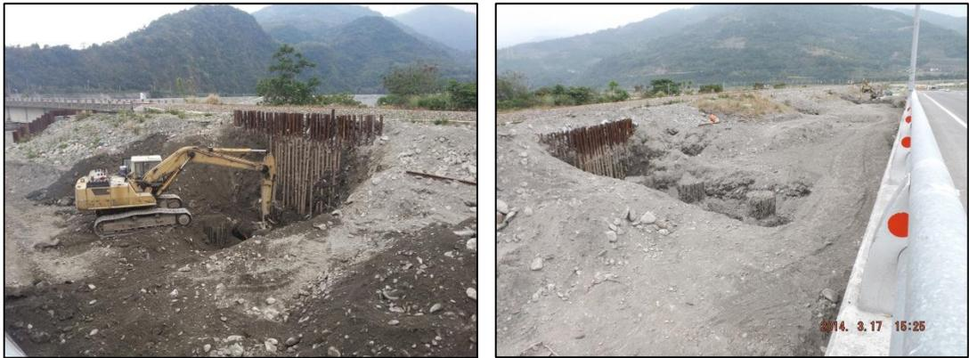
圖 3-4：路基段新橋墩，施設擋土牆及開挖樁柱
