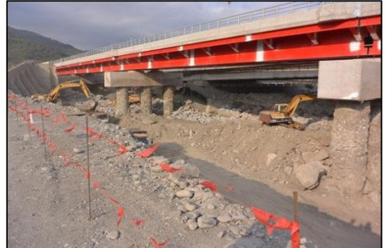
圖 3-10：新橋通車後再開挖河道，樁柱裸露表面粗糙
