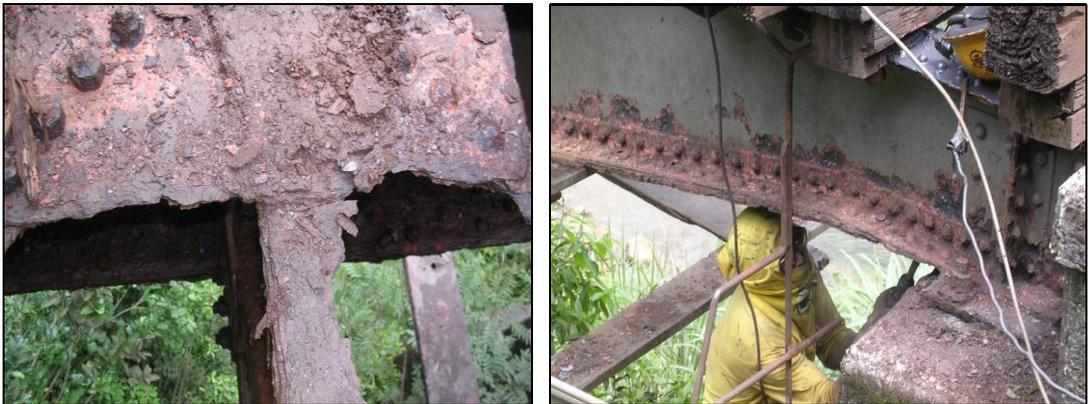
圖 1-2 各橋鋼梁嚴重鏽蝕情況
