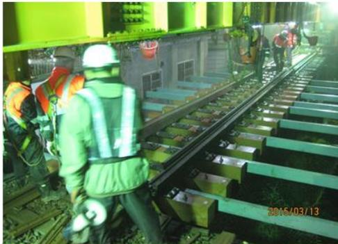
鋼軌回鋪及人行步道C型鐵安裝
