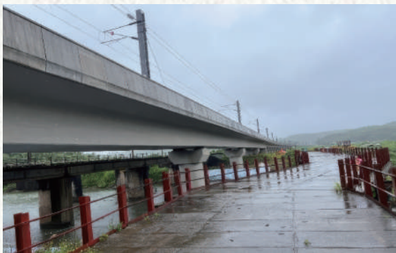
第三雙溪及新社橋改建工程——由橋下往橋上拍攝
