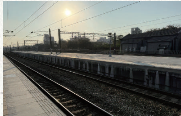
斗南站月臺提高完成
