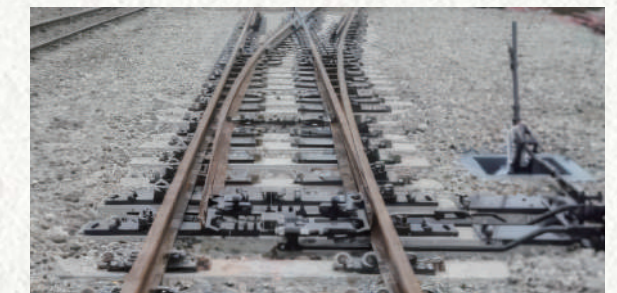
PC 枕型道岔更新工程（更新後）
