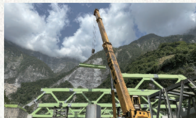
東小清水溪橋（和仁＝崇德間）改建工程施作中
