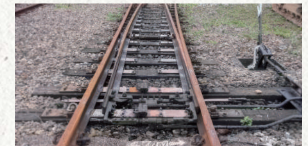
PC 枕型道岔更新工程（更新前）
