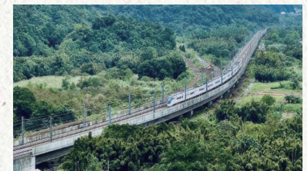
第一、二雙溪橋軌道切換後實景
