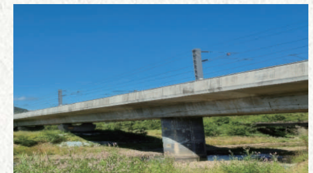
第一、二雙溪橋改建工程——橋梁底
