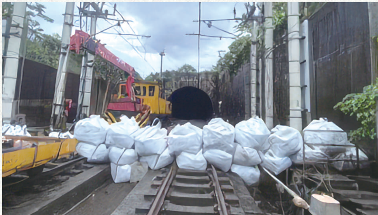
花蓮工務段在光復隧道南口堆置太空包
