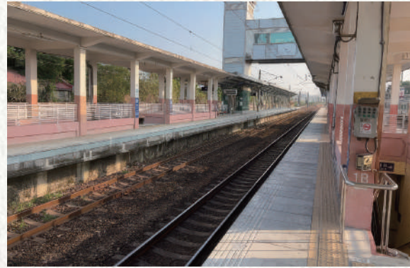
隆田站月臺提高完成
