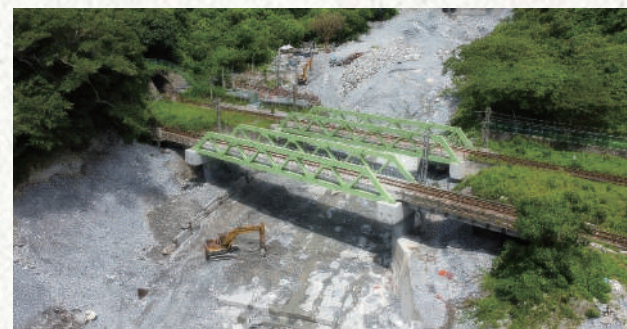
東小清水溪橋（和仁＝崇德間）改建工程竣工
