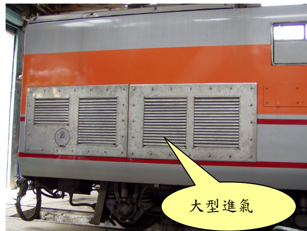
圖 8-1 風泵側板改造後
