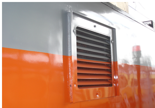
圖 6 鼓風機進氣口阻水導槽安裝實圖
