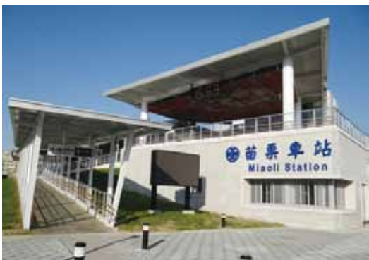
計畫名稱：台鐵都會區捷運化暨區域鐵路後續建設計畫（基隆 - 苗栗段） 工程名稱：苗栗站跨站式站房新建工程 說明：苗栗站現況圖
