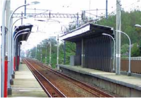
計畫名稱：台北機廠遷建設計畫 工程名稱：機務段第一期工程 (CL321-2) 說明：B10-1 裝修完成。
