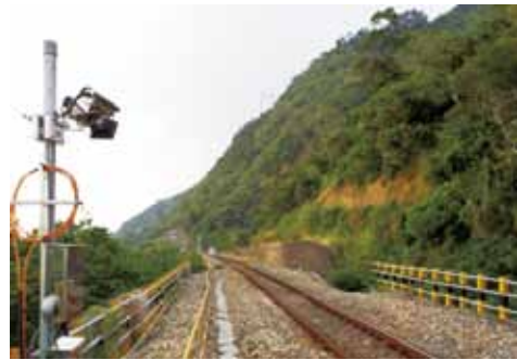
▲ 南迴線 K11+600 高風險路段監視器 Monitor at the high-risk section K11
