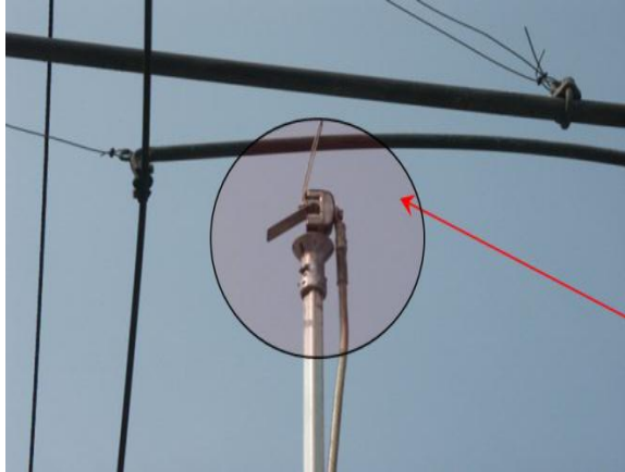
圖 10 斷電後掛接第一支接地裝置應注意初觸有輕微放電現象
