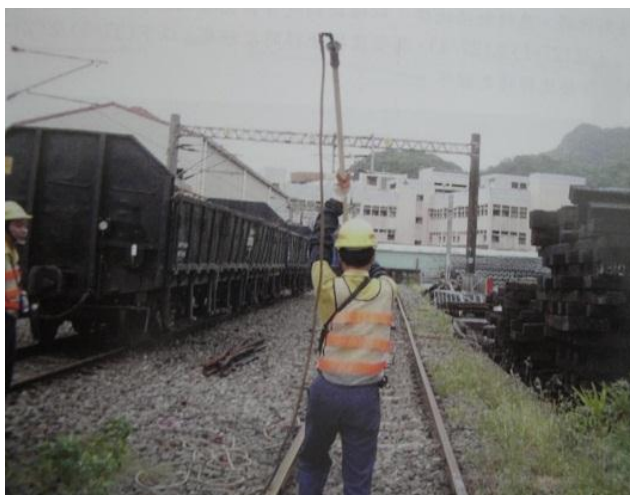
圖 7 由 1 人實施接地作業
