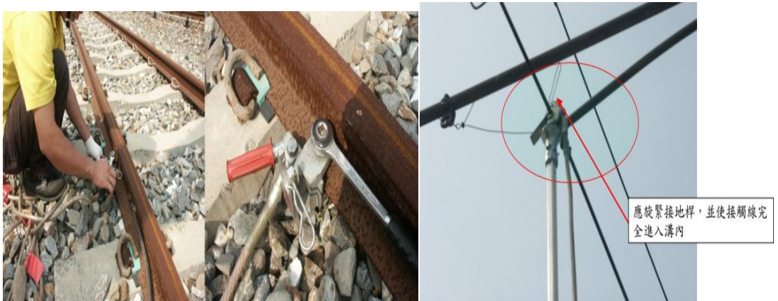
圖 9 確認已斷電「先夾後掛，拆掛去夾」
