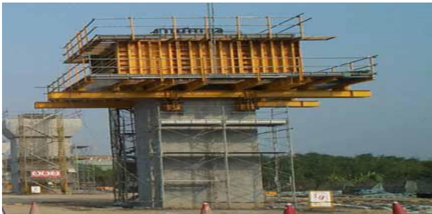
圖 25 防止墜落事故以 GIP 鋼管設置護欄
