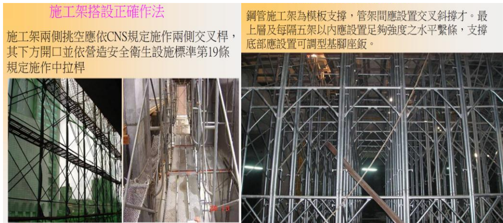
圖 14 施工架搭設作法
