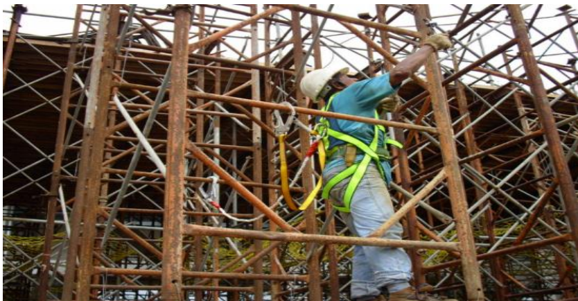
圖 16 施工架作業人員安全帽與使用安全帶
