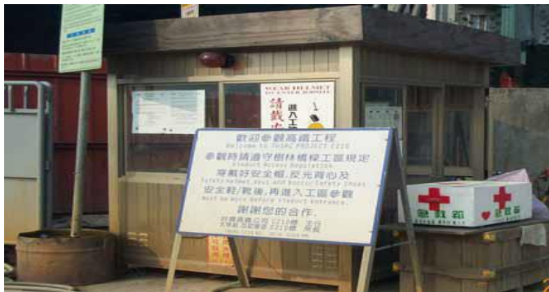
圖 19 地出入口設置檢查站，以告示牌告知出入人員應具備之防護具。
