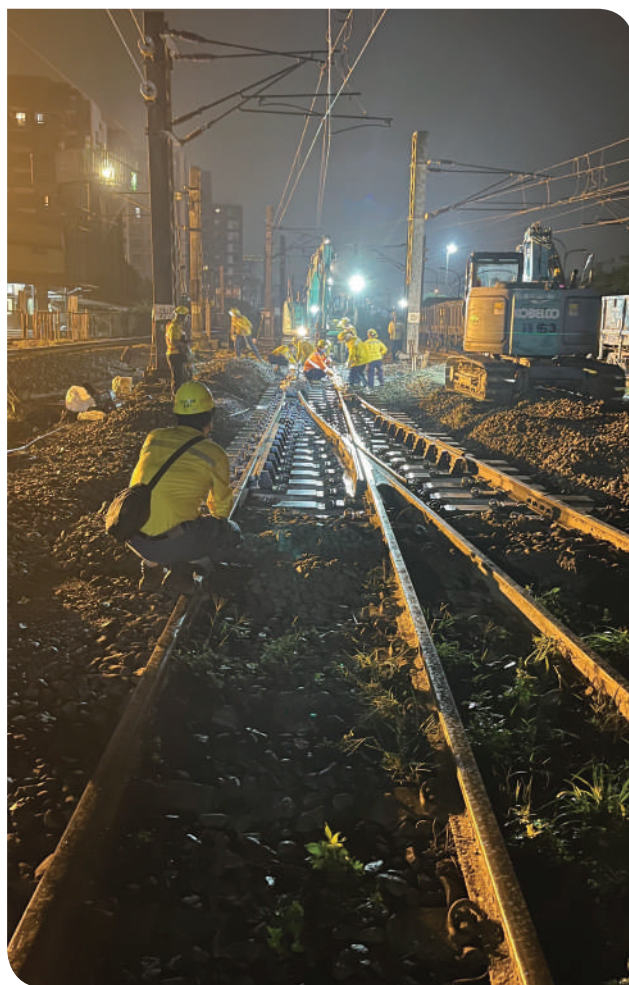
▲道岔鋪設完成平面測試
