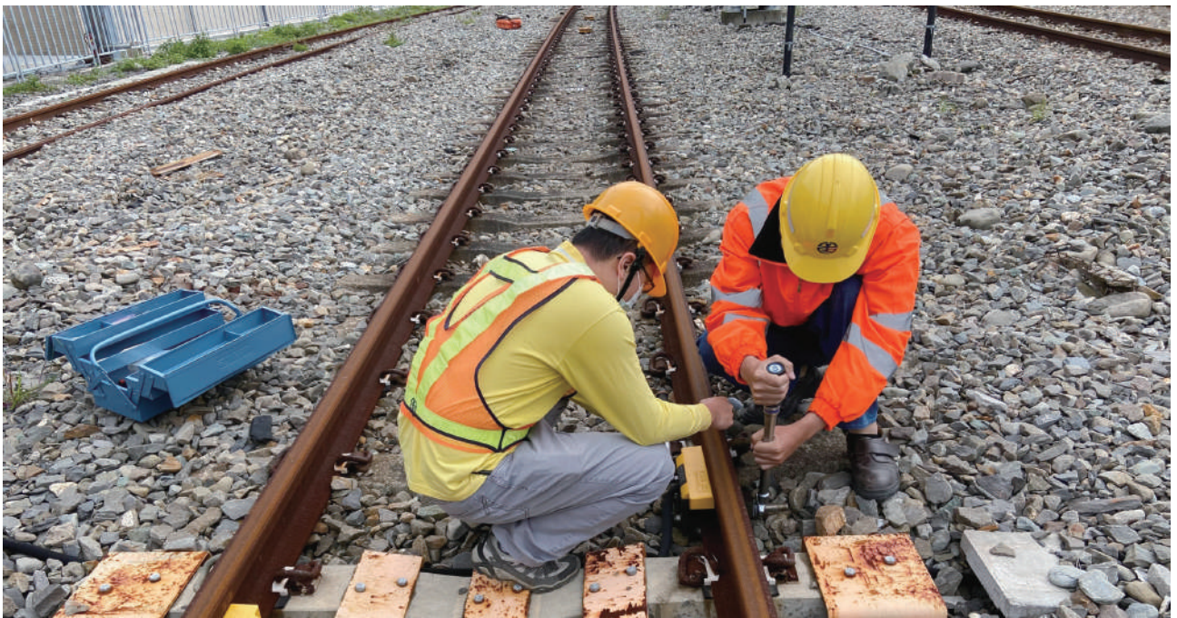
▲軌道電路檢修
