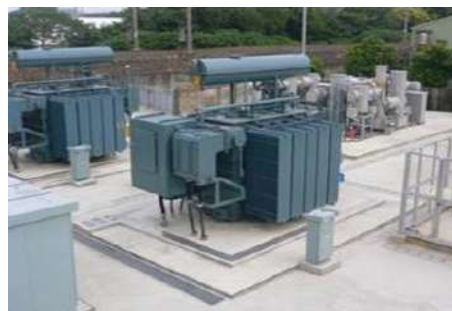
圖 3.2 25MVA 變壓器
