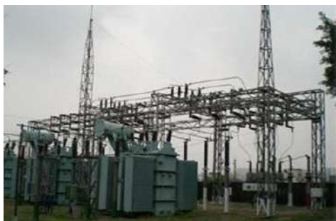
圖 3.1 10MVA 變壓器
