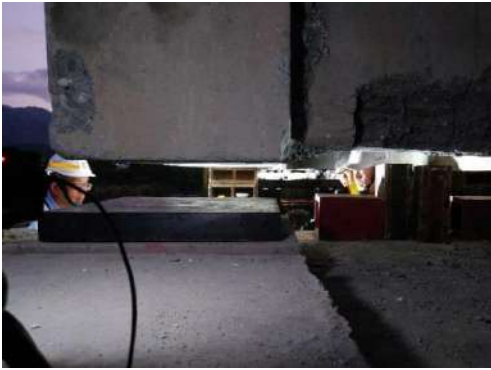
圖4-7 新秀姑巒溪橋落座作業前完成清理施工
