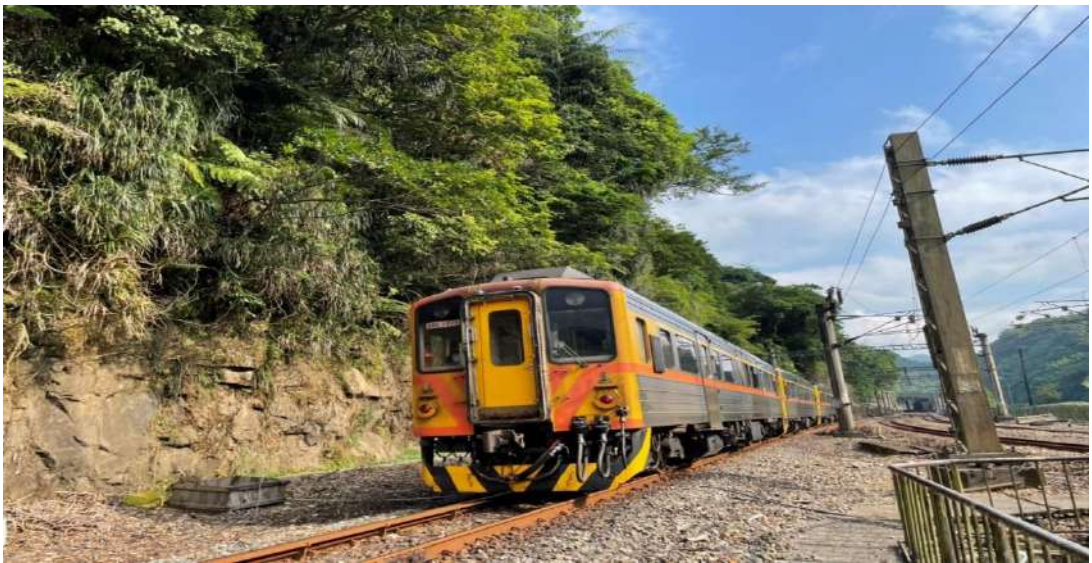
圖 1 平溪線與宜蘭線交叉處前鐵道上邊坡樹木之影響木(賴品寬攝)
