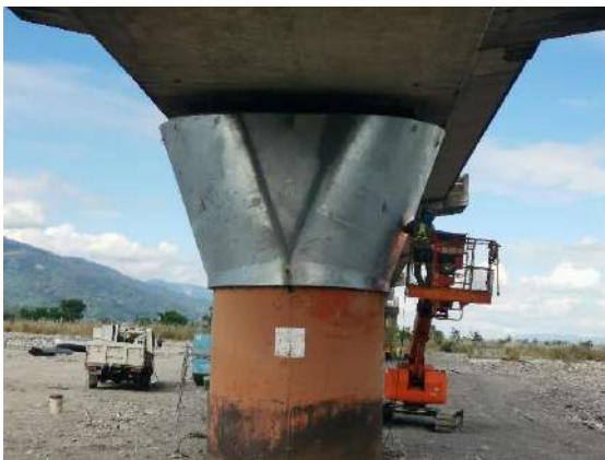
圖3-3 樂樂溪橋受損橋墩鋼板包覆施工 圖3-4 樂樂溪橋P16墩加設重型支撐架
