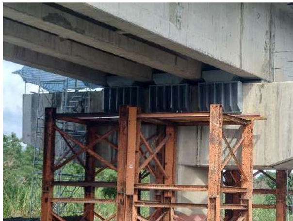
圖4-9 新秀姑巒溪橋鋼製止震塊施工(一)
