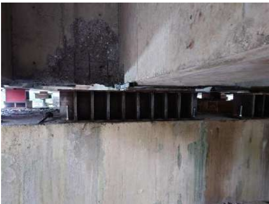
圖4-5 新秀姑巒溪橋橫移之橫移梁架設
