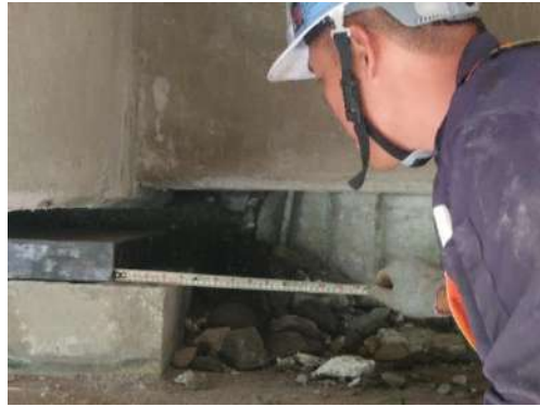
圖4-8 新秀姑巒溪橋落座作業精度量測
