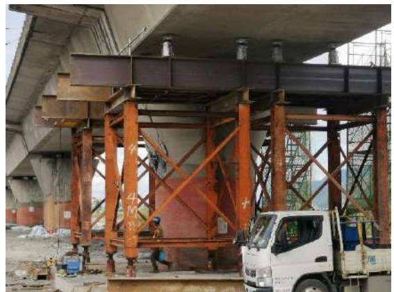
圖3-3 樂樂溪橋受損橋墩鋼板包覆施工 圖3-4 樂樂溪橋P16墩加設重型支撐架
