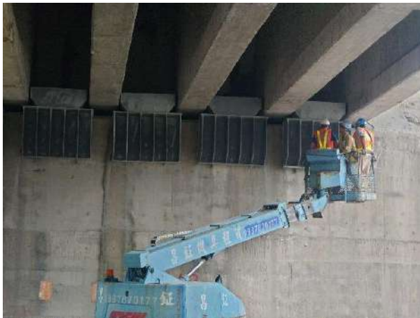
圖4-10 新秀姑巒溪橋鋼製止震塊施工(二)
