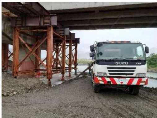
圖4-3 新秀姑巒溪橋架設重型支撐架
