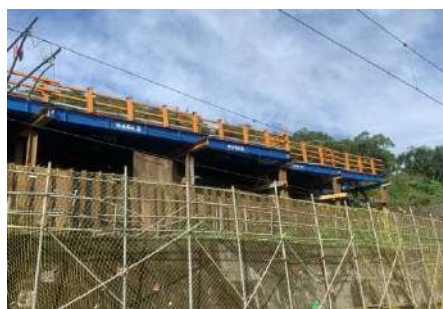
圖 2 鋼軌護欄設置情形
