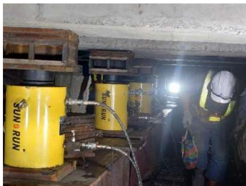
圖4-4 新秀姑巒溪橋頂舉作業架設千斤頂
