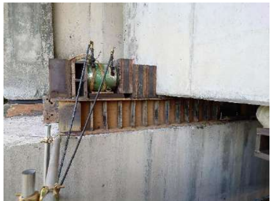
圖4-6 新秀姑巒溪橋橫移之橫移千斤頂架設
