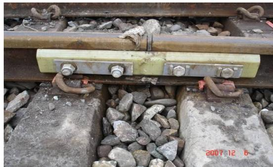
圖 10 橫渡線內之塑鋼絕緣接頭以 PC 軌枕（回收料）懸接方式裝設
