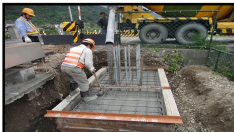
圖 11 混凝土澆置
