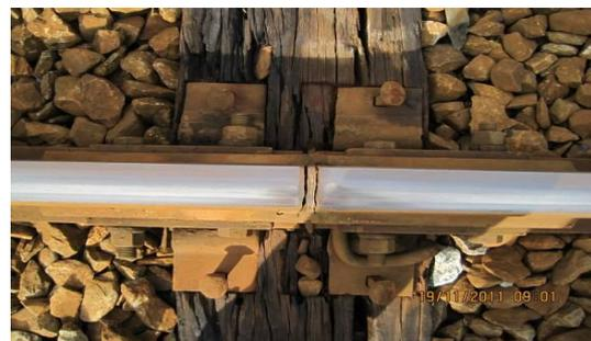
圖 6 絕緣接頭木枕加裝墊板及 303 型扣夾 2
