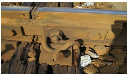
圖 5 絕緣接頭木枕加裝墊板及 303 型扣夾 1
