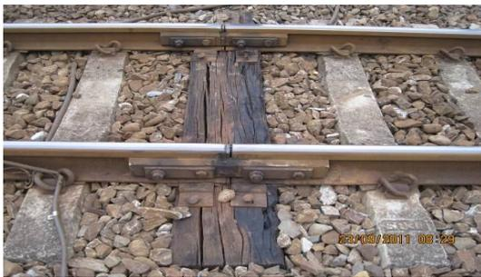
圖 3 絕緣接頭木枕加裝墊板 1
