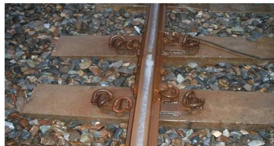
圖 31 四城站北端夾膠絕緣接頭
