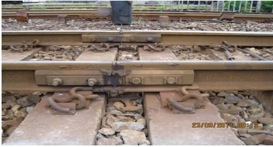
圖 32 宜蘭站內塑鋼絕緣接頭
