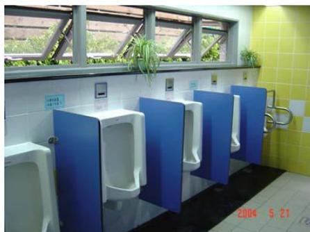
圖 24 小便器下方應設置腳踏鋪面
