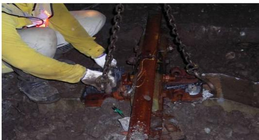
圖 15 PC 接頭大枕安裝塑鋼絕緣接頭
