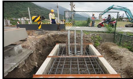
圖 10 鋼筋彎紮組立
