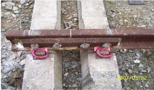
圖 7 PC 軌枕懸接方式（試裝情形）
