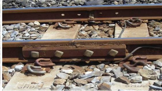
圖 22 鋪設於夾膠絕緣接頭
