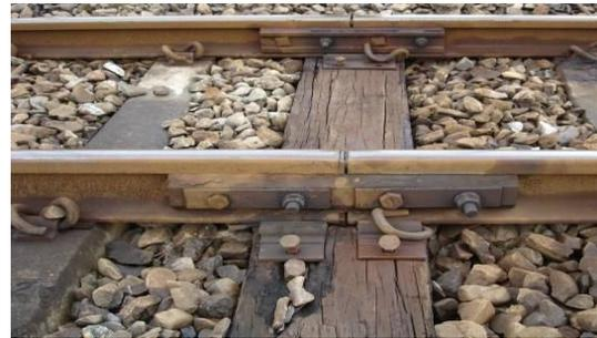
圖 4 絕緣接頭木枕加裝墊板 2
