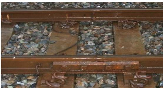
圖 30 四城站北端夾膠絕緣接頭
