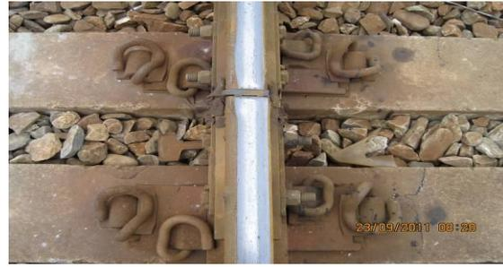
圖 33 宜蘭站內塑鋼絕緣接頭
