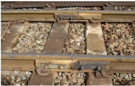
圖 9 橫渡線內之塑鋼絕緣接頭以 PC 軌（回收料）懸接方式裝設
