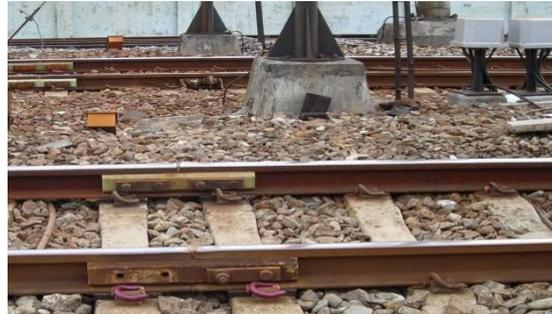
圖 8 PC 軌枕懸接方式（實裝現場）
