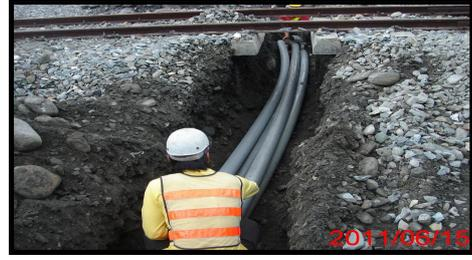
圖 14 PVC 管鋪設
