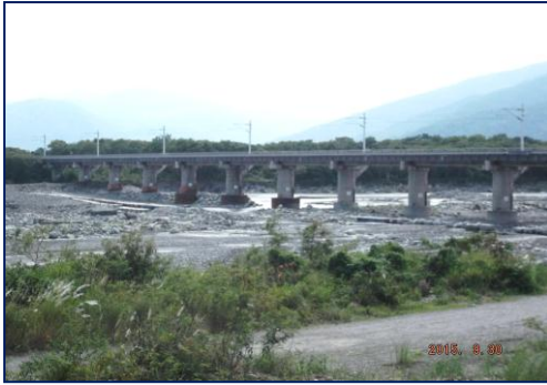
圖 1-4 沖刷型河系橋基裸露耐洪性不足之橋梁
