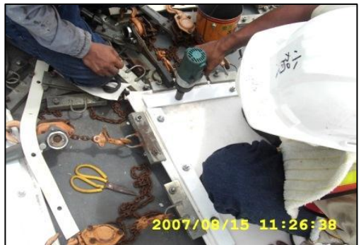
圖 3.12 步驟(6) 壓版鎖固
