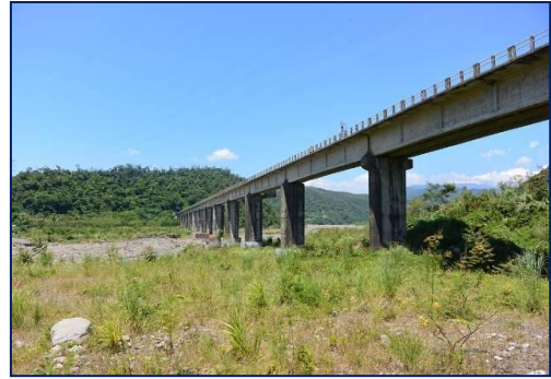
圖 1-4 沖刷型河系橋基裸露耐洪性不足之橋梁
