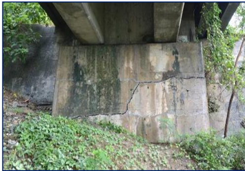
圖 1-1 混凝土劣化肇致鋼筋外露需辦理耐震補強之橋梁
