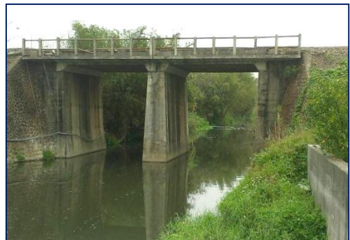
圖 1-2 縱向防落橋長度未符合耐震法規之橋梁
