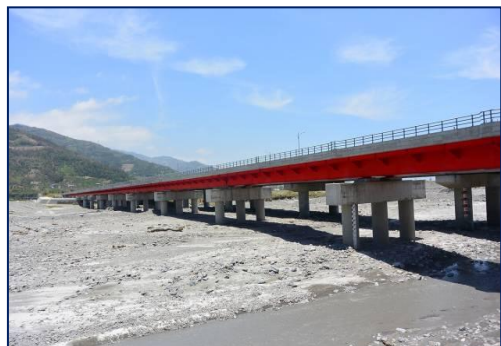
圖 1-3 橋柱表面鋼板包覆範圍未符合防洪耐撞之橋梁
