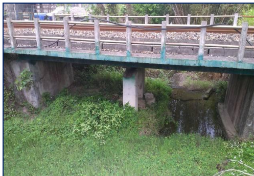
圖 1-2 縱向防落橋長度未符合耐震法規之橋梁
