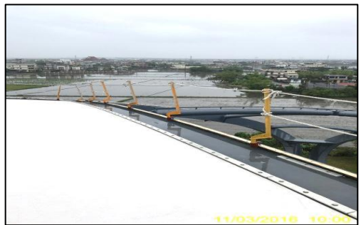
圖 3.14 局部雨棚修復完成(2)
