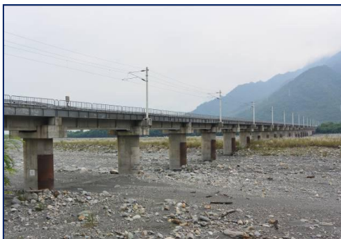
圖 1-3 橋柱表面鋼板包覆範圍未符合防洪耐撞之橋梁
