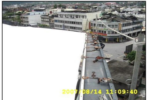
圖 3.10 步驟(4) 展膜後臨時固定
