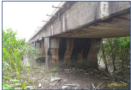
圖 1-1 混凝土劣化肇致鋼筋外露需辦理耐震補強之橋梁
