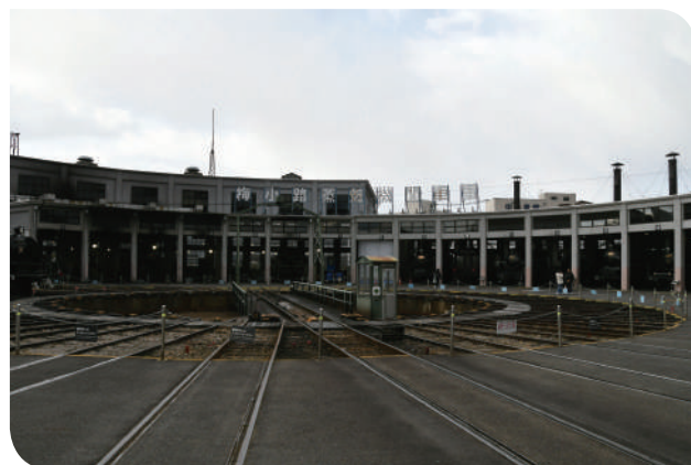
▲梅小路蒸氣機關車庫（扇形車庫）
