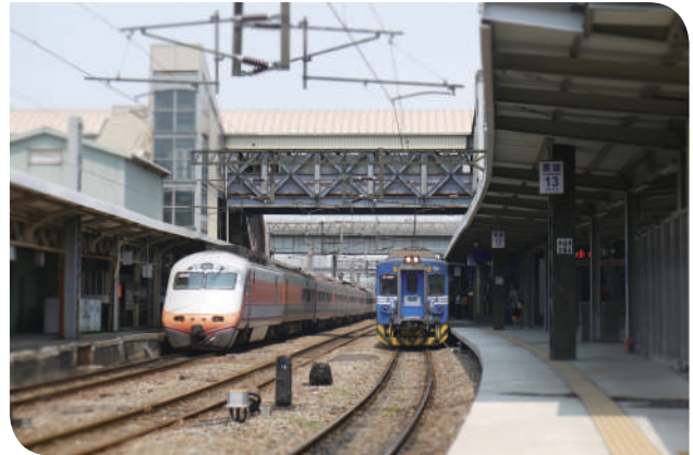
▲尚未地下化舊高雄火車站 - 股道一隅
