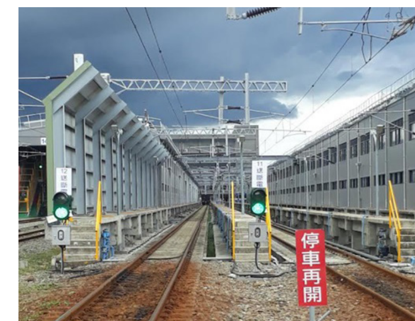
110 年 8 月 19 日請臺東機務段針對南迴鐵路電氣化造成工作環境改變做好變更管理，並吸收其他機務段預防感電之經驗，避免發生感電職災。
