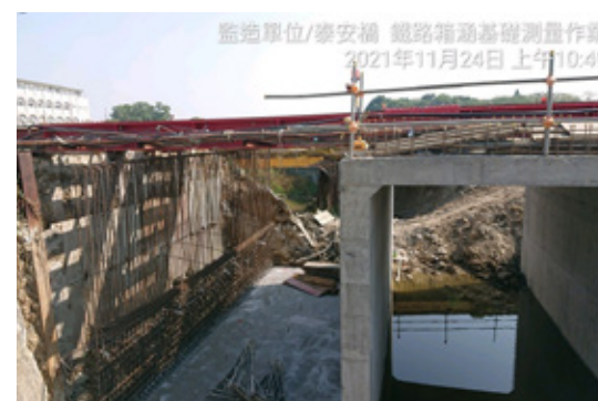
泰安橋之新設箱涵施工
