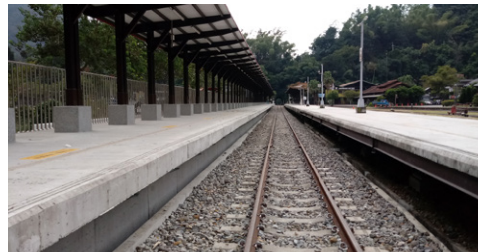
車埕站增設月台暨軌道強度提升工程
