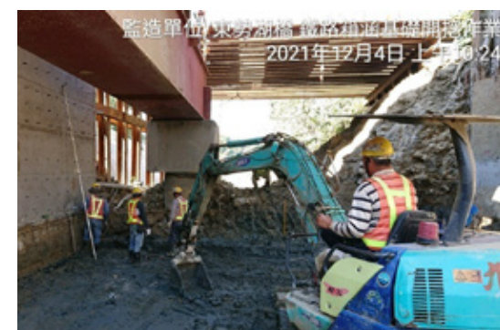
東勢湖橋之新設箱涵施工
