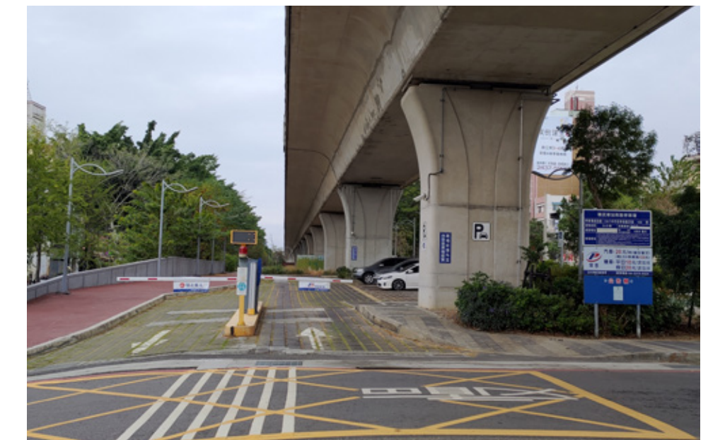
（臺中鐵路高架）精武車站停車場
