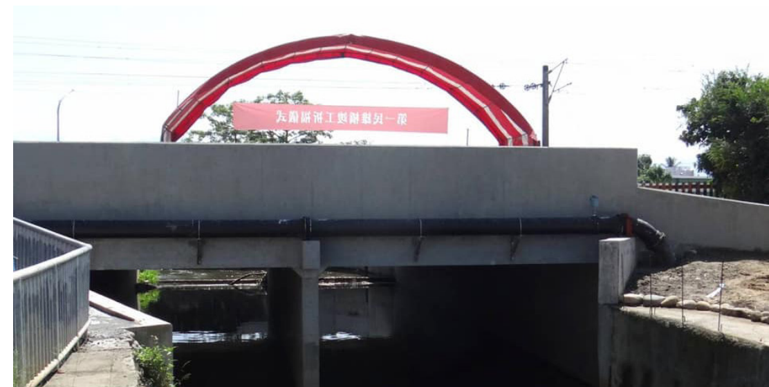
第一民雄橋完成
