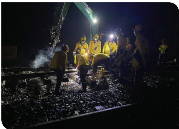
▲軌道切斷及鑽孔作業
