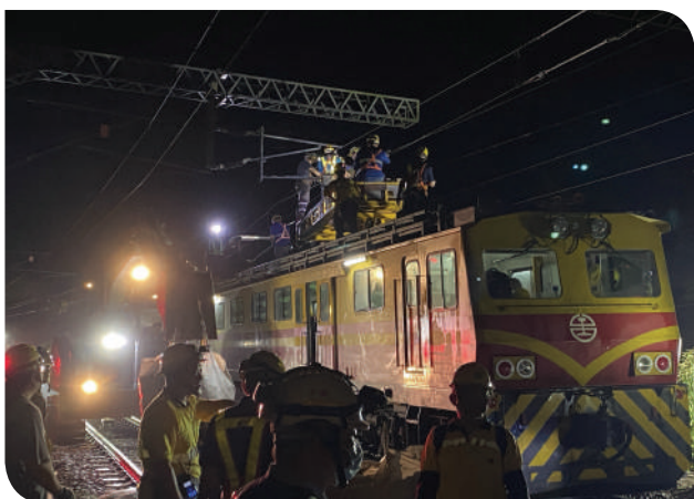
▲電力維修車進場執行新舊線銜接
