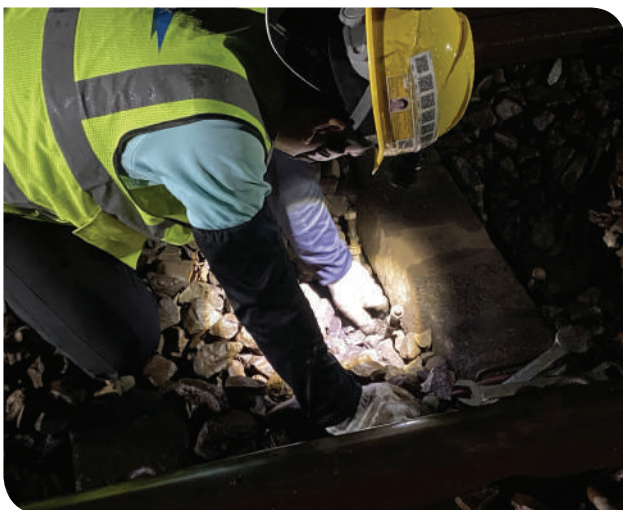
▲電務同仁取埋藏在道碴下的線路
