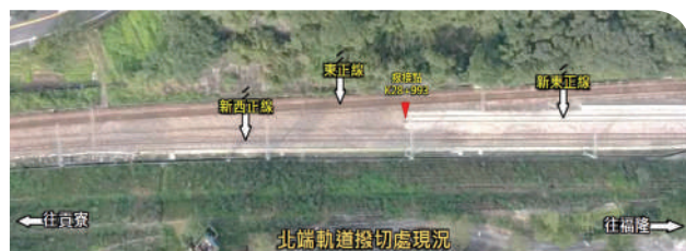
北端軌道撥切處現況
