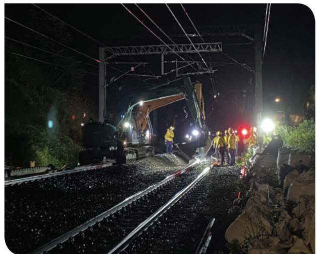
▲線型調整（彎道處外軌高度需較高，以抵抗輪軸離心力）
