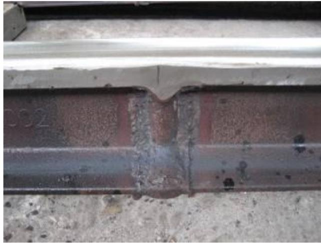
圖 4-33 UIC60 鋼軌鋁熱劑焊道圖 (宜工段)
