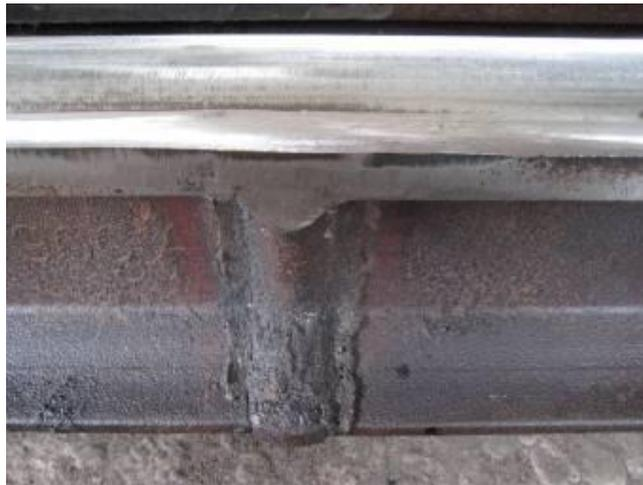
圖 4-39 UIC60 鋼軌鋁熱劑焊道圖 (東工段)
