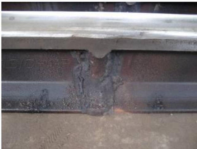
圖 4-36 UIC60 鋼軌鋁熱劑焊道圖（花工段）
