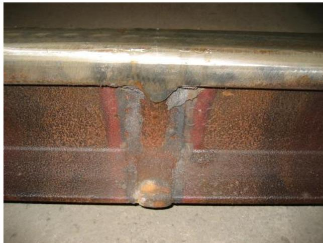
圖 4-24 UIC60 鋼軌鋁熱劑焊道圖（中工段）
