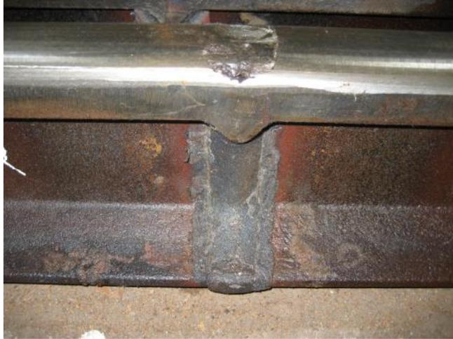
圖 4-16 UIC60 鋼軌鋁熱劑焊道圖 (漏漿)
