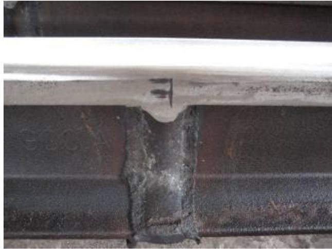
圖 4-21 UIC60 鋼軌鋁熱劑焊道圖 (北工段)
