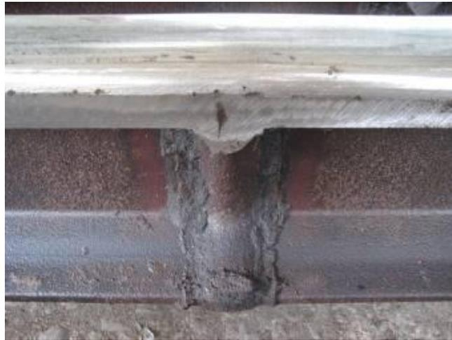
圖 4-27 UIC60 鋼軌鋁熱劑焊道圖 (嘉工段)
