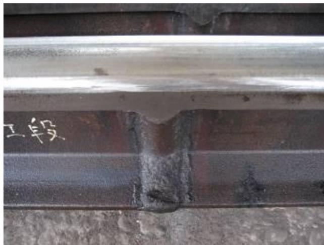
圖 4-30 UIC60 鋼軌鋁熱劑焊道圖（高工段）
